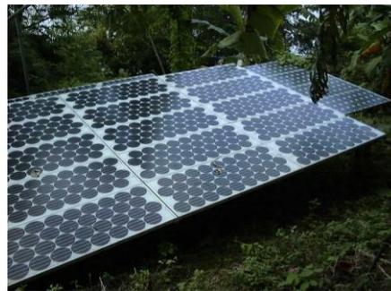
Figura 7.6 Paneles para máquina productora de hielo
