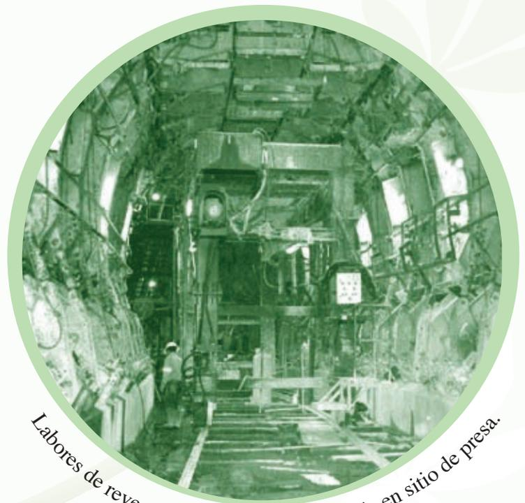
Labores de revestimiento en túnel de desvío en sitio de presa.
