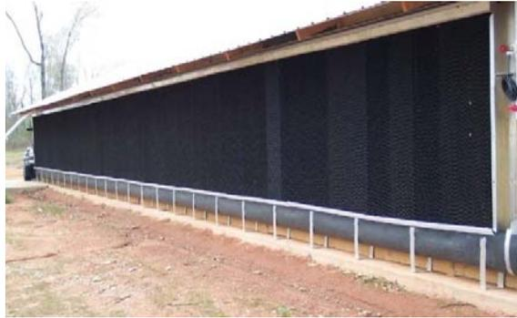
**Figura 3.7** Sistema de enfriamiento por pared húmeda [1]
