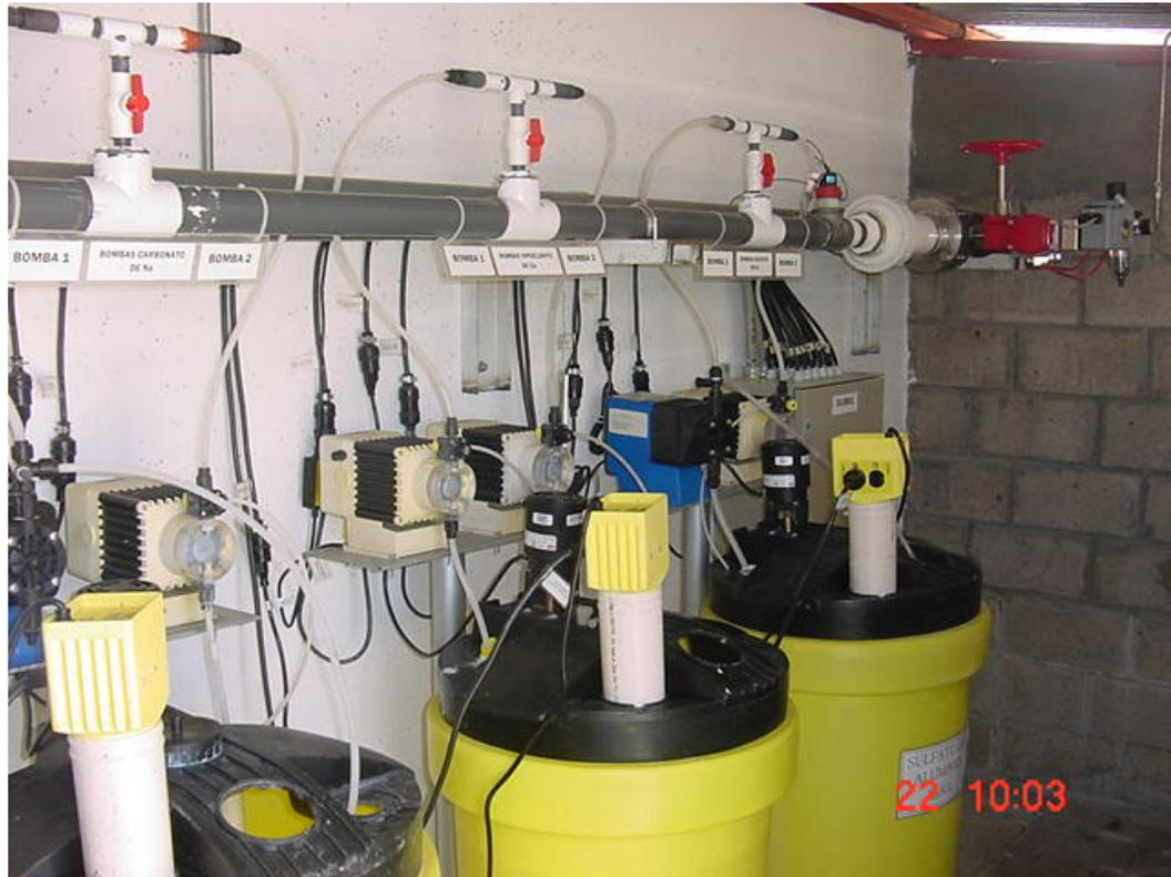
**Figura 6.2** Sistema de dosificación en línea
