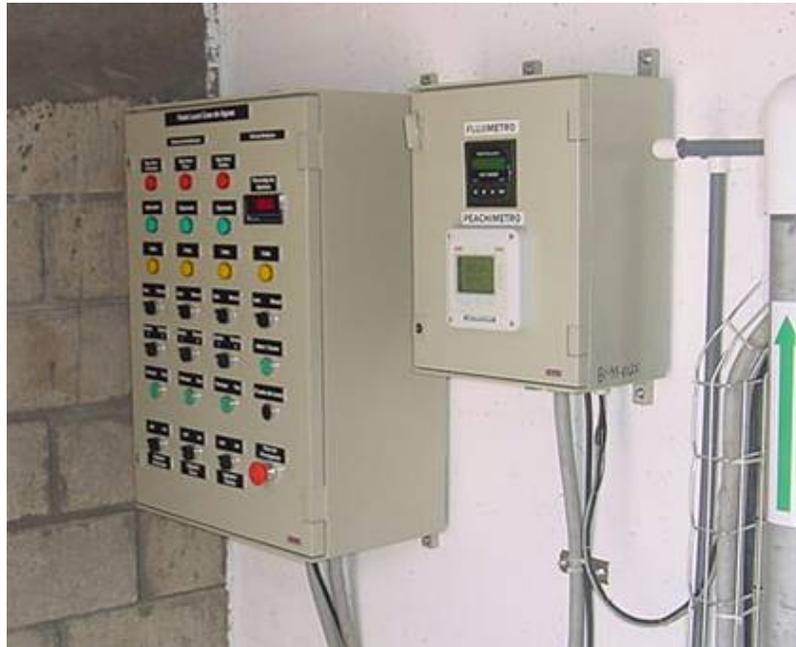
**Figura 6.3** Panel Loca junto a los medidores de flujo y pH
