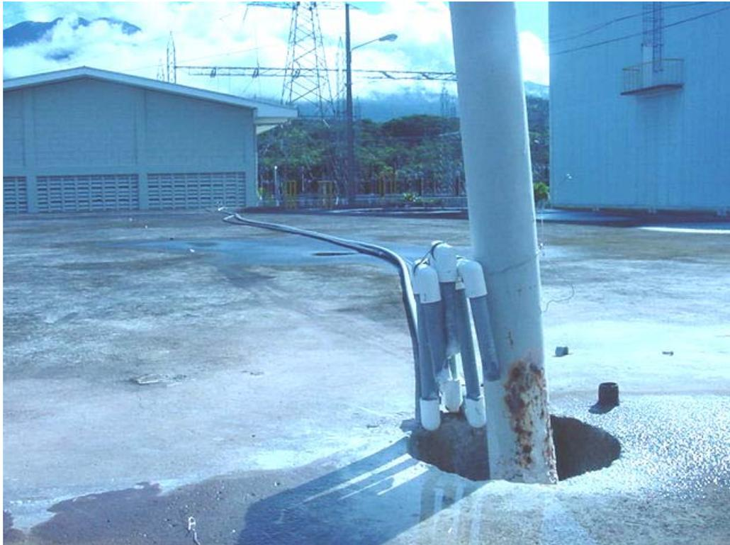
**Figura 3.2** Dosificación de químicos en el tanque de agua cruda en su antigua configuración
