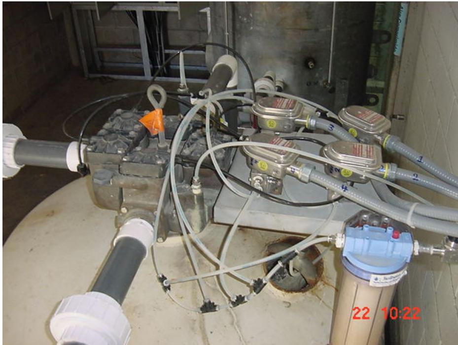
**Figura 6.1** Nuevo sistema de válvulas para el control del filtro de lecho múltiple
