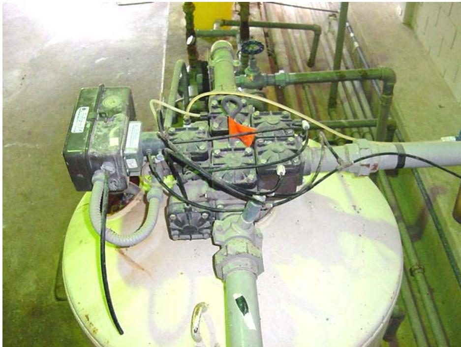
**Figura 3.8** Válvula multipuerta y "timer" del filtro de lecho múltiple
