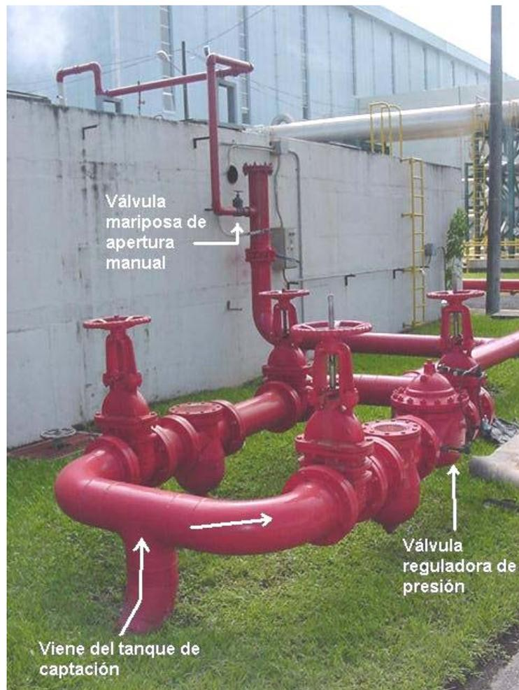
**Figura 3.1** Ingreso de agua al tanque de agua cruda en su antigua configuración
