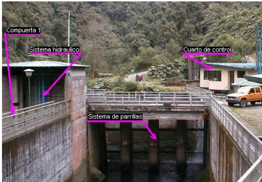
**Figura 1.11** Especificación de la localización de la caseta de control y compuerta 1 de toma Tapantí.
