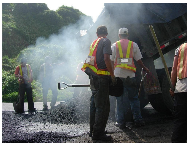
Figura 5: Paleros y rastrilleros durante la descarga de vagoneta con asfalto
