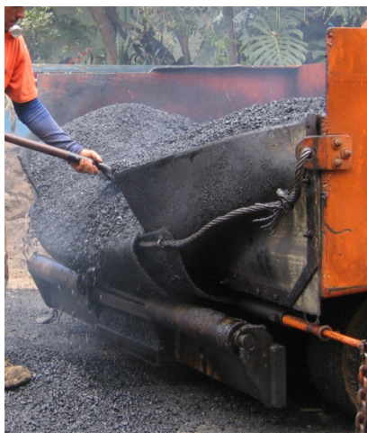
Figura 4: Palero descargando asfalto del Finisher
