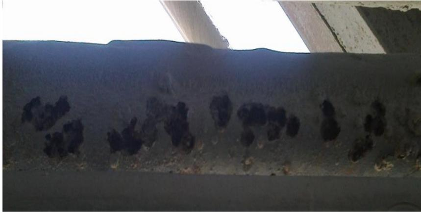
Figura 52. Tramo de la tubería con síntomas claros de corrosión.
