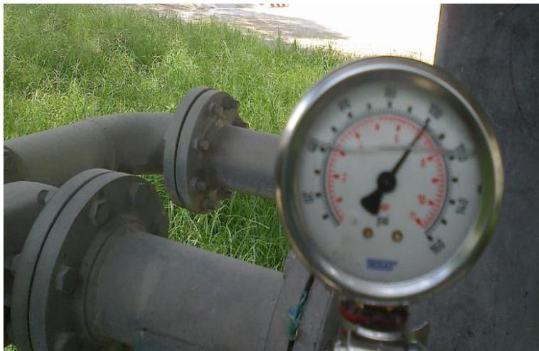
Figura 75. Medición de presión en puntos a la salida del acumulador cuarto compresores 1.
