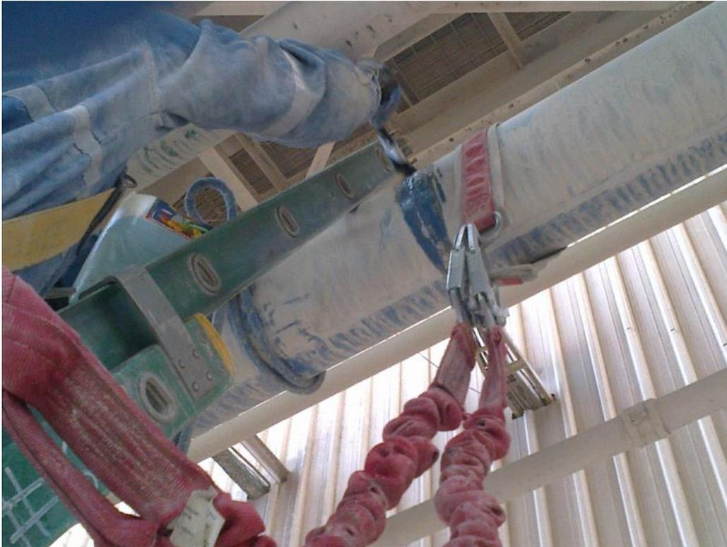
Figura 32. Aplicación de agua jabonosa a unión soldada
