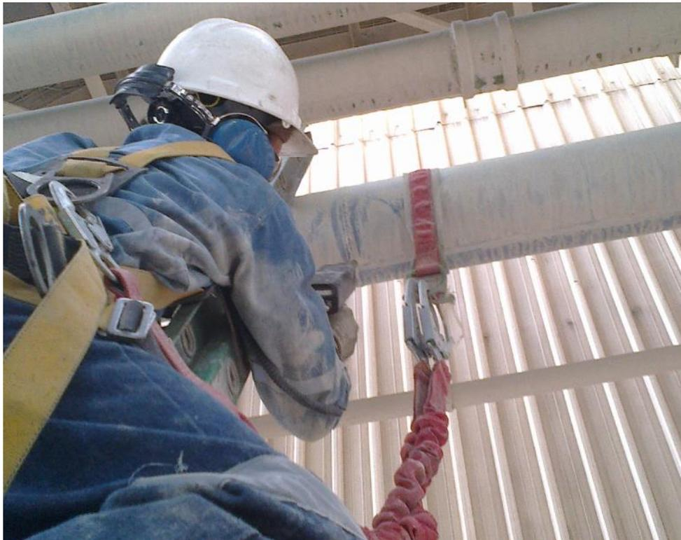
Figura 31. Detección de fugas en unión soldada con ultrasonido
