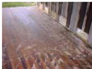
El miércoles 20 de diciembre del 2000 se realizó el trabajo de lijado y enmasillado del piso, ver Figura 33. El proceso de pulido y enmasillado se realiza en dos días debido a que la cola utilizada para el enmasillado es de secado lento.
