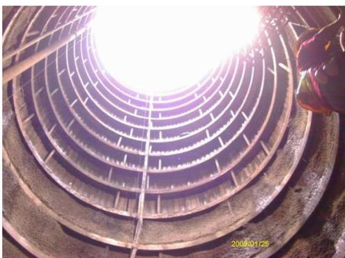
Ilustración 5. Soporte Pozo Tubería Forzada
