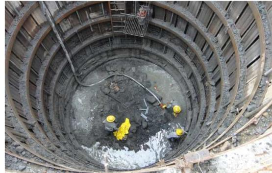
Ilustración 8. Colocación concreto lanzado. Pozo Aporte La Flor
