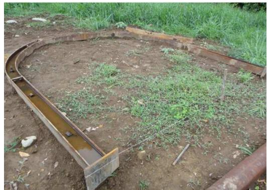
Ilustración 12. Arcos utilizados en Túnel Tubería Forzada
