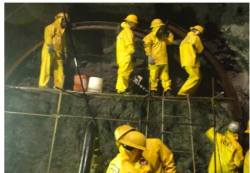
Ilustración 13. Colocación primer arco Túnel Tubería Forzada.
