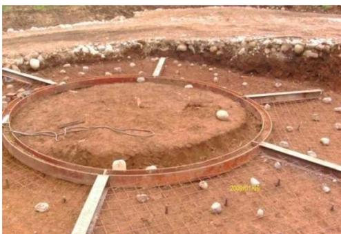
Ilustración 2. Primer anillo de Pozo Tubería Forzada.
