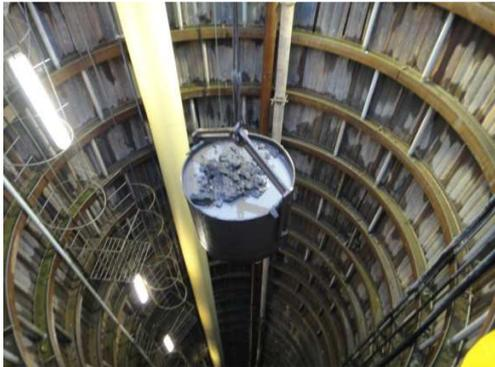
Ilustración 4. Balde en proceso de extracción. Pozo Tubería Forzada.
