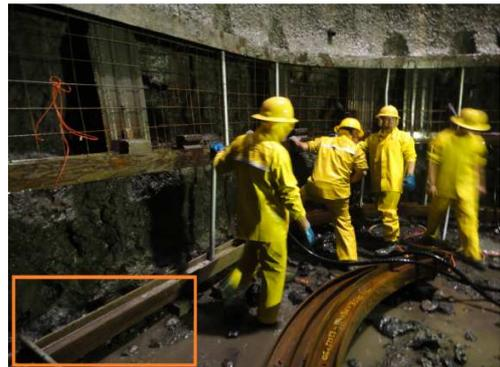
Ilustración 6. Soporte Pozo Tubería Forzada con vigas rectas (PI - 13).
