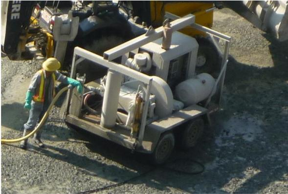
Figura 13. Hidrolavadora, utilizado en tratamiento de junta fría. Fotografía tomada el 11 de marzo del 2010 en el sitio de Presa del Proyecto Hidroeléctrico Pirris. Fuente: elaboración propia
