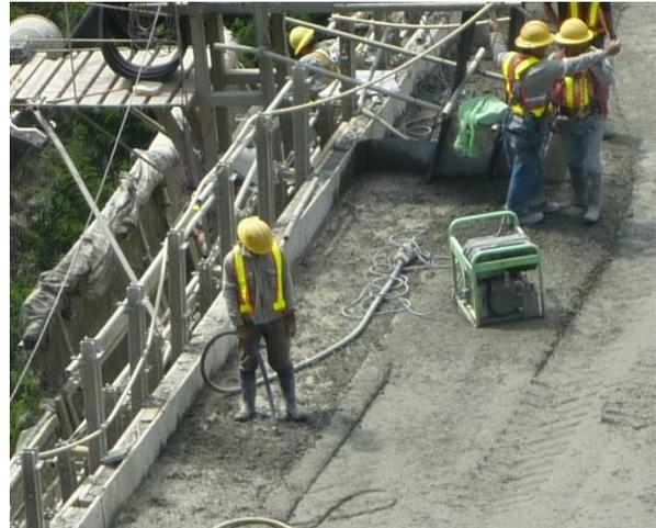
Figura 28. Trabajos de REL: Vibración manual. Fotografía tomada el 23 de marzo del 2010 en el sitio de Presa del Proyecto Hidroeléctrico Pirris. Fuente: elaboración propia
