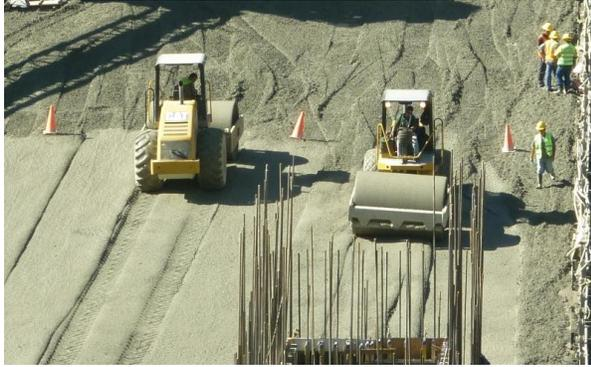
Figura 24. Compactador de Rodillo Liso Vibratorio. Fotografía tomada el 24 de marzo del 2010 en el sitio de Presa del Proyecto Hidroeléctrico Pirris. Fuente: elaboración propia
