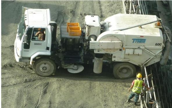
Figura 11. Camión aspiradora, utilizado en tratamiento de junta caliente. Fotografía tomada el 12 de marzo del 2010 en el sitio de Presa del Proyecto Hidroeléctrico Pirris. Fuente: elaboración propia
