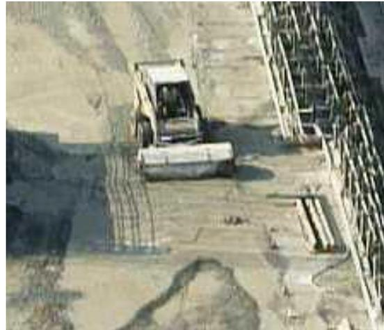
Figura 12. Equipo de cepillado industrial, utilizado en tratamiento de junta intermedia. Fotografía tomada el 10 de marzo del 2010 en el sitio de Presa del Proyecto Hidroeléctrico Pirris. Fuente: elaboración propia
