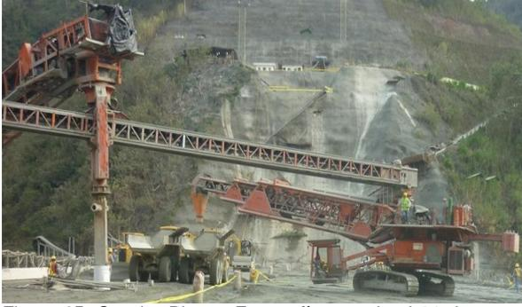
Figura 15. Crawler Placer. Fotografía tomada el 21 de enero del 2010 en el sitio de Presa del Proyecto Hidroeléctrico Pirris. Fuente: elaboración propia
