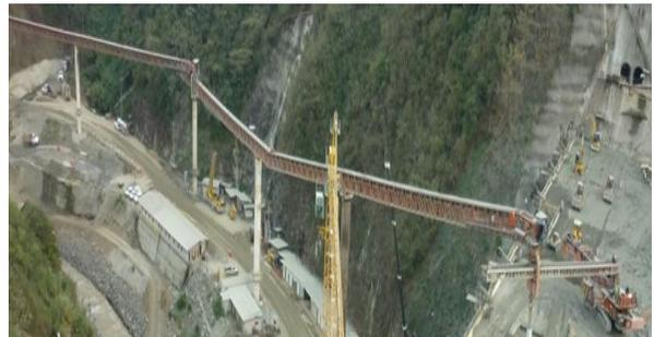
Figura 14. Banda transportadora ROTEC. Fotografía tomada el 21 de enero del 2010 en el sitio de Presa del Proyecto Hidroeléctrico Pirris. Fuente: elaboración propia
