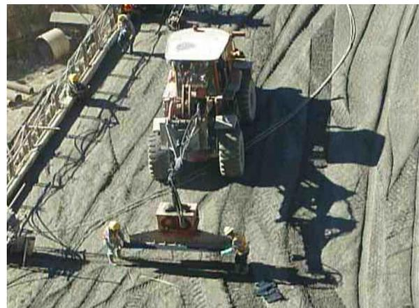
Figura 26. Equipo empleado en la inducción de juntas. Fotografía tomada el 24 de marzo del 2010 en el sitio de Presa del Proyecto Hidroeléctrico Pirris. Fuente: elaboración propia
