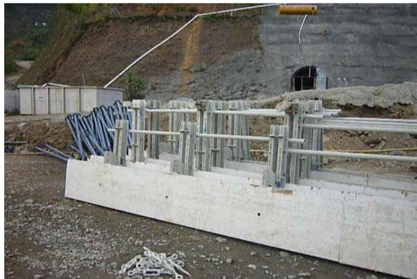
Figura 31. Formaleta mecánica utilizada. Fotografía tomada el 24 de febrero del 2010 en el sitio de Presa del Proyecto Hidroeléctrico Pirris. Fuente: elaboración propia
