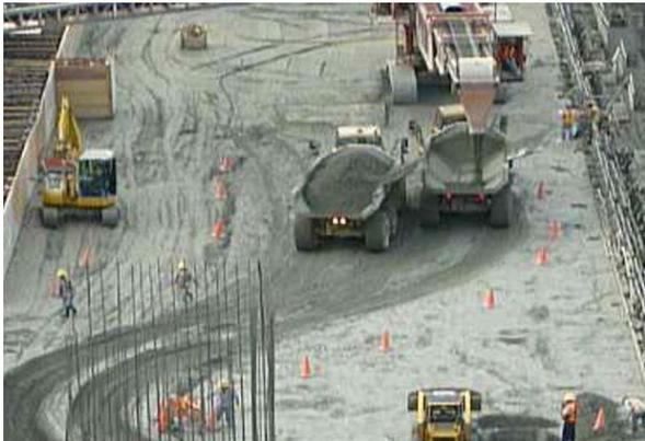
Figura 16. Descarga de material de Crawler Placer a Vagonetas. Fotografía tomada el 26 de febrero del 2010 en el sitio de Presa del Proyecto Hidroeléctrico Pirris. Fuente: elaboración propia
