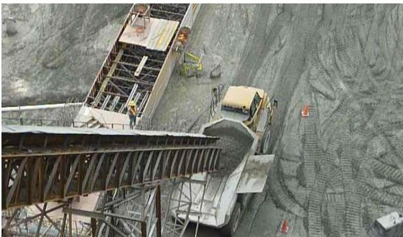
Figura 21. Carga de vagonetas mediante el "Chute". Fotografía tomada el 27 de febrero del 2010 en el sitio de Presa del Proyecto Hidroeléctrico Pirris. Fuente: elaboración propia
