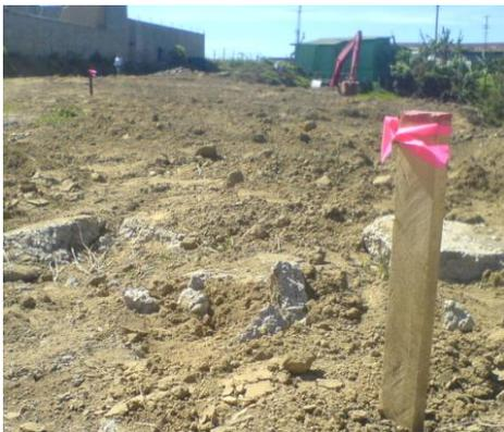
**Figura 39.** Estacas indicando la línea de excavación.
