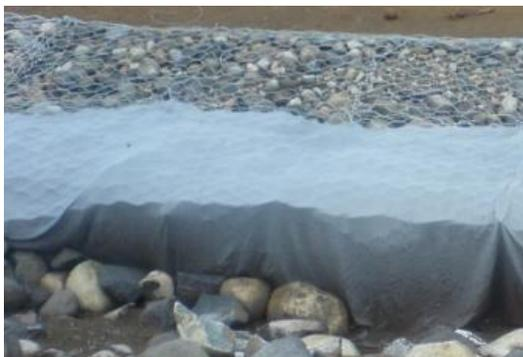
**Figura 48.** Geotextil en la espalda del muro.
