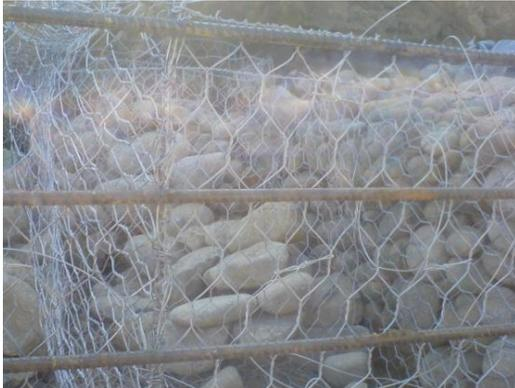
**Figura 47.** Formaleteo con varilla en la cara externa del muro.
