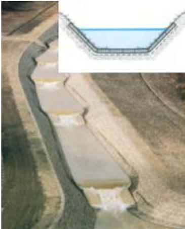
**Figura 34.** Canalización a base de colchones<sup>5</sup>.
