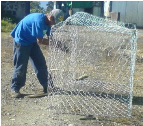
Figura 44. Armado de gaviones.
