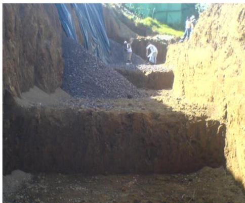
Figura 41. Distintos niveles de fundación del muro.
