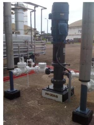
**Bomba PP-304-B:** Del 21 hasta el 24 de junio 2011. Se inicio con el mantenimiento de: limpieza, raspado, picado, cepillado y pintura. Se le dieron dos manos de pintura. El avance del trabajo es de 100 % hasta la fecha, con la (OT-340776).
