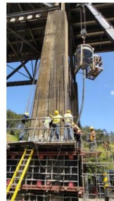
Figura 15. Colocación de concreto con el balde
