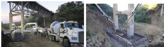
Figura 13. Colado mediante 2 bombas telescópica
