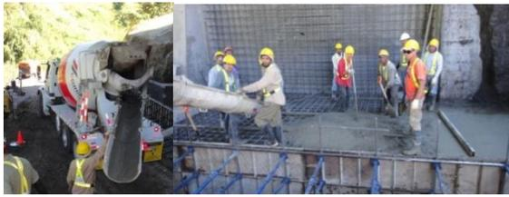
Figura 11. Colocación mediante descarga directa
