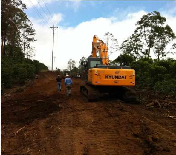
**Figura 61.** Conformación de la bancada, (Fuente: Autor)
