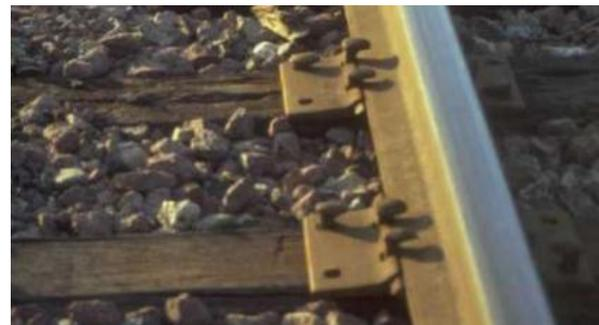
**Figura 28.** Detalle de sujeciones de placa con clavo de acero para durmientes de madera. (Fuente: Incofer)
