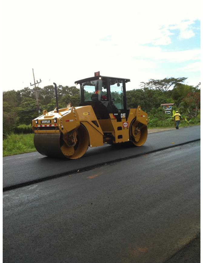
**Figura 36.** Compactación de la segunda capa con el equipo de doble tambor vibratorio.
