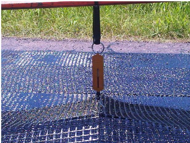
**Figura 32.** Prueba de adherencia realizada a la geomalla para poder proceder con la colocación de asfalto.
