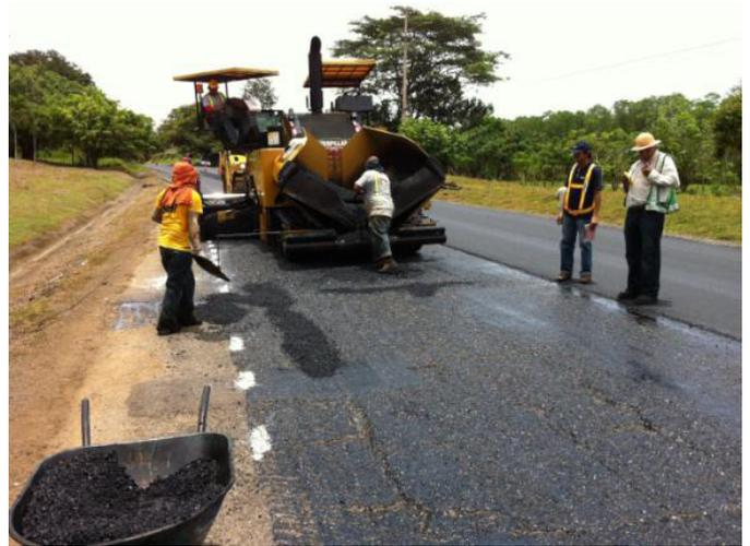
Figura 22. Bacheo con mezcla asfáltica.
