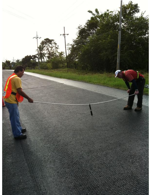
**Figura 33.** Prueba de adherencia realizada a la geomalla para poder proceder con la colocación de asfalto.
