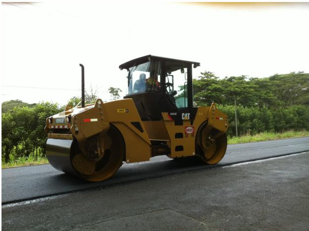
**Figura 25.** Compactación de la capa asfáltica con compactadora de doble tambor vibratorio.
