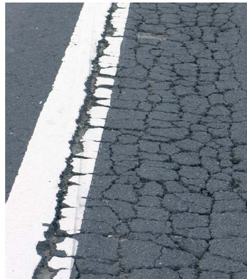
Figura 8: Agrietamiento de pavimento.
