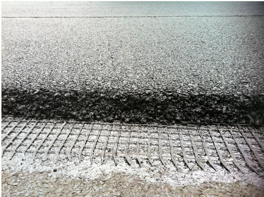
**Figura 1** Traslape de la geomalla en la junta longitudinal.
