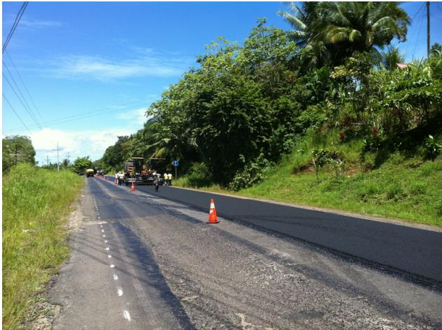
**Figura 24.** Pre nivelación de la superficie con 3cm de espesor de mezcla asfáltica.
