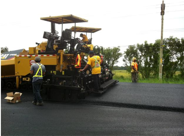
**Figura 34.** Colocación de la segunda capa de asfalto, ya sobre la geomalla.
