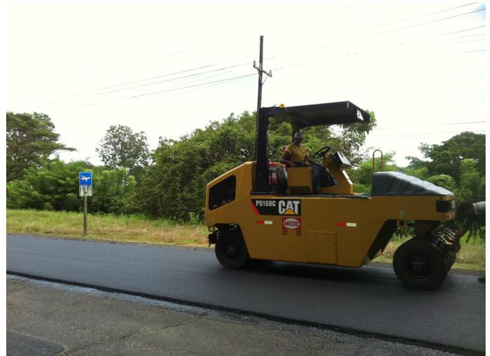
**Figura 26** Compactación de la capa asfáltica con compactadora de llantas de hule.
