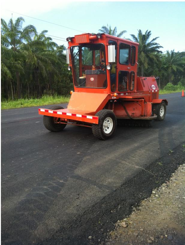
**Figura 28.** Barrido de la superficie antes del riego de emulsión.
