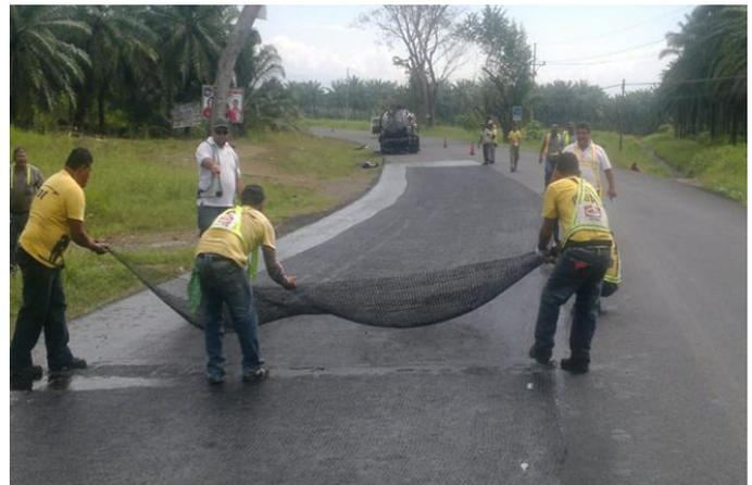
**Figura 30.** Colocación manual de la geomalla en el proyecto Esterillos-Lomas.
