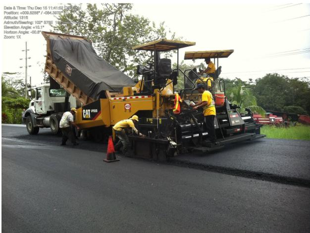
**Figura 35.** Colocación de la segunda capa de asfalto, ya sobre la geomalla.
