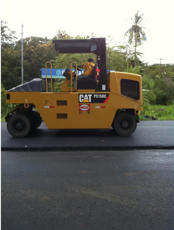
**Figura 37.** Compactación de la segunda capa con el equipo de llantas de hule.
