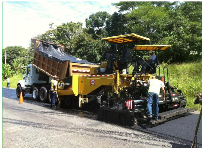
Figura 23. Pre nivelación de la superficie con mezcla asfáltica.
