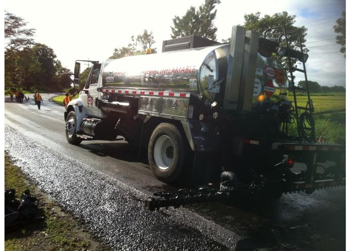
**Figura 29** Riego de la emulsión asfáltica
