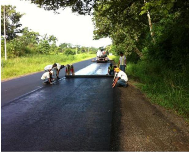
**Figura 31.** Colocación manual de la geomalla en el proyecto Esterillos-Lomas.
