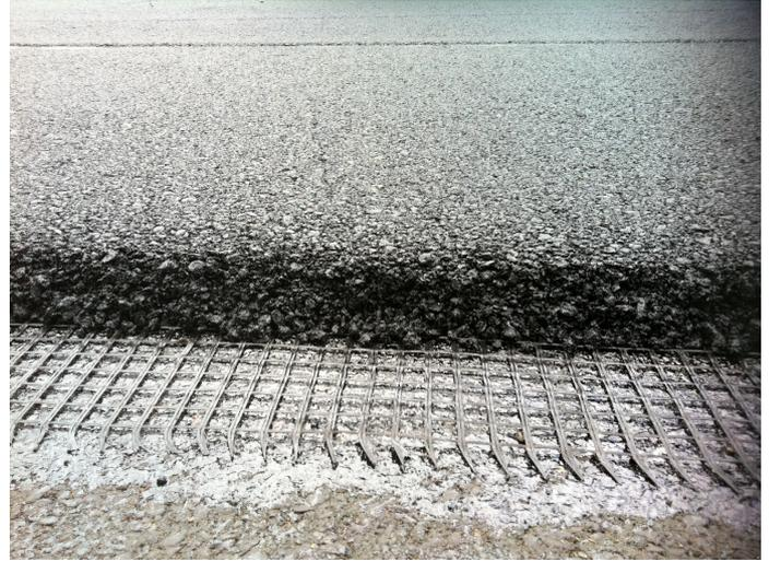
**Figura 38.** Traslape de la geomalla en la junta longitudinal.
