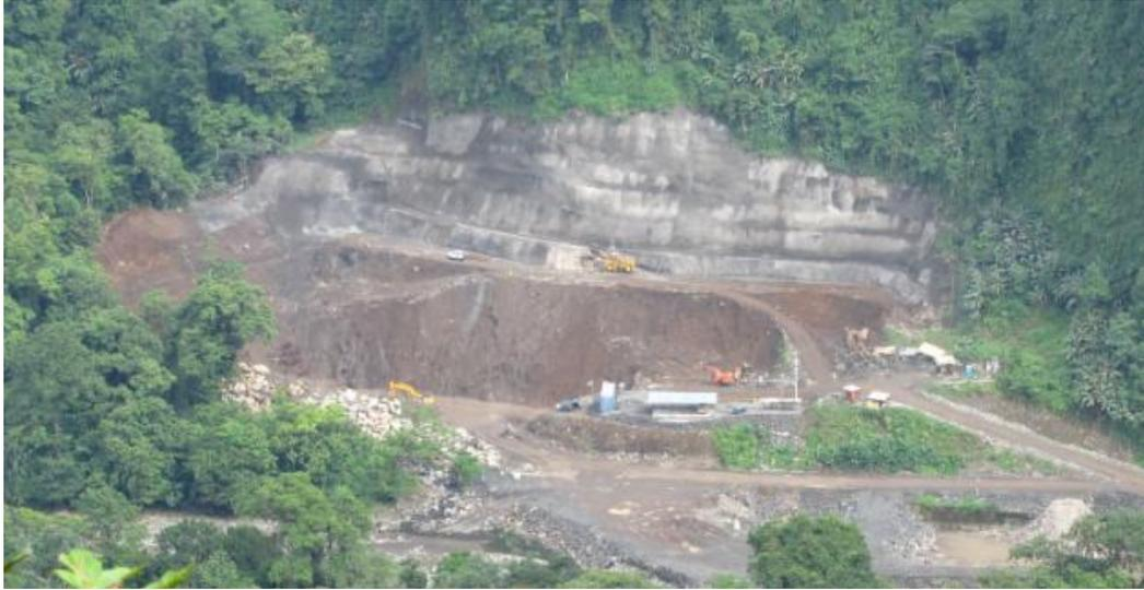
Figura 13. Trabajos de excavación y estabilización de taludes a túneles de desvío.
