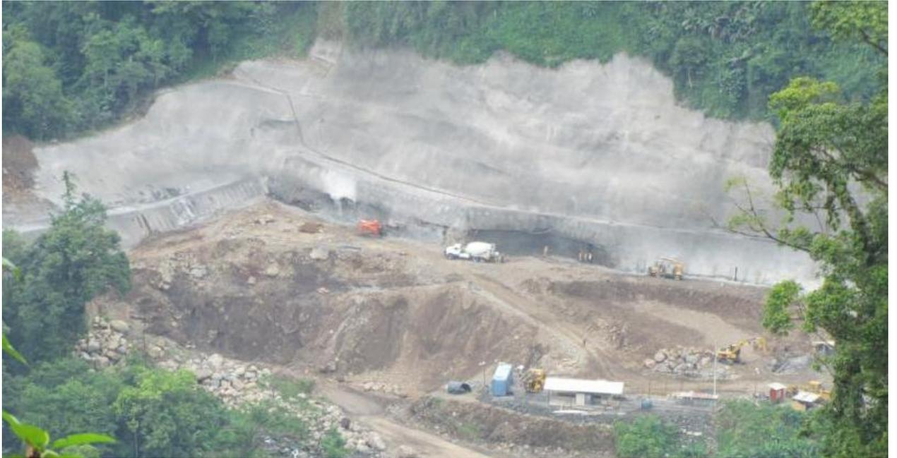
Figura 15. Trabajos de excavación y estabilización de taludes a túneles de desvío.
