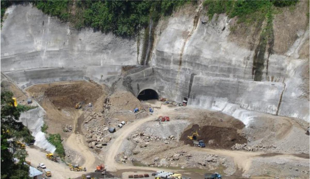
Figura 31. Trabajos de excavación y estabilización de taludes a túneles de desvío
