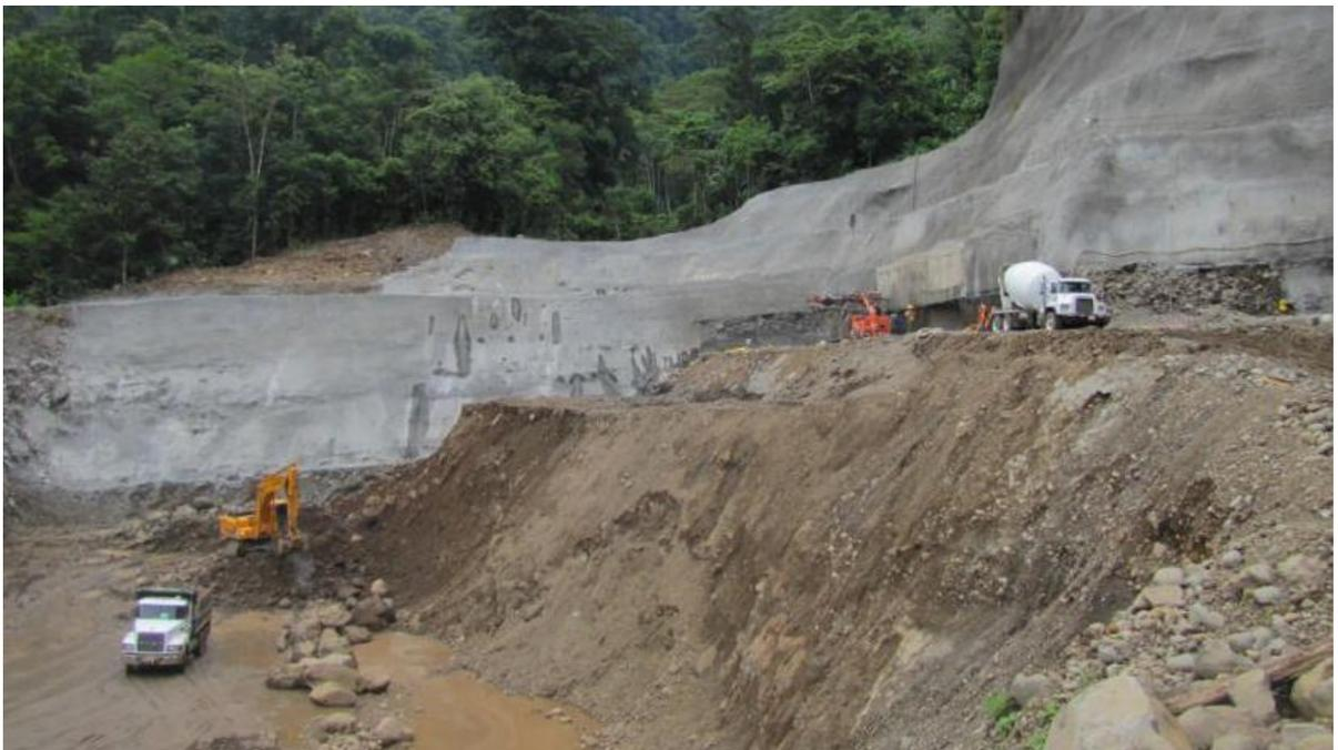
Figura 20. Trabajos de excavación y estabilización de taludes a túneles de desvío.
