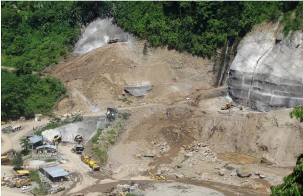
Figura 23. Trabajos de excavación y estabilización de taludes a túneles de desvío.
