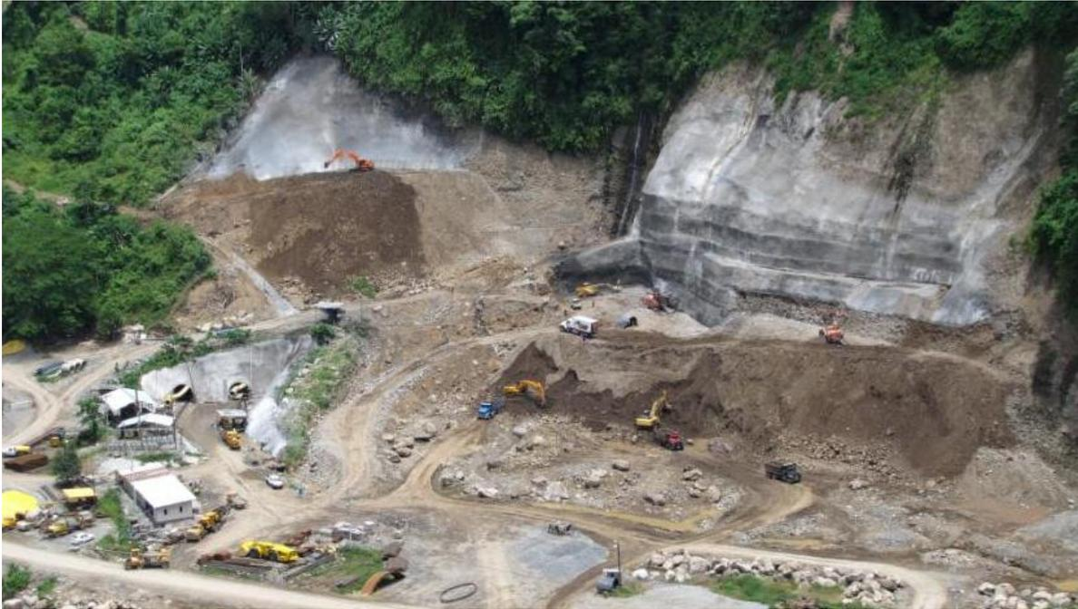
Figura 25. Trabajos de excavación y estabilización de taludes a túneles de desvío.
