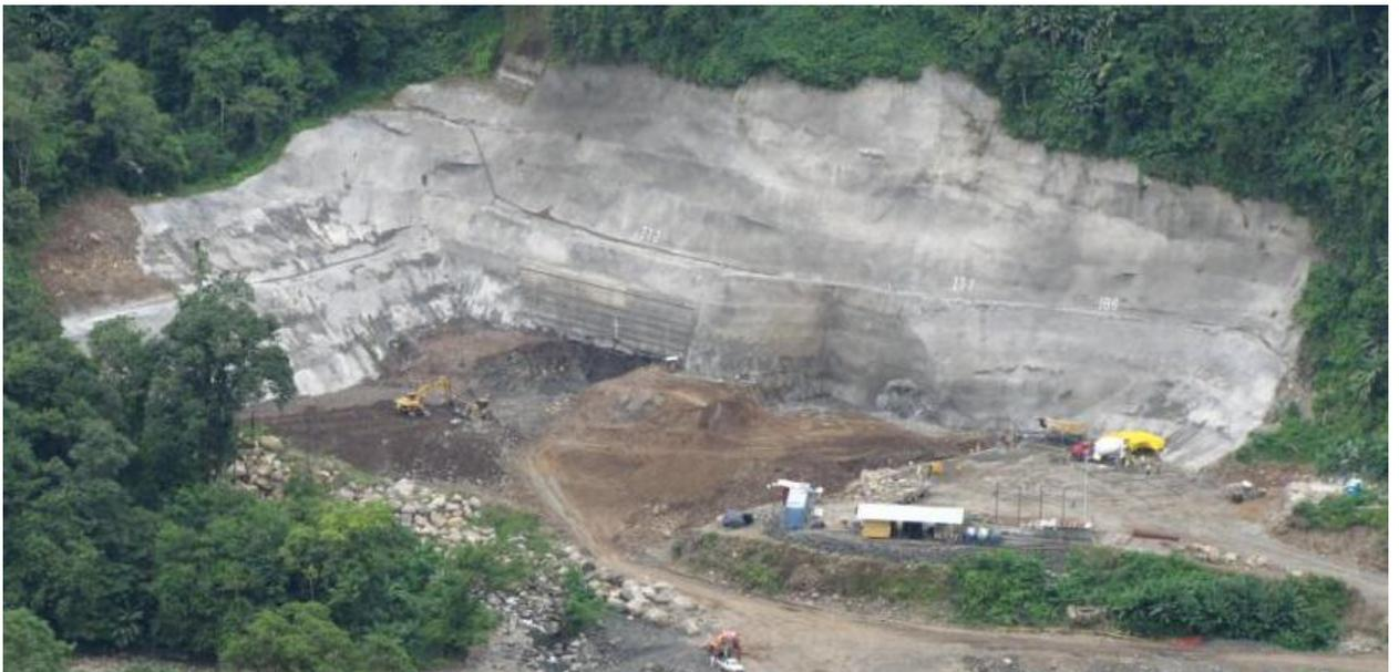
Figura 22. Trabajos de excavación y estabilización de taludes a túneles de desvío.
