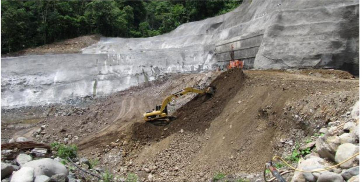
Figura 21. Trabajos de excavación y estabilización de taludes a túneles de desvío.
