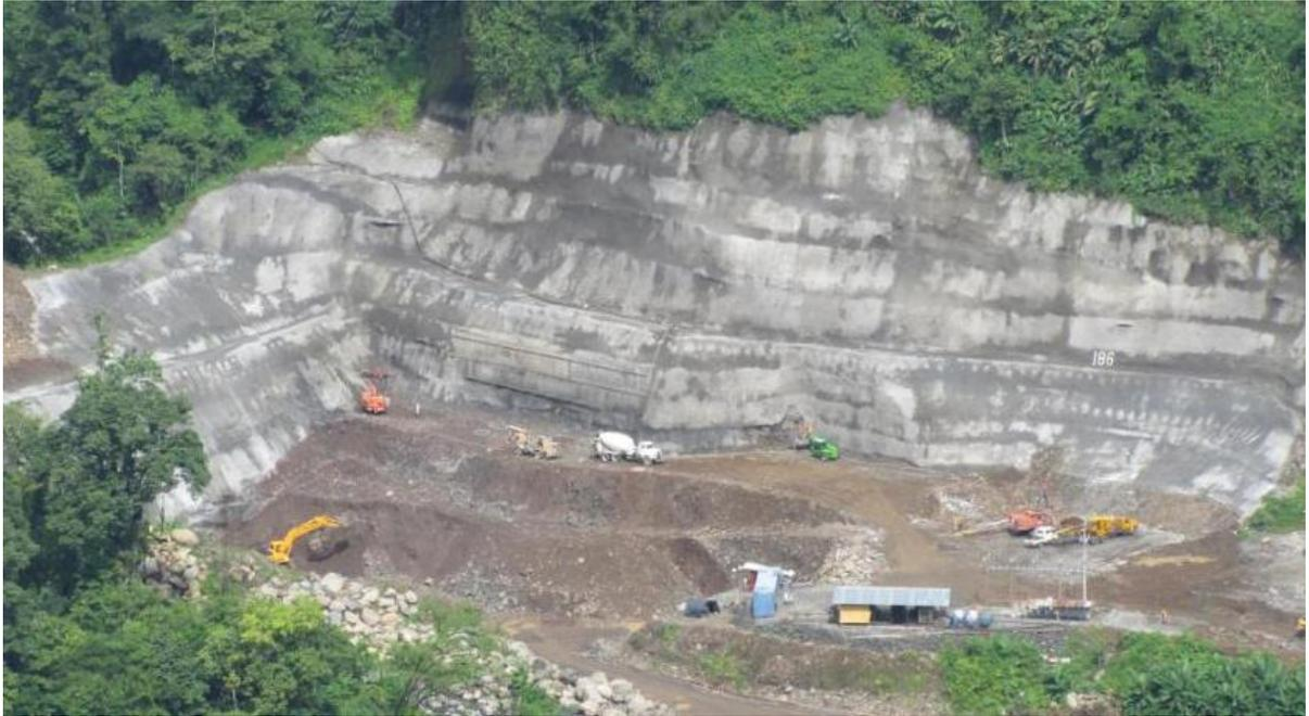
Figura 19. Trabajos de excavación y estabilización de taludes a túneles de desvío.
