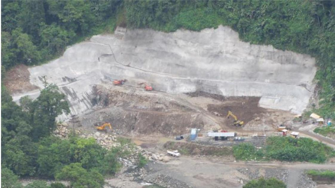
Figura 17. Trabajos de excavación y estabilización de taludes a túneles de desvío.
