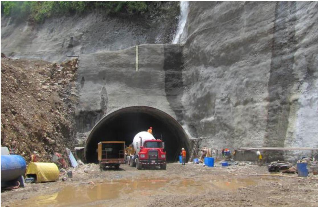
Figura 30. Colocación de concreto lanzado.
