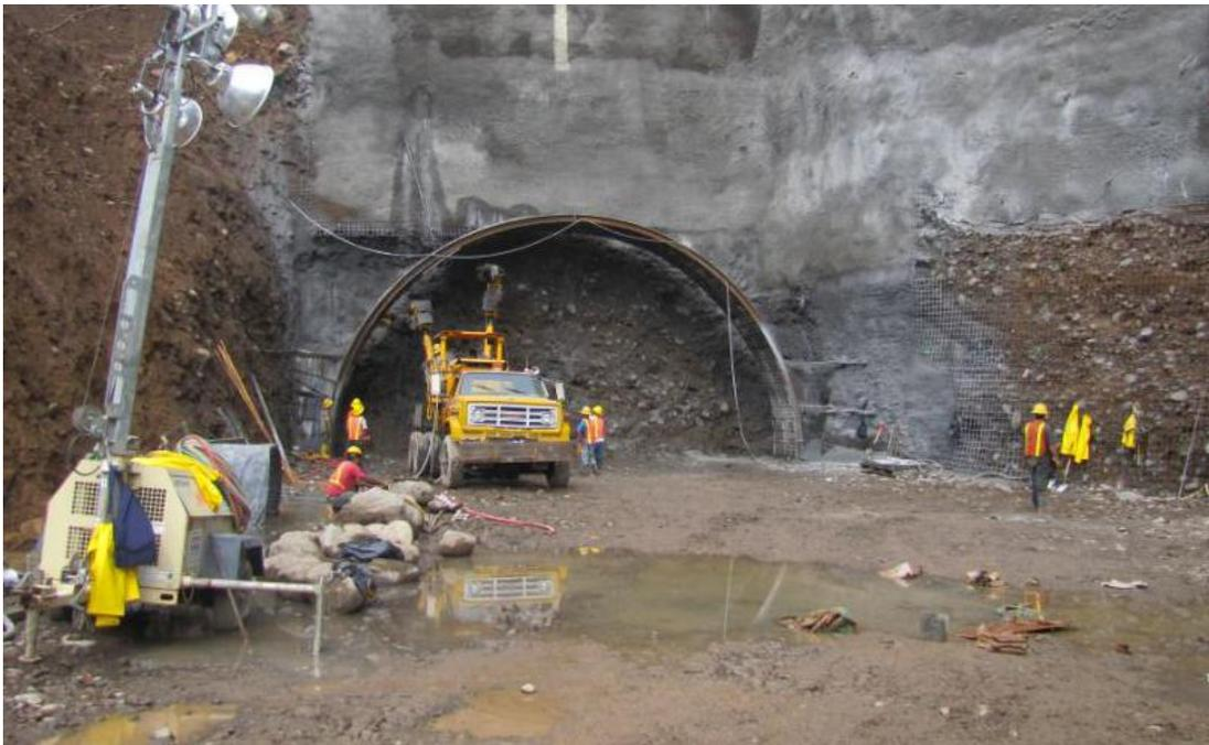
Figura 28. Trabajos en el portal de salida, colocación de arcos de acero.
