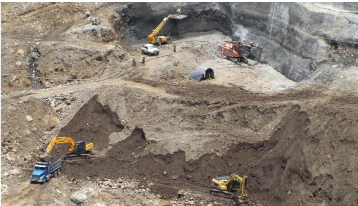
Figura 26. Trabajos de excavación y estabilización de taludes a túneles de desvío.
