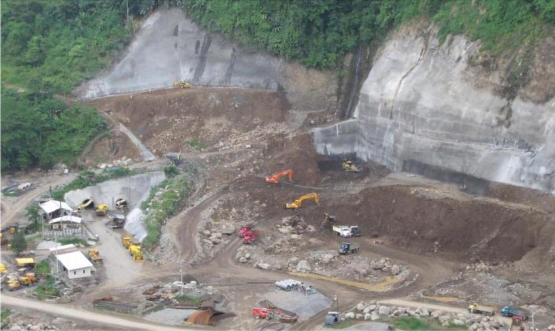
Figura 27. Trabajos de excavación y estabilización de taludes a túneles de desvío
