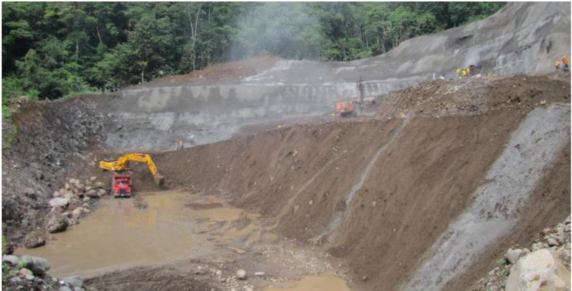
Figura 18. Trabajos de excavación y estabilización de taludes a túneles de desvío.
