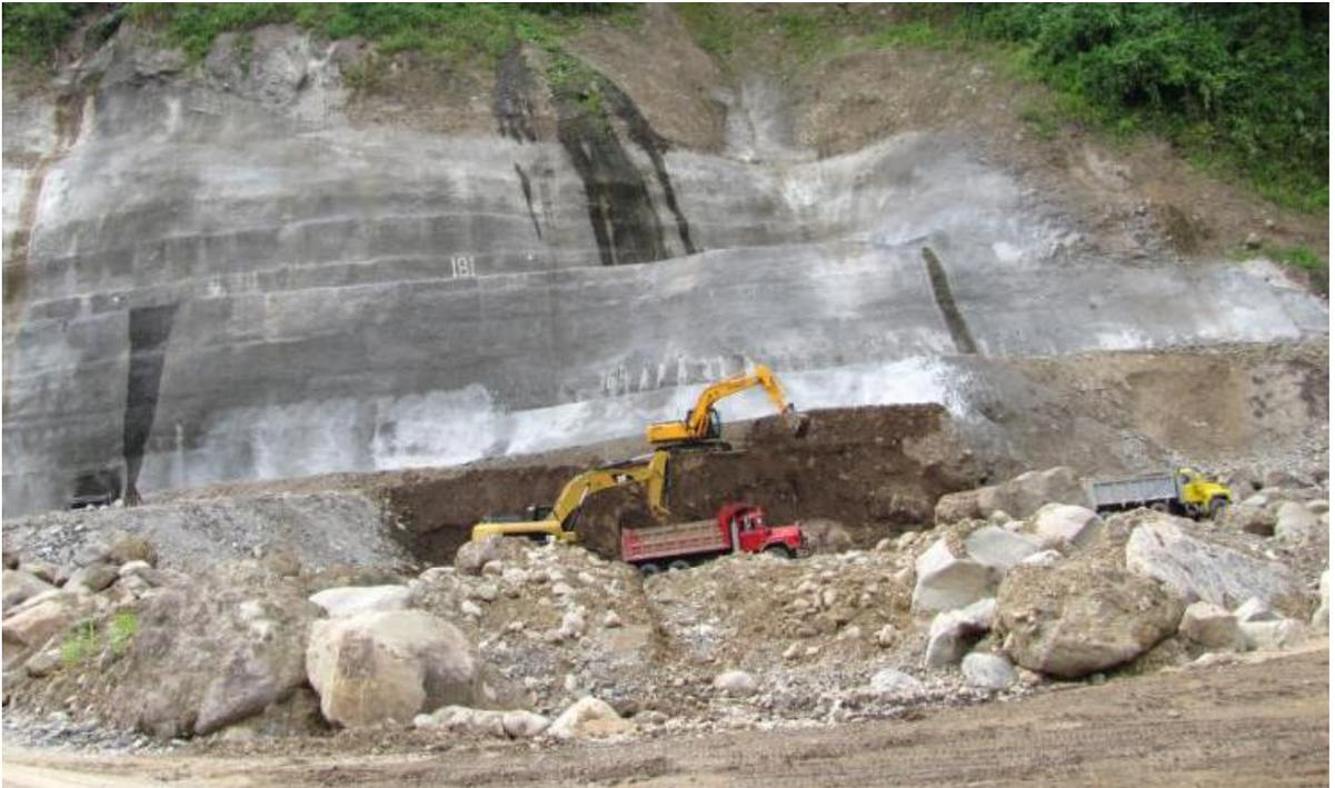
Figura 32. Trabajos de excavación y estabilización de taludes a túneles de desvío
