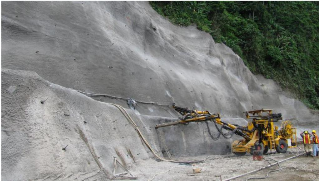
Figura 14. Perforación y colocación de pernos y drenaje.
