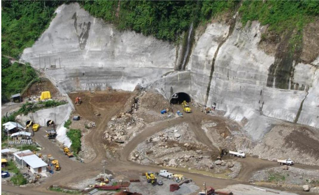
Figura 33. Trabajos de excavación y estabilización de taludes a túneles de desvío.
