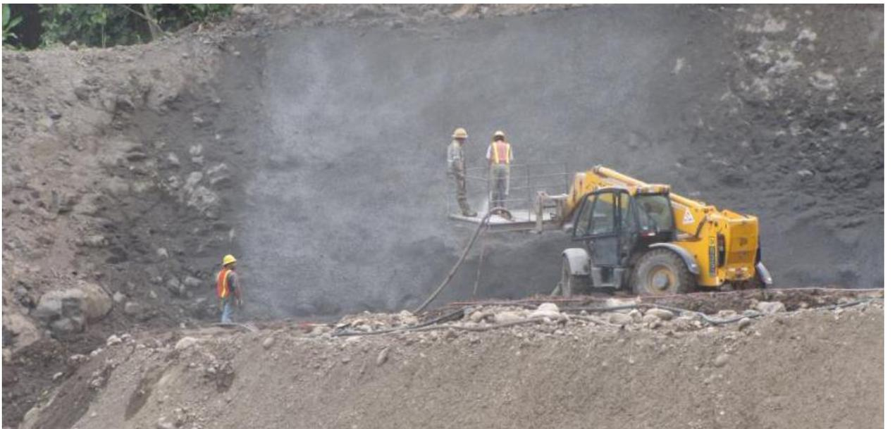
Figura 16. Colocación de concreto lanzado.
