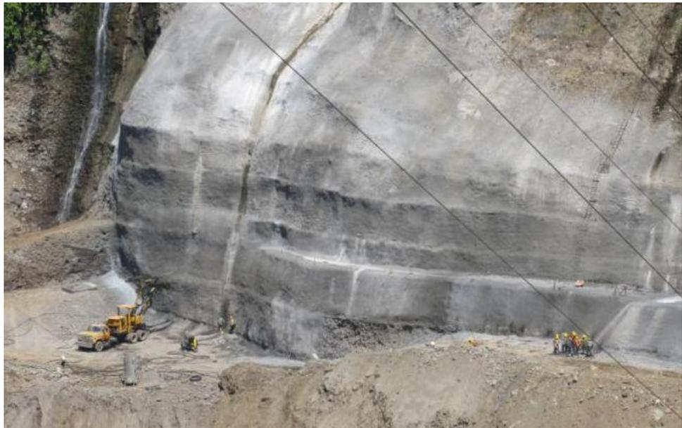
Figura 24. Perforación y colocación de pernos y drenaje.
