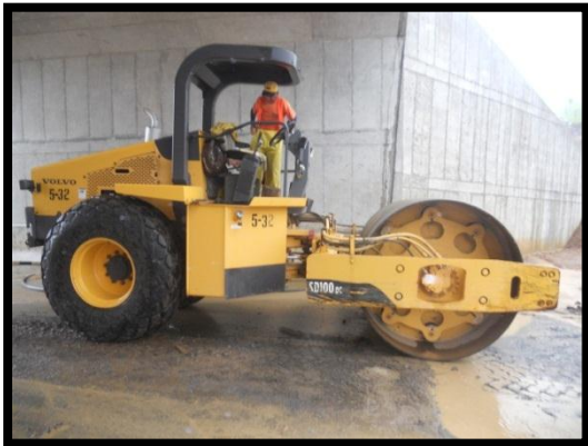
Figura 26. Compactadoras empleadas en la actividad de Colocación de Material de Préstamo.
