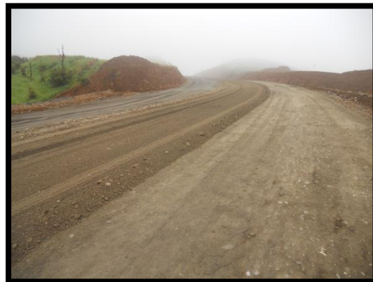
Figura 29. Tramo del Proyecto durante el proceso de colocación de material de préstamo.
