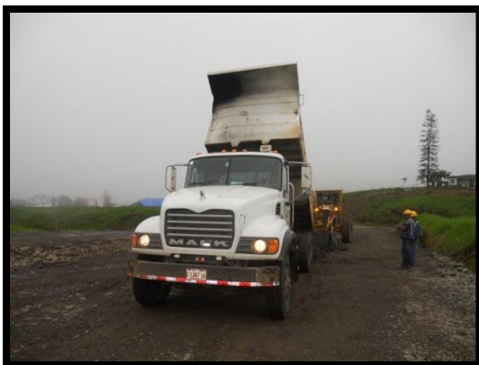
Figura 24. Vagonetas empleadas en la actividad de Colocación de Material de Préstamo.
