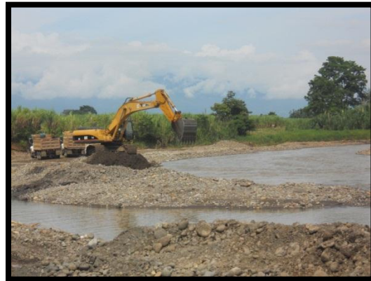
Figura 28. Excavadoras empleadas en la actividad de Colocación de Material de Préstamo.
