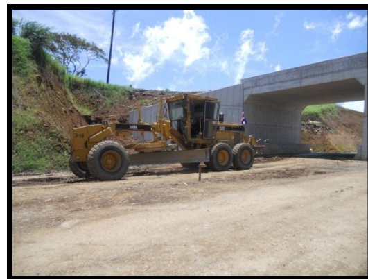
Figura 25. Niveladoras empleadas en la actividad de Colocación de Material de Préstamo.
