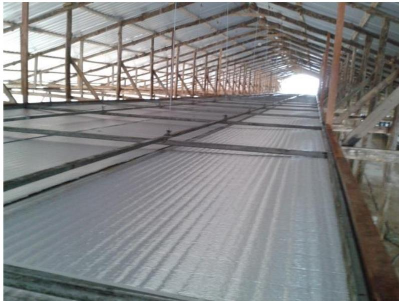
Figura 4.22 Instalación de techo falso en granja avícola.
