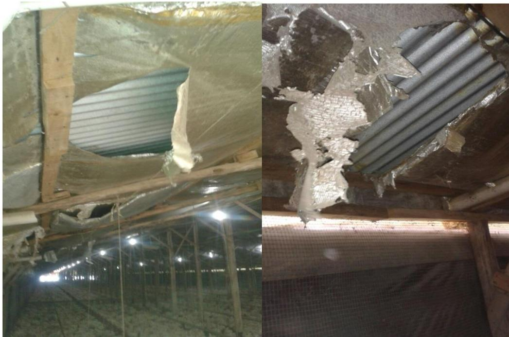
Figura 4.6 Estado del aislante en galpones 1,2 y 3 de la granja.
