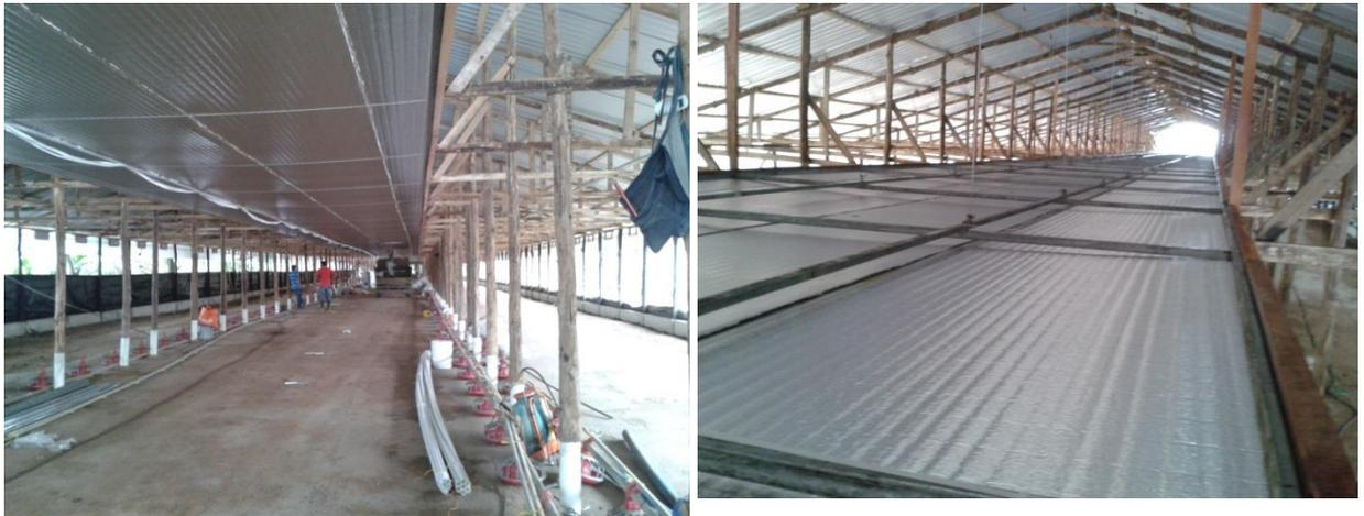
Figura A9.12.1 Instalación de techo falso en granja avícola en Río Cuarto
