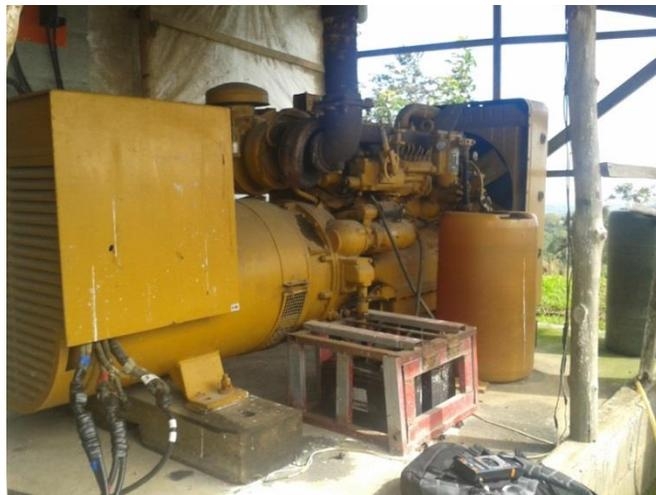
Figura 4.18 Planta de emergencia Caterpillar D333 de 125 kW.
