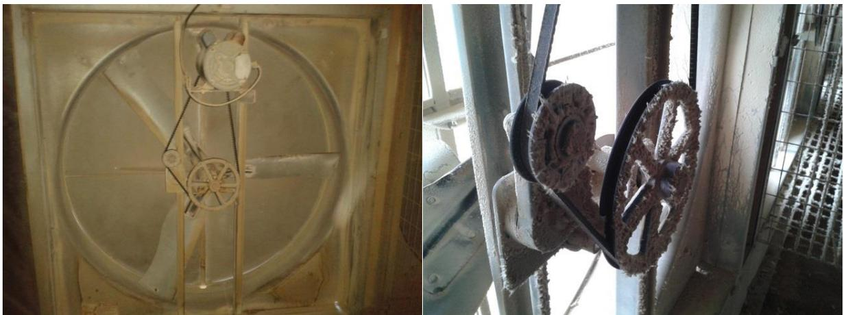
Figura 4.16 Extractor Marathon Electric monofásico de 1,12 kW y detalle de sistema tensor.
