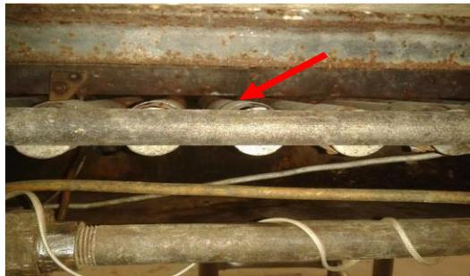
Se procede a un chequeo del sistema eléctrico de encendido de equipo, que la termopila funcione adecuadamente y que se encienda la llama piloto, de no funcionar correctamente se procede con la reparación, en caso de que la termopila esté dañada por desgaste se indica en la ficha de condiciones de equipos, para su posterior sustitución.
