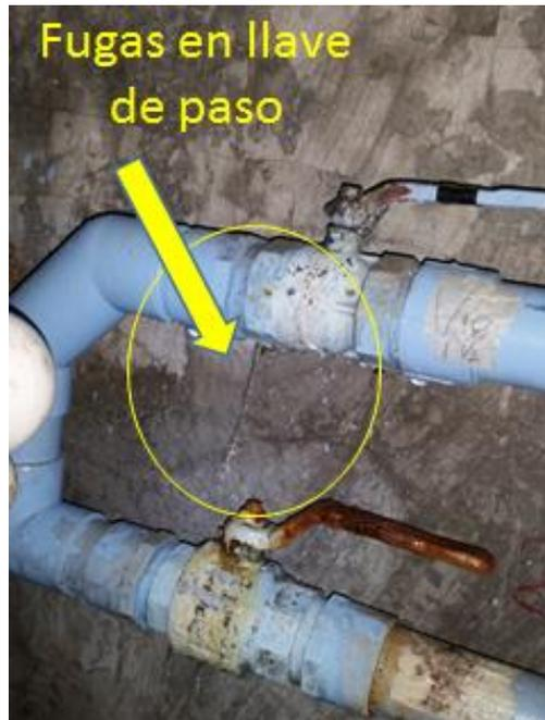
*Figura 20 Fuga de agua en llave de paso.*
