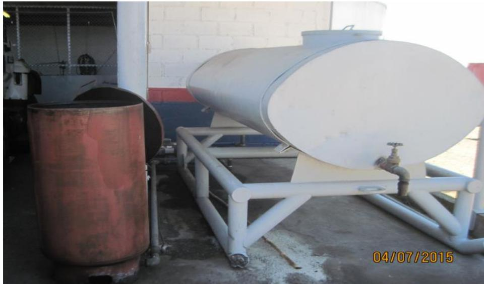
**Figura 20. Tanque de almacenamiento de aceites de desecho Taller Automotriz**
