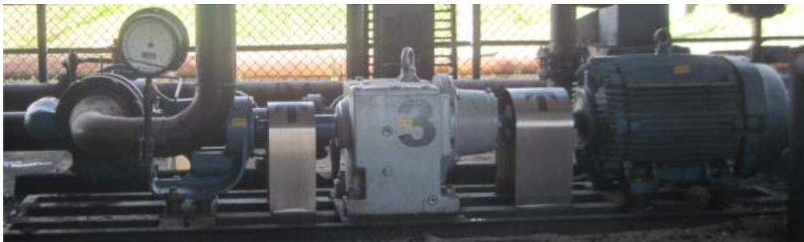
**Figura 8. Conjunto de motor, reductor y bomba**
