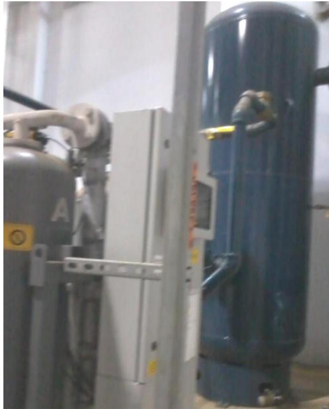
Figura 4. 11. Depósito de aire de 4000 litros.
