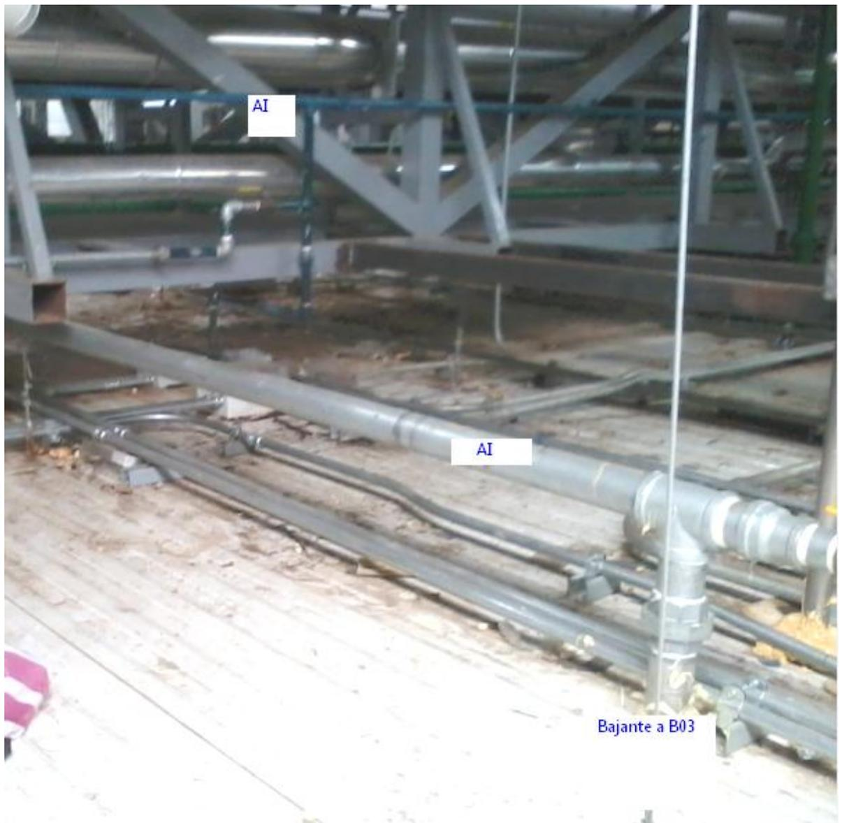
Figura 4.13. Tubería de la red de aire comprimido.
