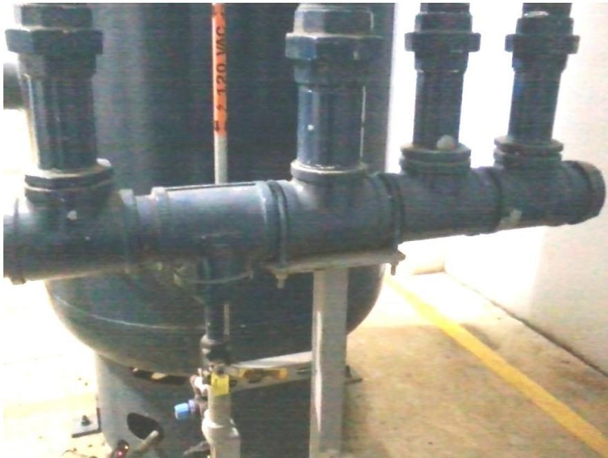
Figura 4.12. Tubería instalada en la red de aire comprimido. Salida de tanque pulmón.
