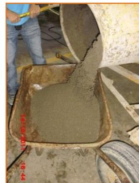
Figura 7. Preparación de la mezcla en una mezcladora con capacidad de 50 litros
