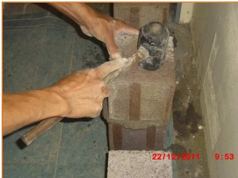
Figura 20. Construcción de los prismas
