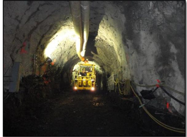
**Figura 5.** Frente de túnel en construcción en proyecto Balsa Inferior de la CNFL, similar al requerido en la toma de aguas para hacer bypass.
