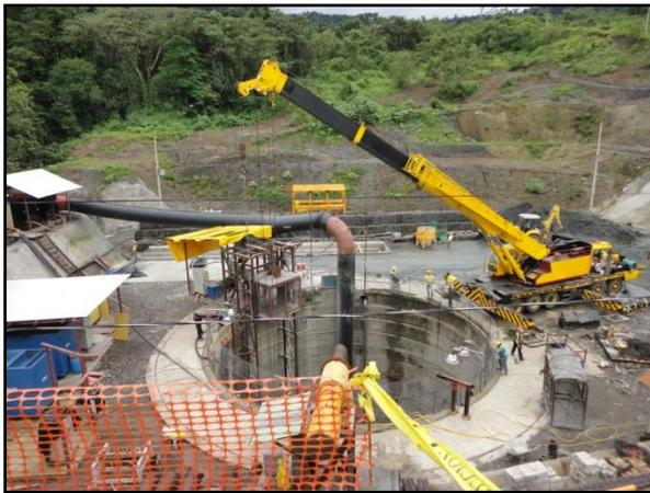
**Figura 4.** Pozo de acceso a los frentes de túnel en proyecto Balsa Inferior. San Ramón de Alajuela.
