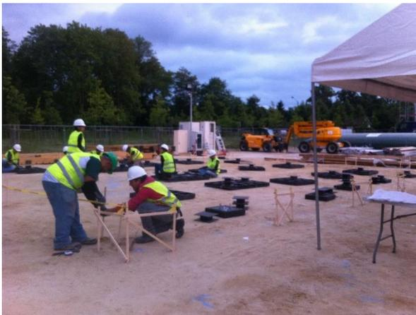
**Fotografía 47.** Colocación de las bases y trazado
