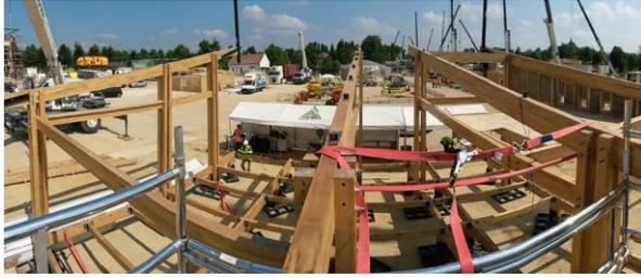
**Fotografía 52.** Ensamblaje de estructura principal
