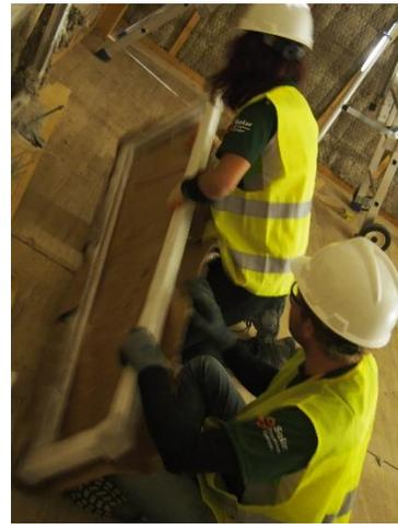
**Fotografía 79.** Colocación de ventanas
