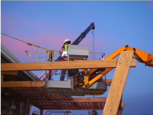
**Fotografía 82.** Ensamblaje estructura externa de acceso
