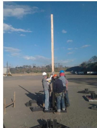
**Fotografía 4.** Colocación de las piezas individuales para las columnas compuestas
