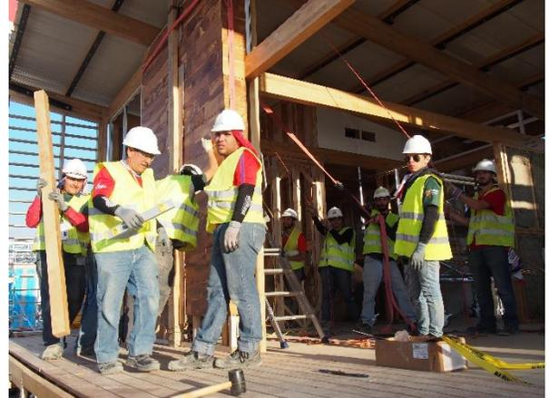
**Fotografía 63.** Colocación de cerramiento inferior de chimenea
