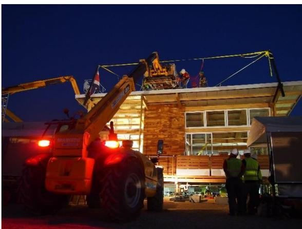
**Fotografía 90.** Colocación de la chimenea
