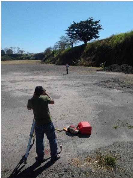
**Fotografía 2.** Levantamiento topográfico en el lugar del ensamblaje de la estructura.
