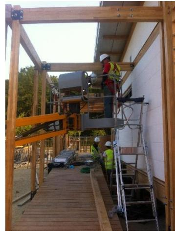
**Fotografía 85.** Ensamblaje estructura externa de acceso
