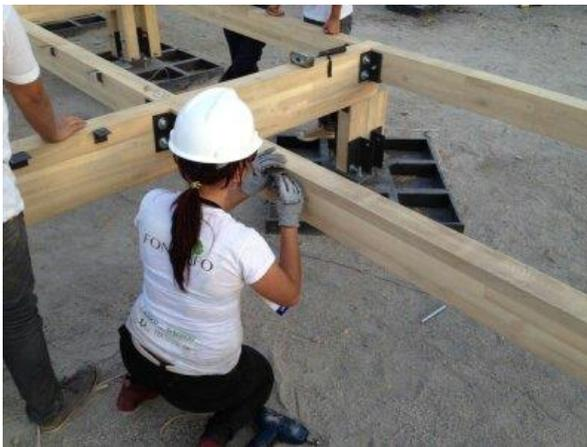
**Fotografía 7.** Ensamblaje de la estructura
