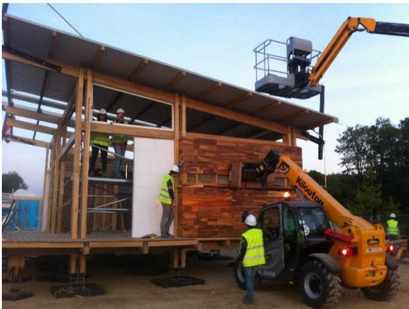
**Fotografía 59.** Colocación de paredes
