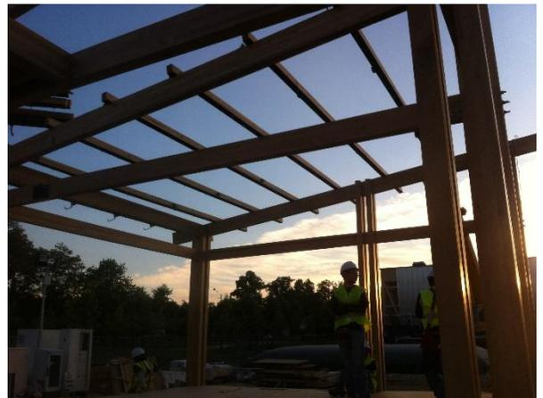
**Fotografía 56.** Ensamblaje estructura principal
