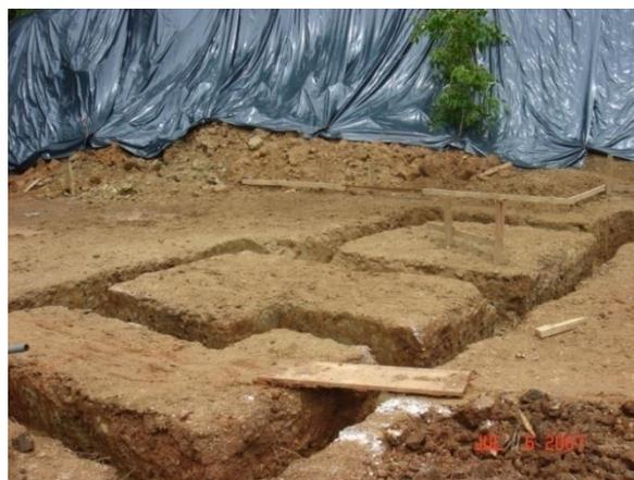
**Figura 2.** Excavación placa corrida casa CM-80
