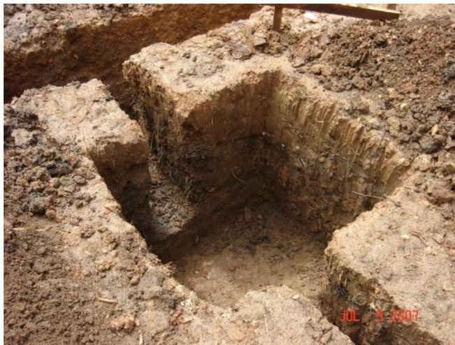
Figura 22. Excavación placa aislada casa CM-80
