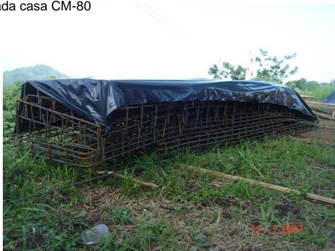
Figura 25. Armadura placa aislada casa CM-64
