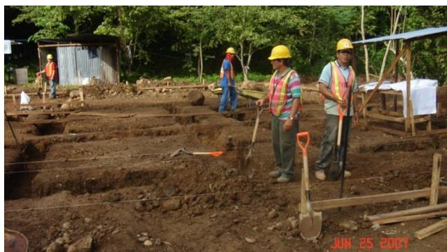
**Figura 1.** Excavación placa corrida casa CM-4A
