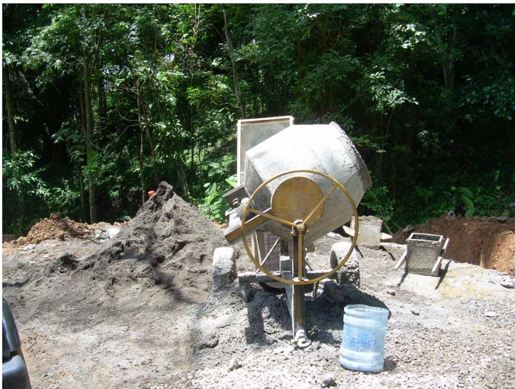
**Figura 36.** Batidora para la fabricación del mortero de pega
