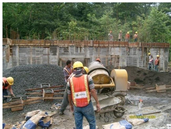
Figura 54. Fabricación de concreto casa CM-4A
