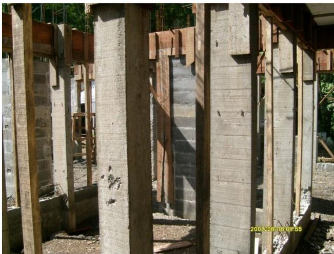
**Figura 56.** Desencofrado de columnas casa CM-04
