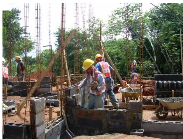
**Figura 39.** Pega de bloques de concreto casa CM-80
