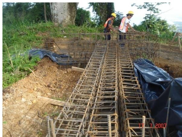
**Figura 45.** Preparación de armadura casa CM-64
