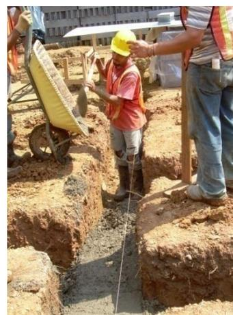
**Figura 18.** Colocación de concreto placa corrida casa CM-80
