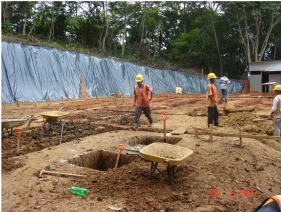
Figura 20. Excavación placa aislada casa CM-80
