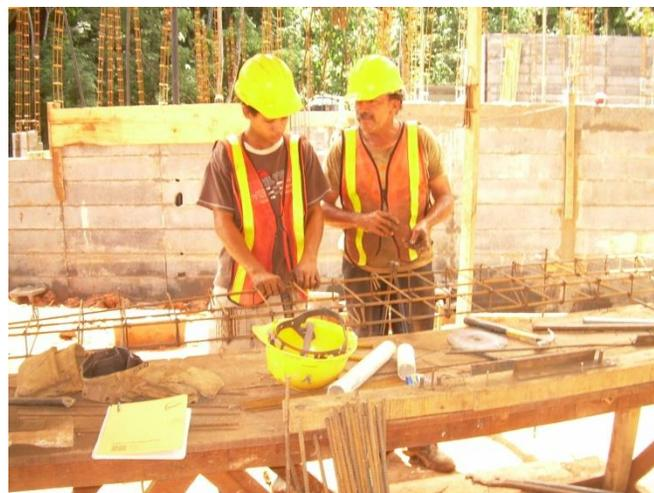
**Figura 75.** Preparación de armadura casa CM-80
