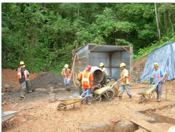
**Figura 17.** Fabricación de concreto placa corrida casa CM-80
