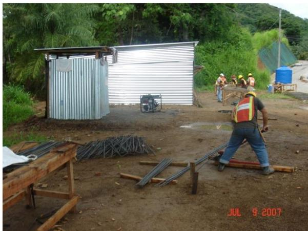
**Figura 44.** Preparación de armadura casa CM-04
