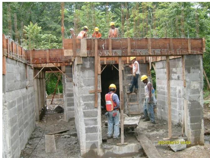
**Figura 84.** Colocación de concreto casa CM-04
