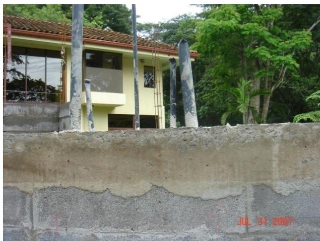
**Figura 86.** Desencofrado de vigas casa CM-04
