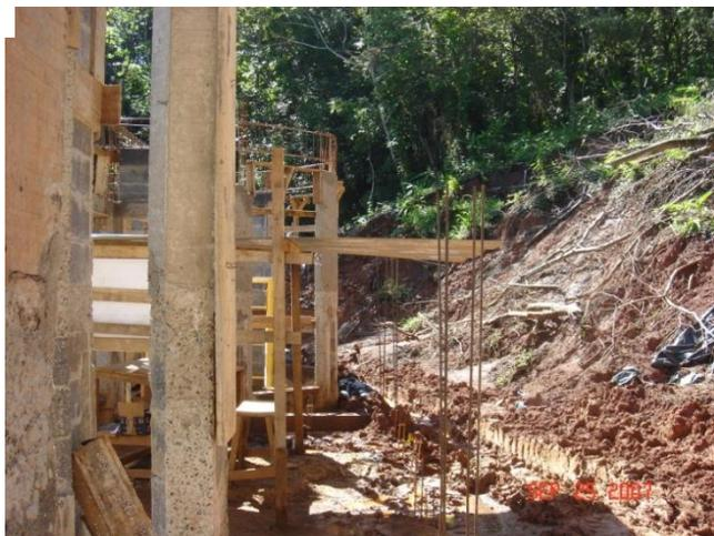
**Figura 57.** Desencofrado de columnas casa CM-80
