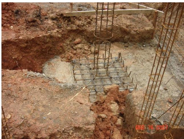
**Figura 62.** Colocación de armadura casa CM-80
