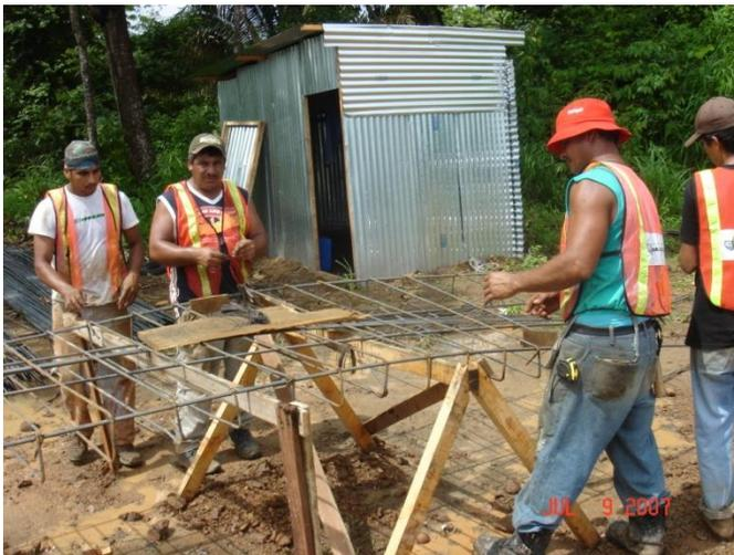
Figura 24. Preparación de armadura placa aislada casa CM-80
