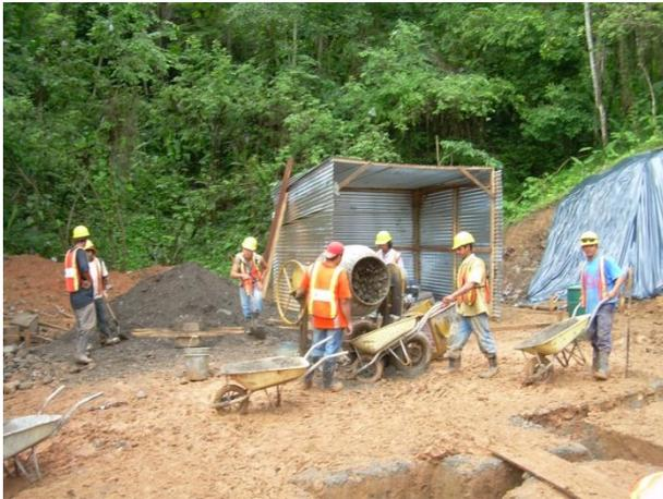
**Figura 68.** Fabricación de concreto casa CM-80
