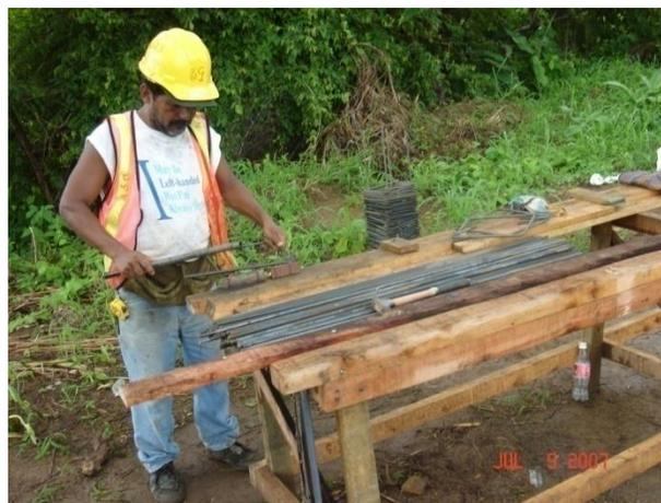
**Figura 7.** Preparación de armadura placa corrida casa CM-80
