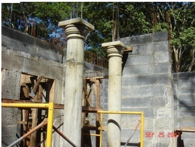
**Figura 72.** Desencofrado columna circular casa CM-80
