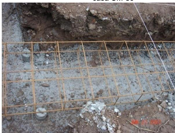
**Figura 13.** Colocación de armadura placa corrida casa CM-4A
