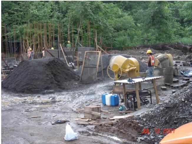
**Figura 41.** Fabricación de concreto casa CM-04
