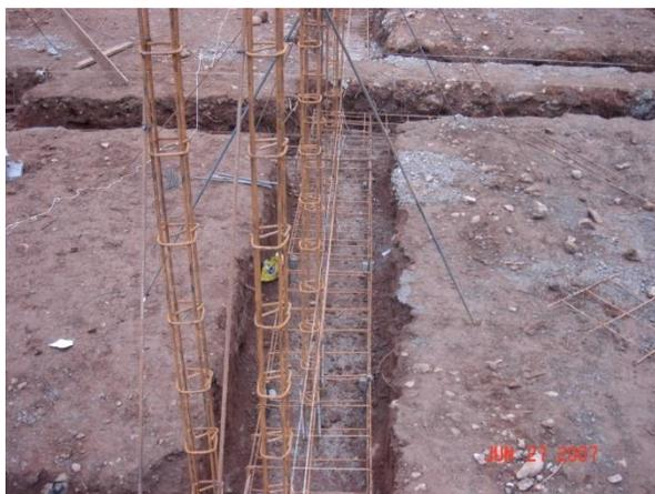
**Figura 33.** Colocación de acero vertical casa CM-4A
