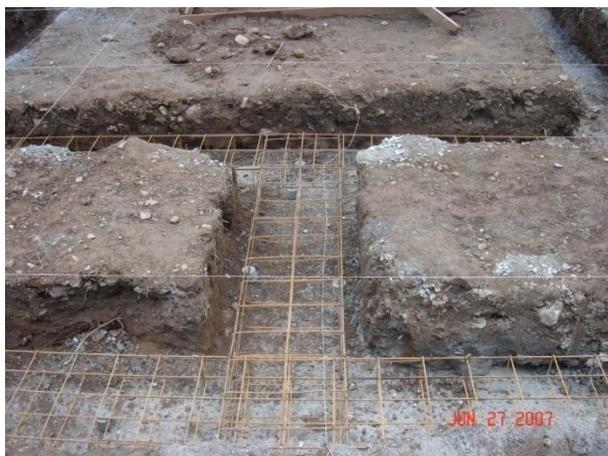
**Figura 11.** Colocación de armadura placa corrida casa CM-4A
