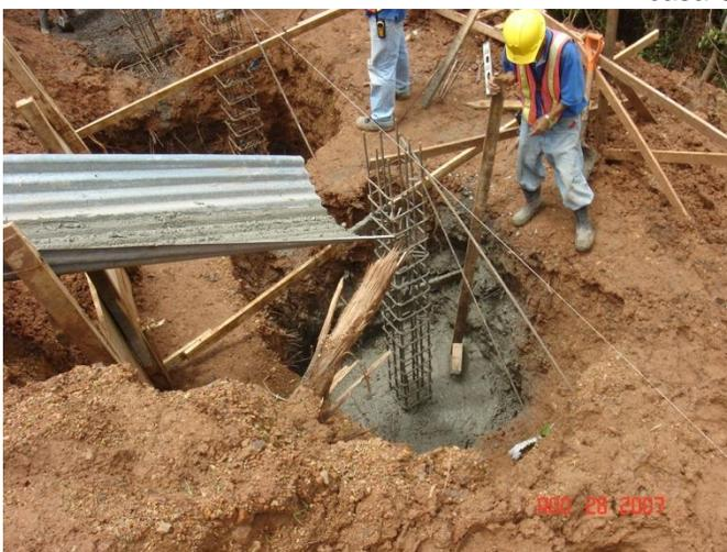
**Figura 31.** Colocación de concreto placa aislada casa CM-64
