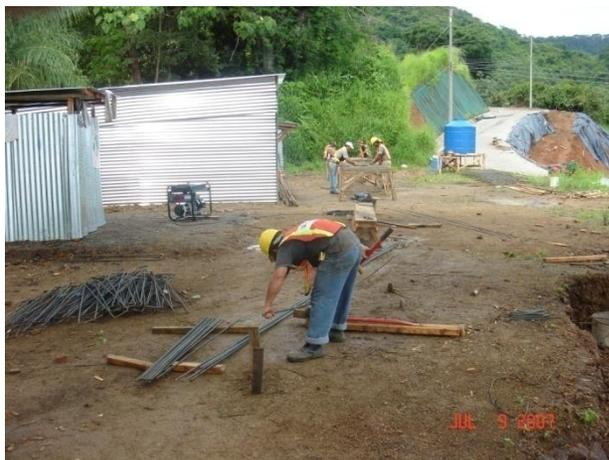
**Figura 6.** Preparación de armadura placa corrida casa CM-4A
