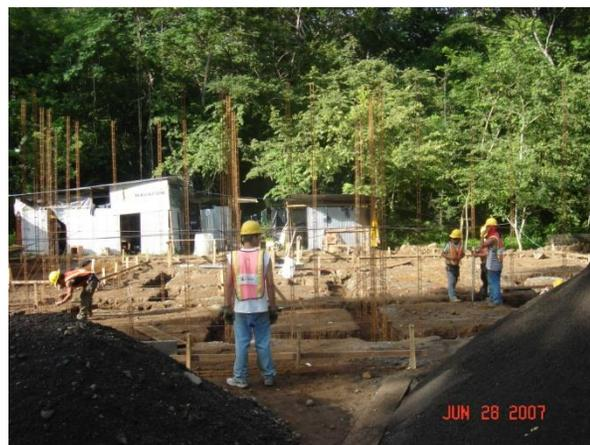
**Figura 34.** Colocación de acero vertical casa CM-4A
