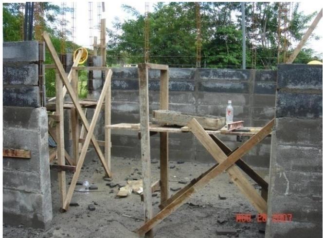
**Figura 90.** Cajón utilizado para cargar mortero casa CM-04
