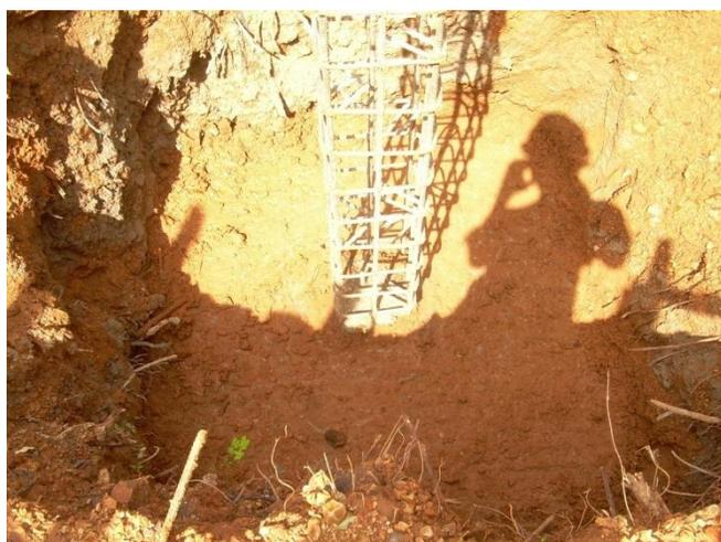
**Figura 47.** Colocación de armadura casa CM-64
