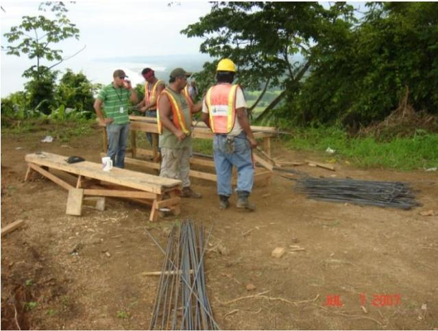
Figura 59. Preparación de armadura casa CM-80
