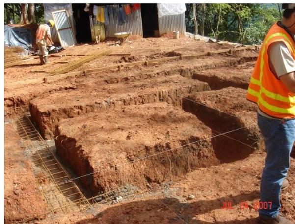
**Figura 12.** Colocación de armadura placa corrida casa CM-80
