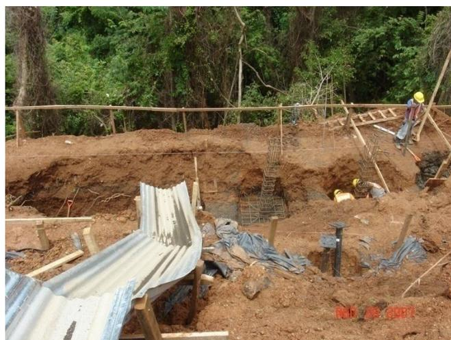
**Figura 48.** Colocación de armadura casa CM-64
