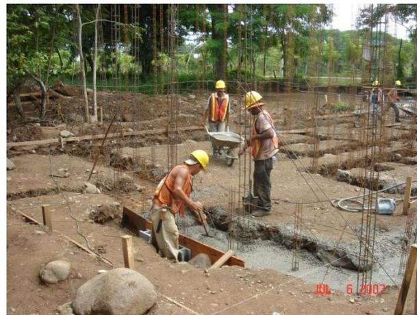
**Figura 16.** Colocación de concreto placa corrida casa CM-4A
