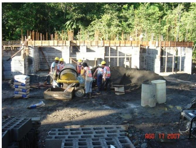
Figura 53. Fabricación de concreto casa CM-4A
