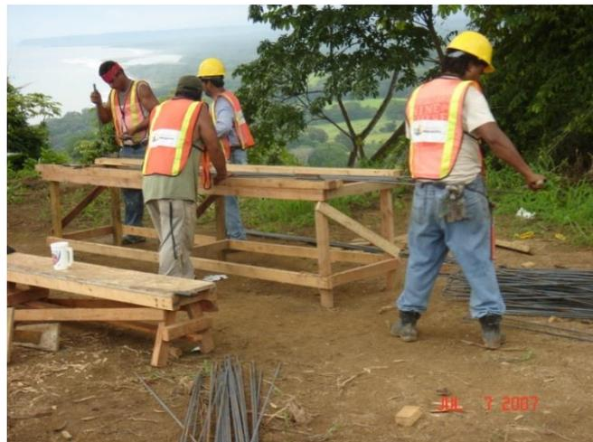
Figura 60. Preparación de armadura casa CM-80
