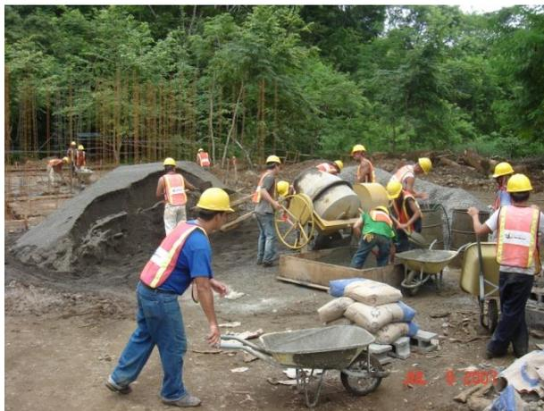
**Figura 15.** Fabricación de concreto placa corrida casa CM-4A
