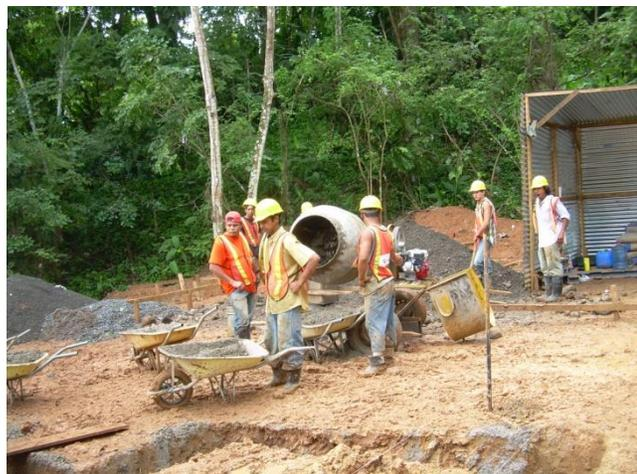
**Figura 69.** Fabricación de concreto casa CM-80
