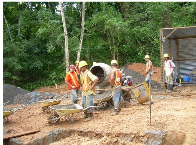
**Figura 30.** Fabricación de concreto placa aislada casa CM-80
