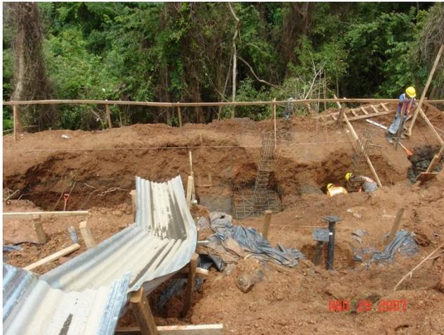
**Figura 27.** Colocación de armadura placa aislada casa CM-64
