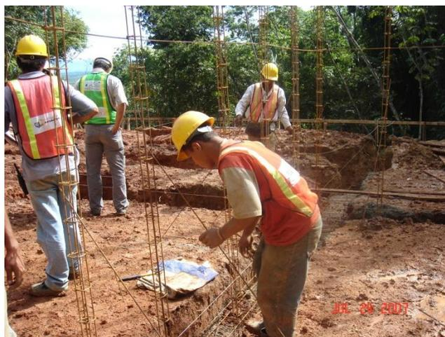
**Figura 34.** Colocación de acero vertical casa CM-80
