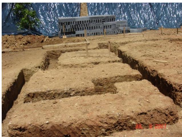
**Figura 3.** Excavación placa corrida casa CM-80
