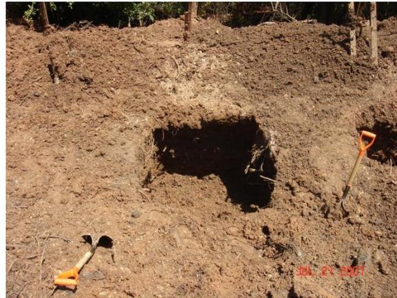
Figura 21. Excavación placa aislada casa CM-64
