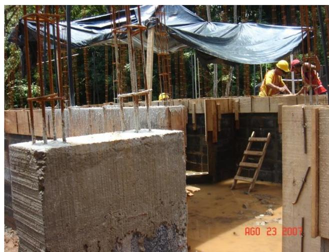
**Figura 87.** Desencofrado de vigas casa CM-80
