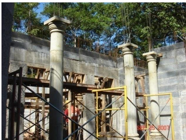
**Figura 71.** Desencofrado columna circular casa CM-80
