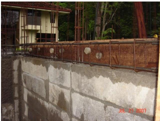
**Figura 77.** Colocación de armadura casa CM-04
