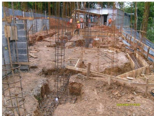
**Figura 63.** Colocación de armadura casa CM-80
