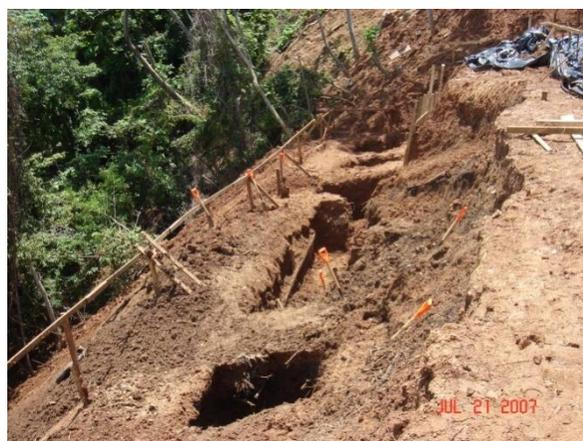
**Figura 4.** Excavación placa corrida casa CM-64
