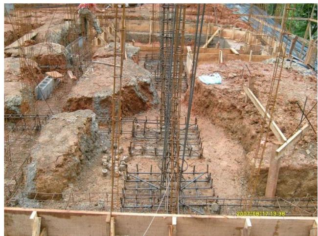
**Figura 28.** Colocación de armadura placa aislada casa CM-80
