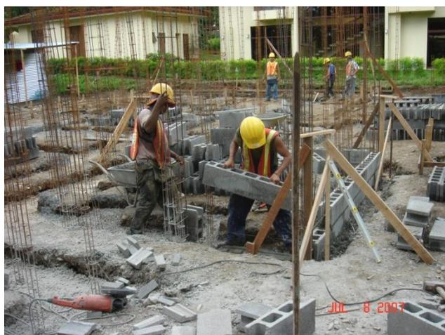
**Figura 38.** Pega de bloques de concreto casa CM-04
