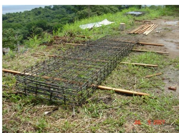
**Figura 9.** Armadura placa corrida
