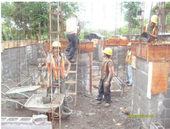
**Figura 83.** Colocación de concreto casa CM-80
