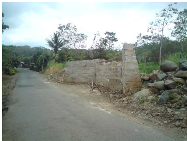
Figura 4. Puente ejecutado en abril de 2010, su construcción dio inicio en el año 2009.
