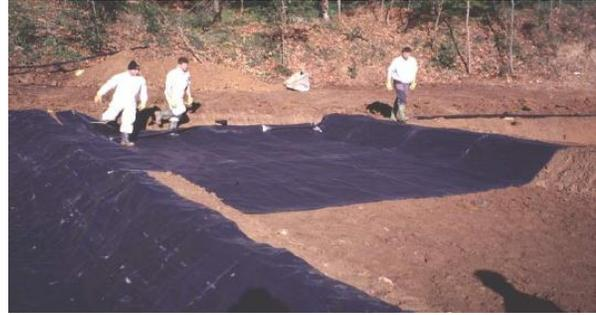
Figura 13. Colocación de la geomembrana.
