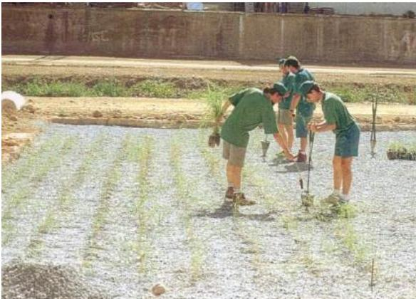
**Figura 15. Operaciones de sembrado de plántulas de carrizo en un sistema sub superficial.**
