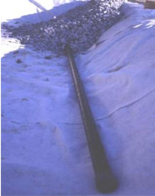
Figura 12. Colocación de la tubería de salida en un humedal construido de flujo sub superficial.
