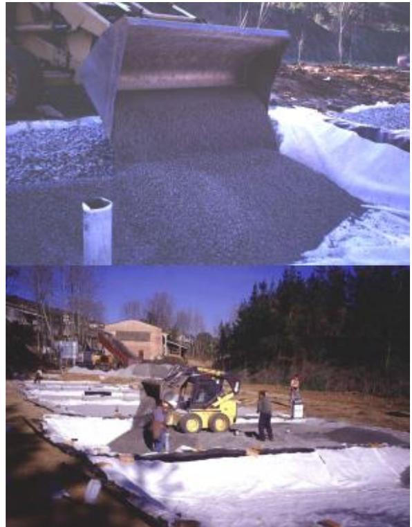
Figura 14. Arriba: Colocación de material granular desde exterior de la celda. Abajo: colocación de material granular con maquinaria liviana desde interior de la celda.
