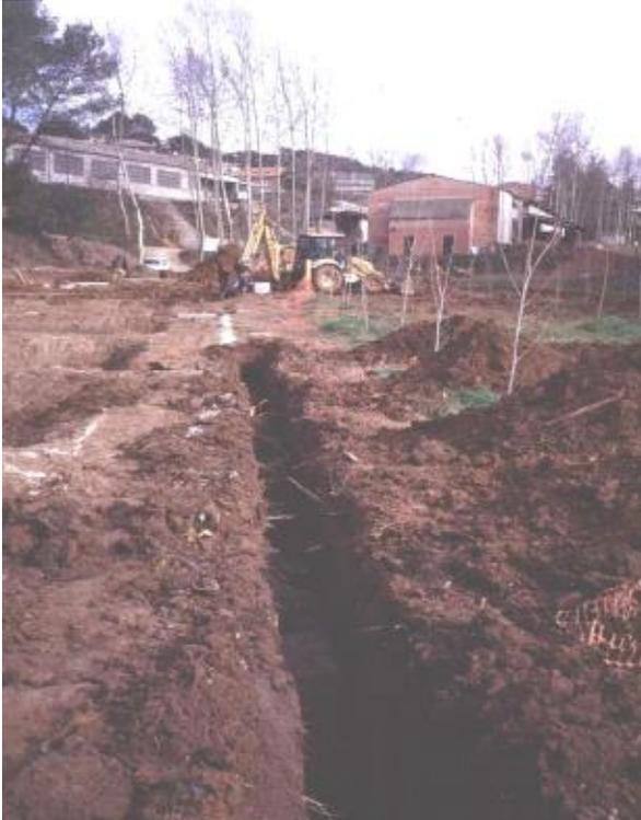
Figura 10. Excavación de zanja para la colocación de una tubería.
