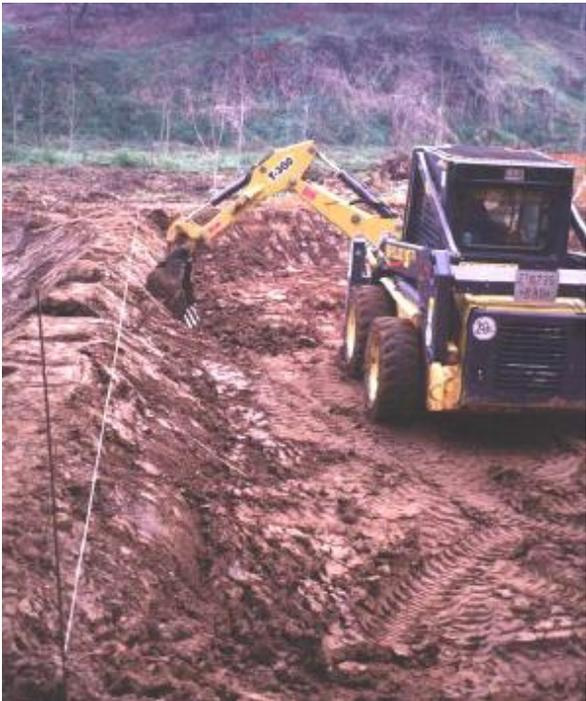
Figura 11. Movimiento de tierras para un humedal construido.
