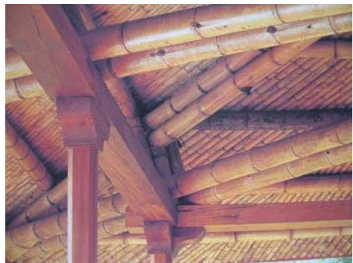
Figura 7. Columnas de bambú utilizando la caña completa.
