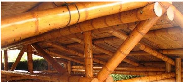
Figura 8. Columnas de bambú utilizando la caña completa.
