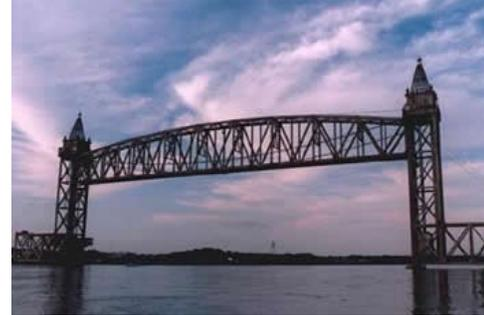
Figura 8. Puente de elevación vertical.
