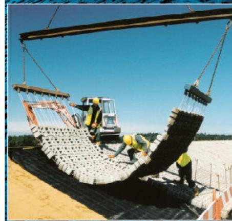
Fig.43. Colocación de mantas de bloques articulados de concreto
