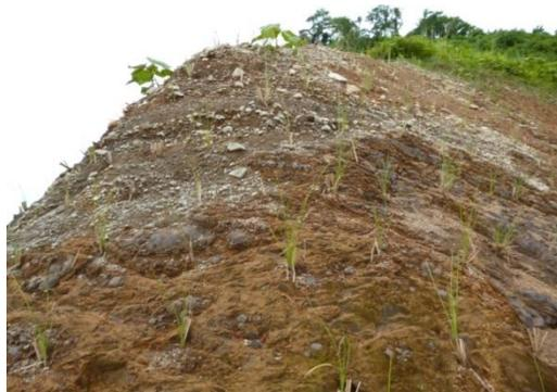
**Figura 39.** Talud 2 del cerro La Potra conformado por suelo limo arcillosa.
