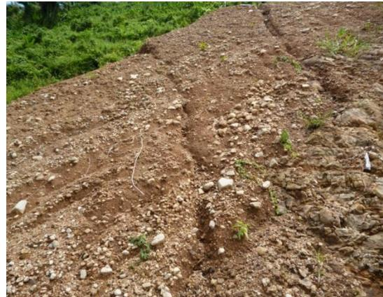
Figura 58. Talud 4 del cerro La Potra conformado por suelo residual de matriz arcilla limosa.
