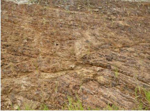
**Figura 40.** Junta favorable de estratificación del talud 2, segunda parte.
