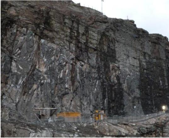
Figura 99. Talud 9 del cerro La Potra, donde se aprecia los tres tipos de discontinuidades.
