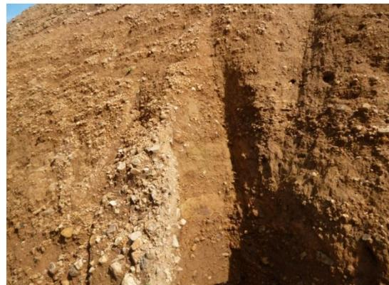
Figura 74. Talud 7 primera parte, conformado por suelo de matriz limo arcillosa.
