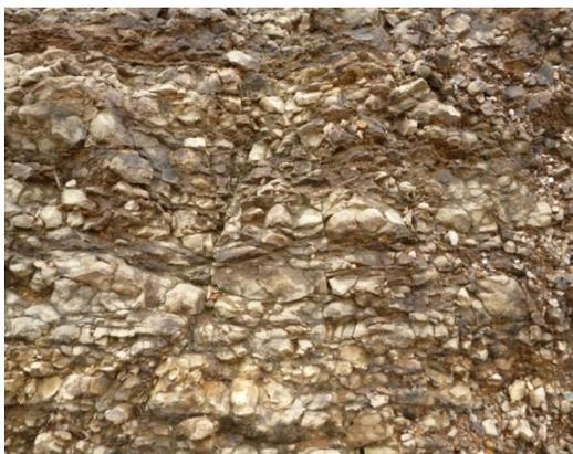
**Figura 85.** Junta de estratificación S, talud 8 segunda parte.
