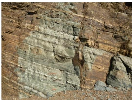
**Figura 65.** Junta favorable de estratificación del talud 5, segunda parte.
