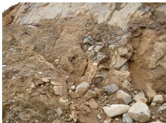
Figura 96. Junta de estratificación S, talud 8 quinta parte.
