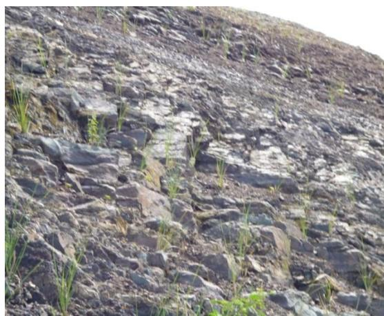
**Figura 48.** Junta favorable de estratificación del talud 3, segunda parte.
