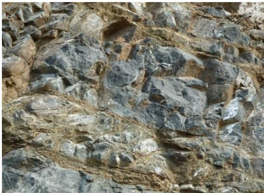
**Figura 71.** Junta favorable de estratificación del talud 6, segunda parte.
