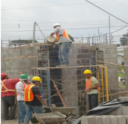
Figura 7. Colocación de concreto en monchetas
