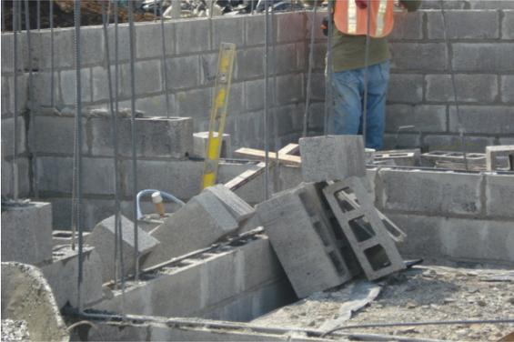
Figura 1. Colocación inadecuada de los bloques antes de ser pegados.
