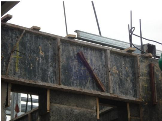
Figura 9. Deterioro de la formaleta fenólica al ser perforada en la lámina para introducir los soportes.
