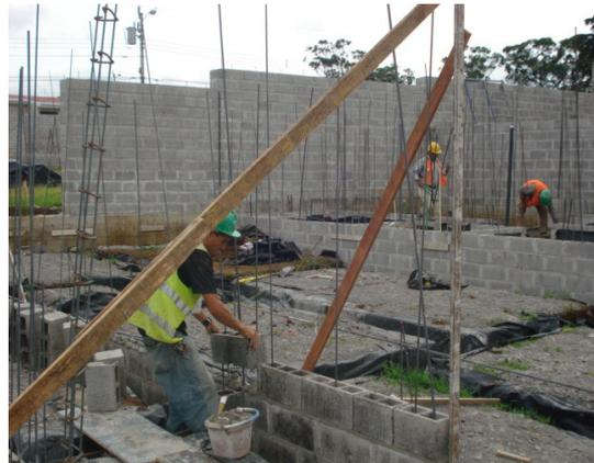
Figura 6. Proceso de pegado de los bloques.
