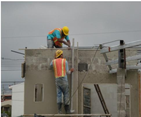
Figura 8. Proceso de repello de pared, donde el codal permite lograr el espesor adecuado.
