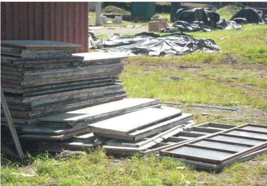
Figura 2. Almacenamiento inadecuado de la formaleta fenólica, la cual se expone al sol y la humedad.
