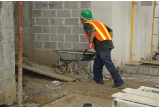
Figura 3. Transporte de concreto a través de una rampa.
