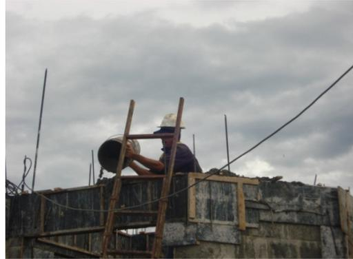
Figura 4. Colocación de concreto en viga corona.
