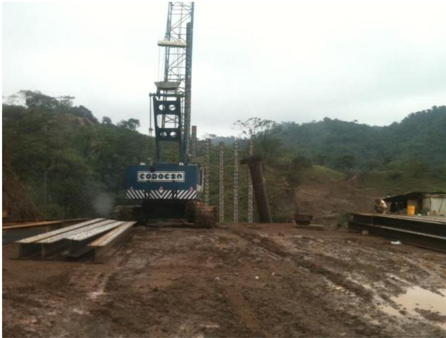
**Figura 5.** Grúa utilizada por CODOCSA para la hincada de pilotes.
