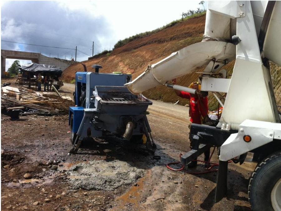
**Figura 7.** Bomba estacionaria utilizada en el proyecto.
