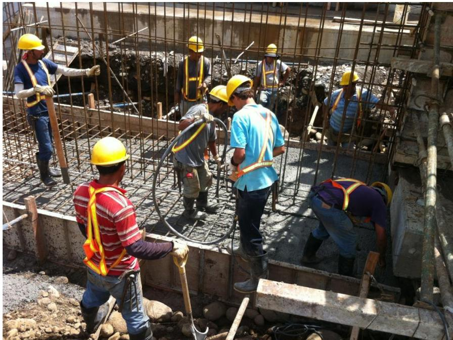
**Figura 10.** Consolidación de la primera colada con equipo vibratorio.
