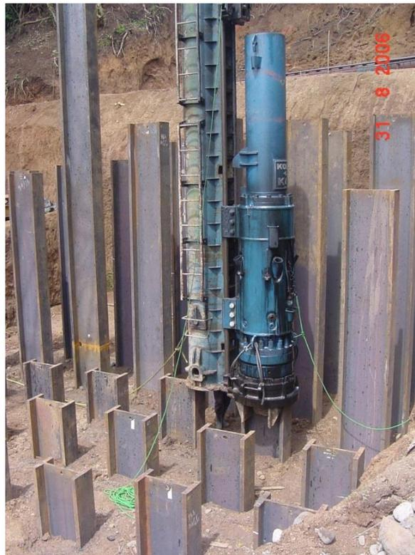
**Figura 9.** Martillo KOBE K-35 utilizado por CODOCSA. (CODOCSA)
