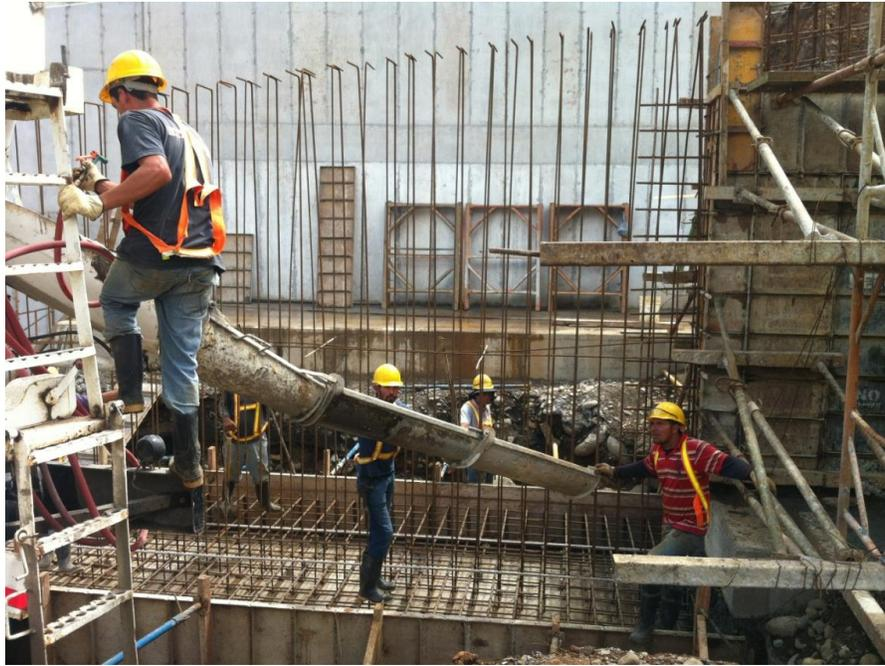
**Figura 9.** Descarga de la primera colada de la placa de cemento del muro 8 de la rampa de acceso de la Intersección La Abundancia.
