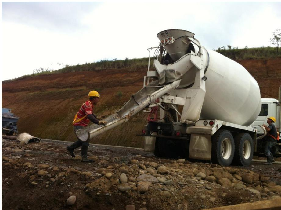
**Figura 8.** Camión mezclador usado para transporte y mezcla del concreto.
