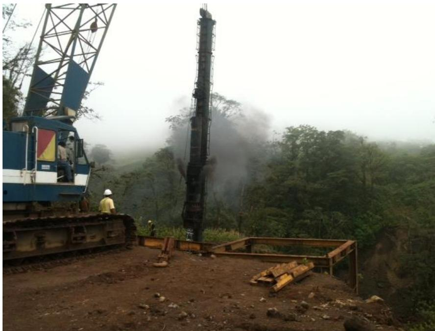
**Figura 6.** Hincada de pilotes para cimentación de pila 2 del puente Laguna.
