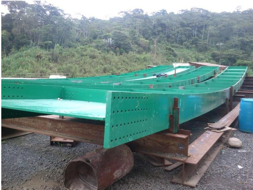
**Figura 1.** Vigas principales del puente sobre Río La Vieja.
