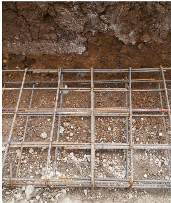
**Fotografía 18.** El 100% de empalmes por traslapeo en la misma sección.
