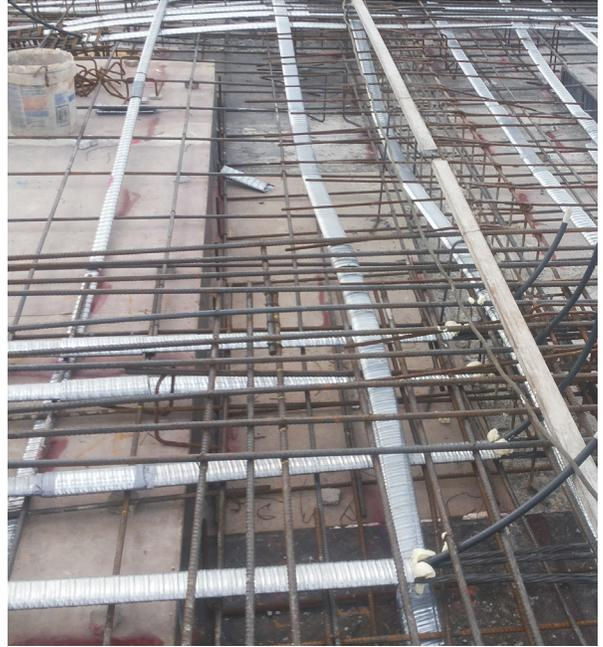
**Fotografía 5.** Densidad del refuerzo y suciedad en la superficie del encofrado.
