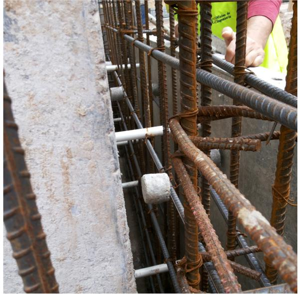
**Fotografía 21.** Recubrimiento excesivo por colocación incorrecta del refuerzo.
