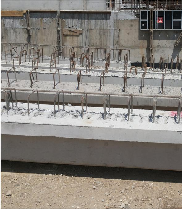
**Fotografía 3.** Llaves de cortante en viga prefabricada en sitio.
