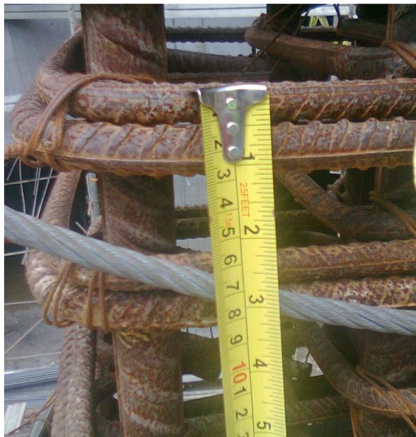
**Fotografía 10.** Espaciamiento entre los aros de una columna y el nivel de oxidación del refuerzo.
