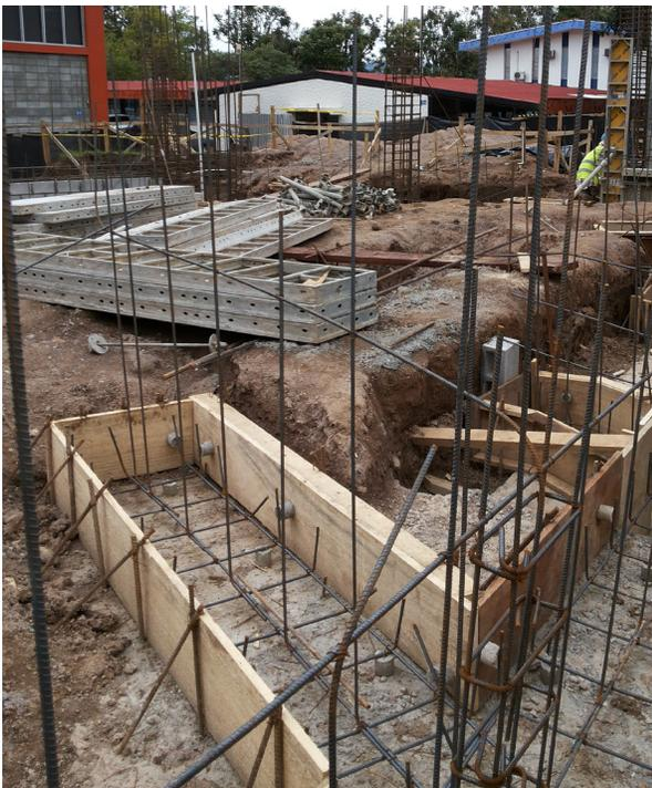
**Fotografía 20.** Refuerzo de cimentación mal amarrado y con libertad de movimiento.
