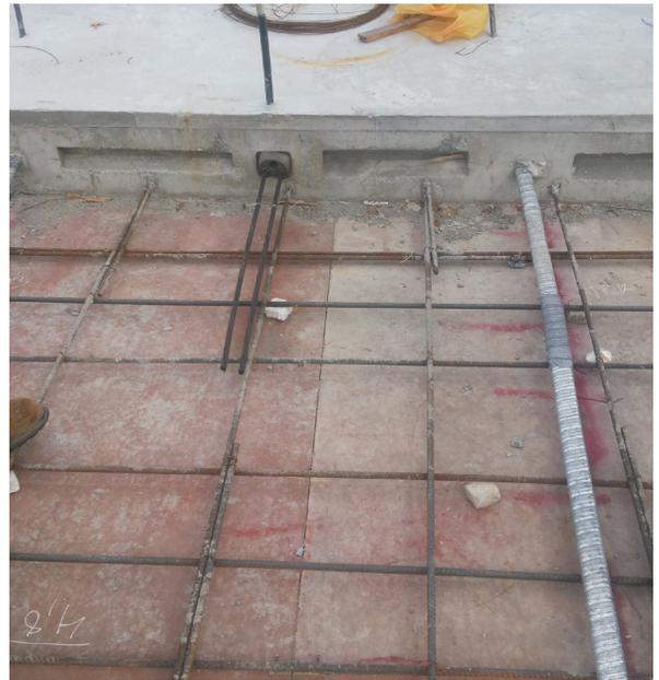
**Fotografía 6.** Helados para el soporte de la malla inferior de la losa y suciedad en la superficie del encofrado.
