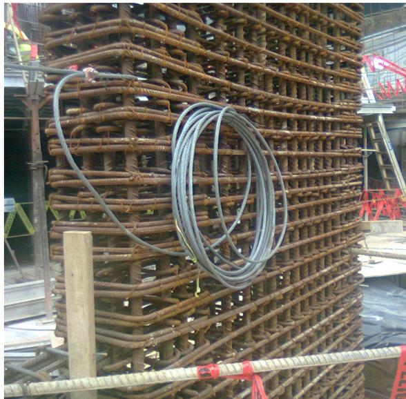
**Fotografía 9.** Densidad del refuerzo en columnas de concreto y nivel de oxidación del refuerzo.
