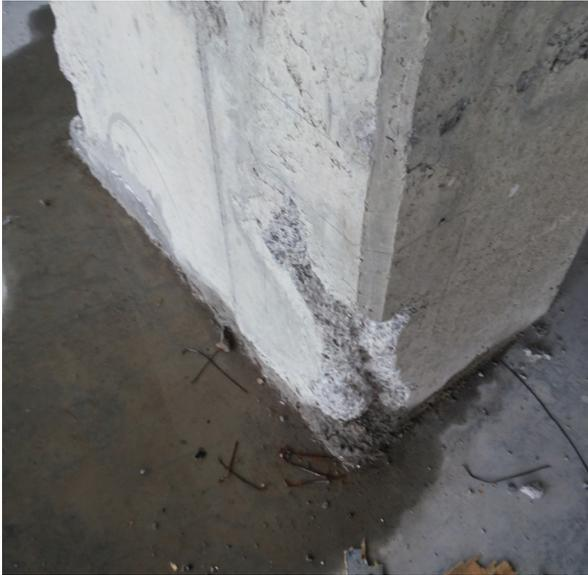
**Fotografía 11.** Proceso de reparación de hormigueros en columnas.
