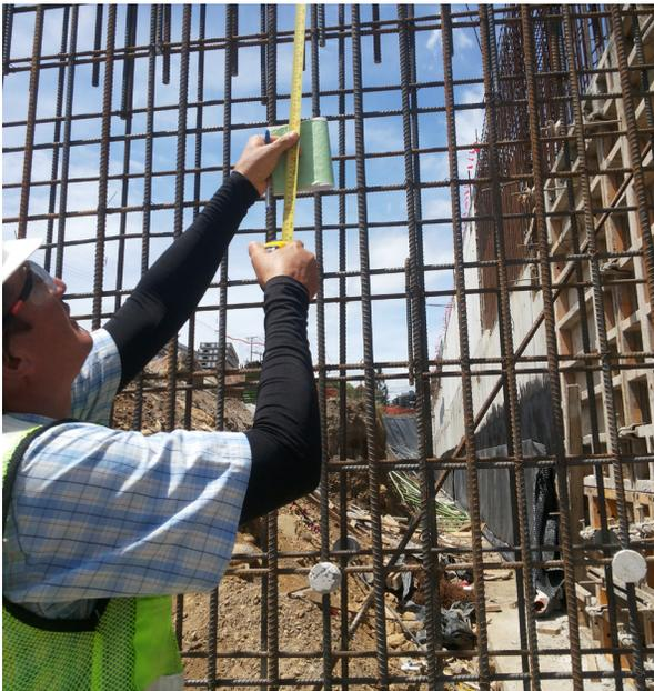
**Fotografía 4.** Verificación de empalme por traslape en muro de concreto reforzado.
