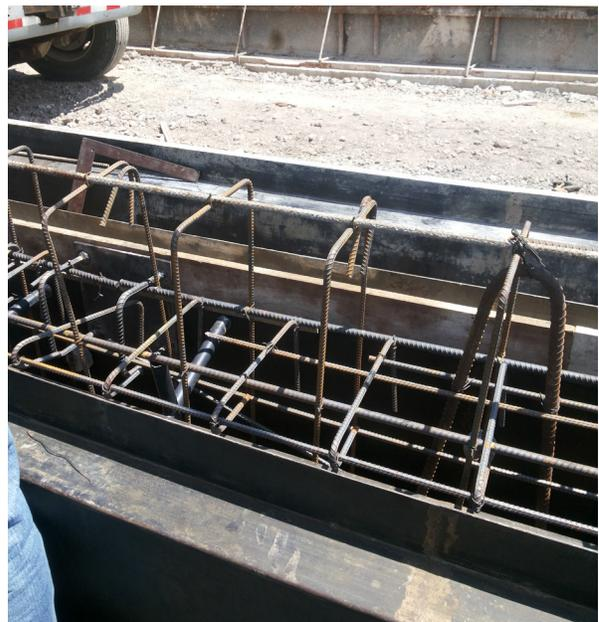
**Fotografía 2.** Viga de concreto reforzado, prefabricada en sitio.
