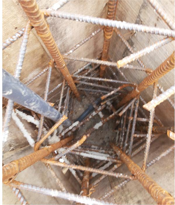
**Fotografía 25.** Nivel de oxidación y residuos de concreto en el refuerzo.
