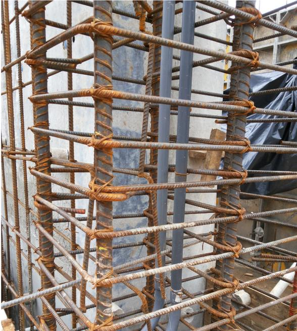
**Fotografía 23.** Refuerzo con residuos de concreto.
