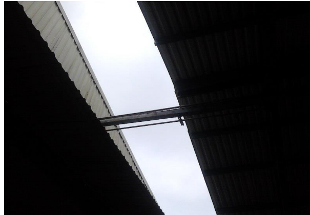
Figura 10. Conduito instalación Eléctrica entre Taller Empacadora y Aires Forzados.
