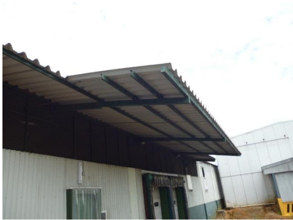
Figura 17. Alero Zona de Carga, Bodega de Cartón Empacadora
