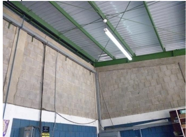
Figura 8. Paredes internas Taller Empacadora.
