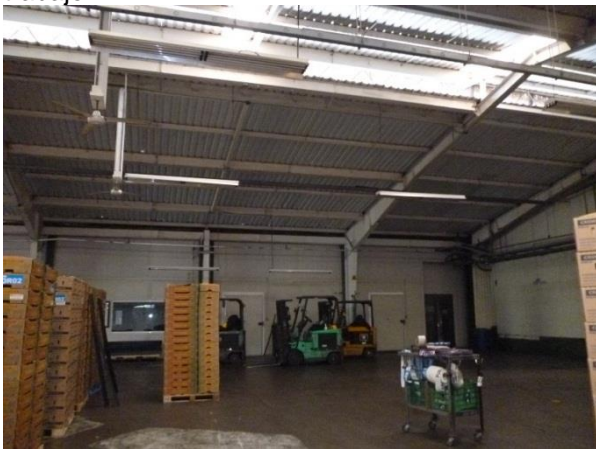
Figura 55. Pisos Zona Paletizado
