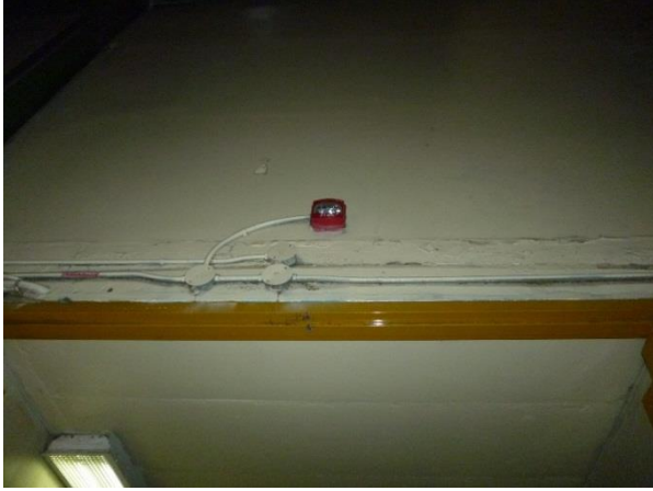
Figura 27. Interior Túnel de Trasiego, Bodega de Cartón.
