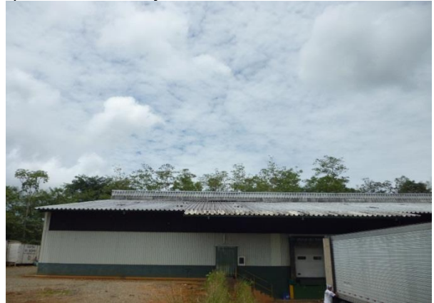
Figura 16. Estructura de techos, Bodega de Cartón Empacad.
