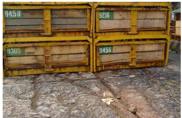
Figura 65. Losas Erosionadas Zona de Carga Piña para Rechazo.
