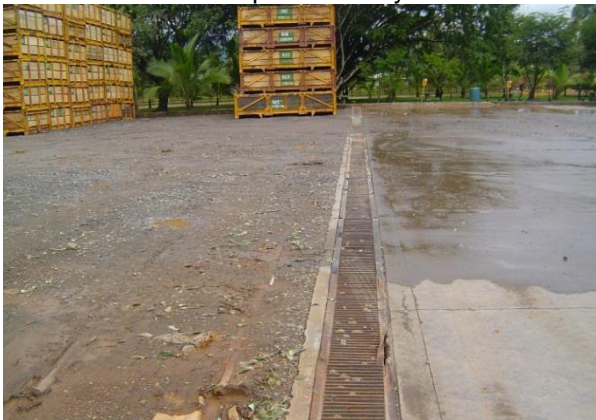
Figura 59. Desagüe perimetral Losas Zona Descarga.
