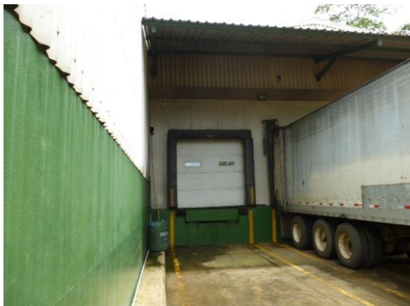
Figura 33. Losas en zona de Carga Aires Forzados
