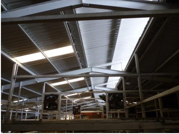
Figura 36. Estructura de techos Planta Empacadora.
