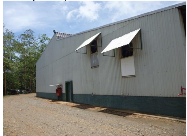
Figura 20. Detalle externo paredes Bodega Cartón
