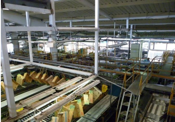
Figura 54. Pisos Zona de Empaque
