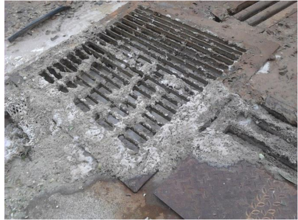
Figura 53. Caja Registro Sistema Evacuación Jugos de Piña.
