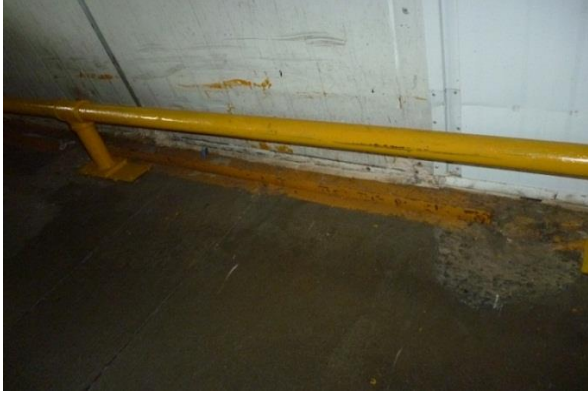
Figura 30. Protección paredes Aires Forzados.
