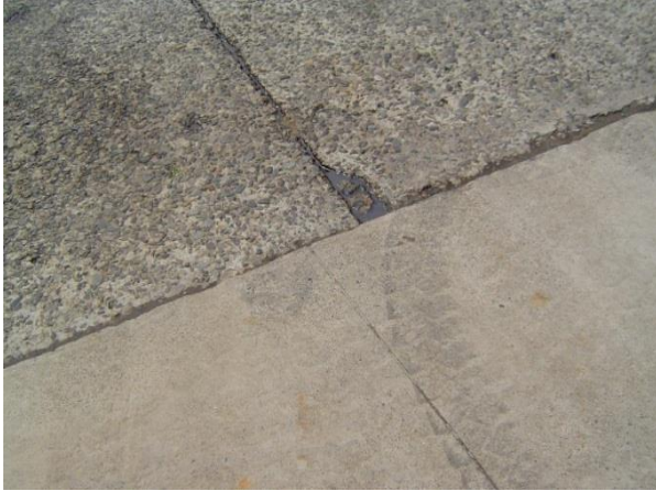
Figura 58. Losas Zona de Descarga Cajones de Fruta (crate)
