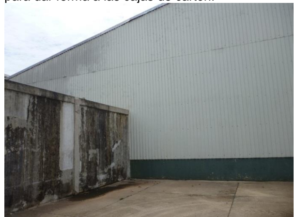
Figura 26 Exterior Túnel de Trasiego, Bodega de Cartón.
