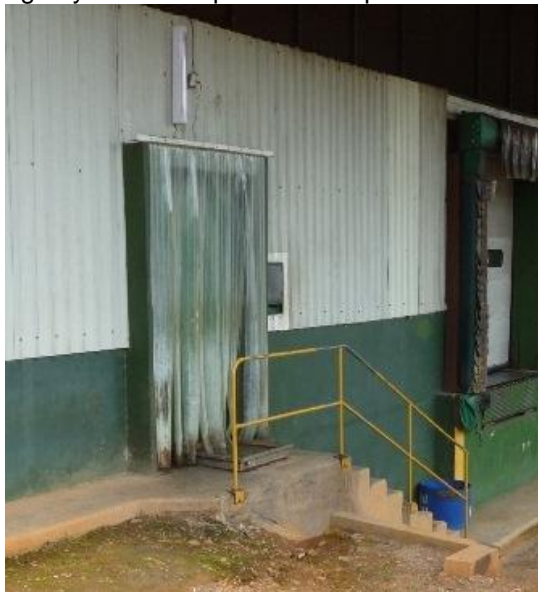
Figura 24. Puerta de Acceso Bodega de Cartón
