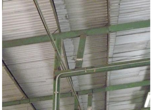
Figura 5. Estructura de Techos Taller Empacadora.
