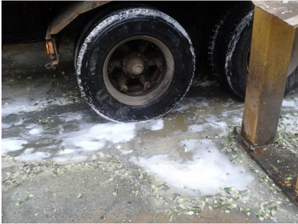
Figura 62. Losas Zona de Carga Hijos de Piña Triturados
