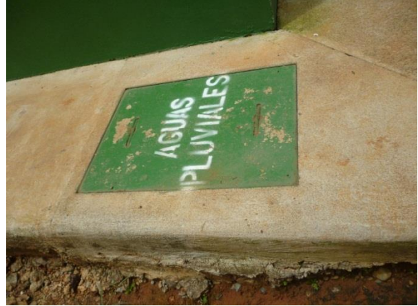
Figura 32. Caja registro Aguas Pluviales Aires Forzados
