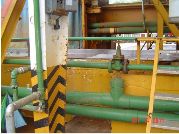
Figura 47. Instalación Mecánica piletas de lavado
