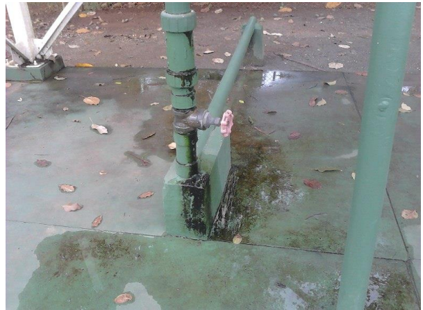
Figura 49. Instalación mecánica Tanque Agua potable Empacadora
