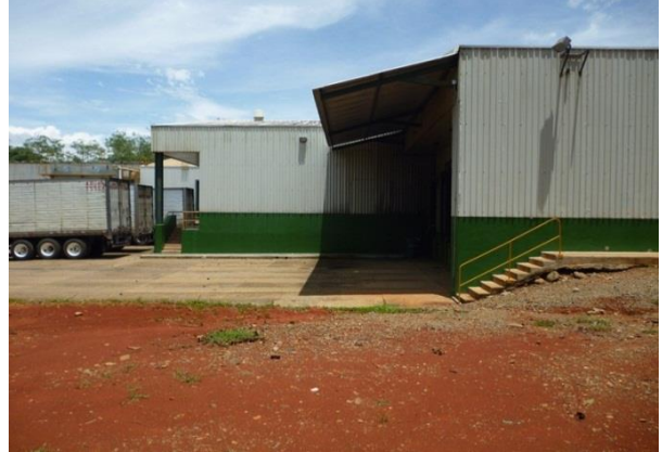
Figura 29. Zona de Carga Aires Forzados.
