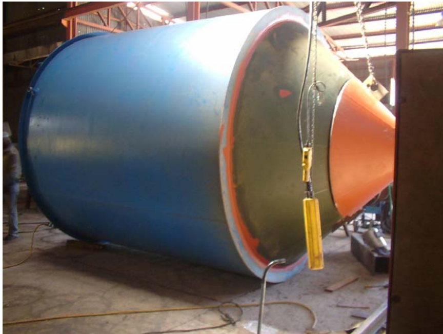
Figura 11: Estructura de Silo de Cemento
