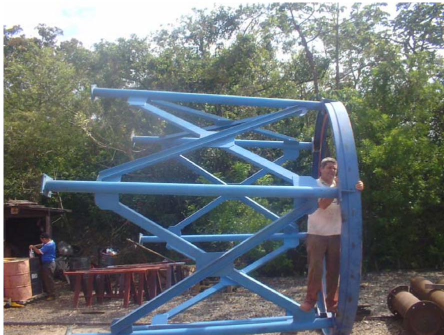
Figura 12: Base del Silo de Cemento
