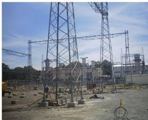
Foto 1. Montaje de Columnas y vigas
