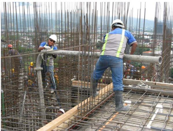
Foto 10. Colocación de tubería para transporte de concreto mediante bomba estacionaria.
