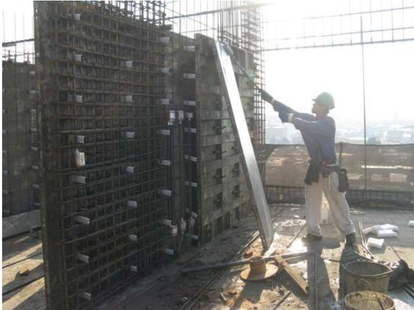
*Figura 5. Colocación de Formaleta Forsa*
