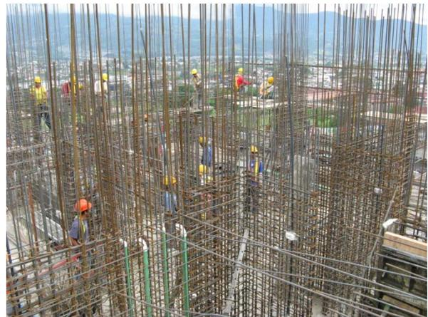
Figura 7. Colocación de Acero en Muros
