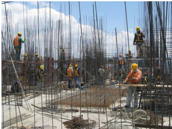
*Figura 2. Confección de Armadura de Muros*
