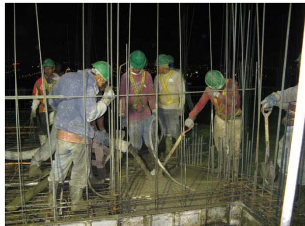
*Figura 6. Colocación de Concreto*
