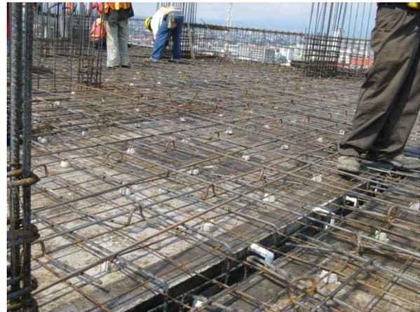
*Figura 8. Conformación de Refuerzo de Losa*
