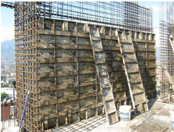
Figura 9. Colocación de Formaleta Forsa
