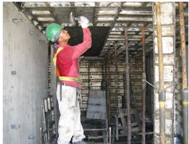
Figura 9. Desencofrado de Losa
