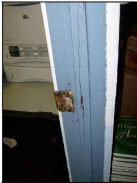
**Figura 80.** Los marcos de las puertas se encuentran deteriorados, algunos ocupan sustituirse y otros pintarse. Esto tambien aplica para algunas puertas.
