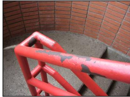
**Figura 45.** Las gradas se encuentran bien y las barandas se encuentran algo deterioradas debido al uso pero son funcionales.
