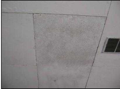
**Figura 53.** Los cielos no presentan serios daños físicos pero si requieren de una limpieza o pintura.
