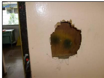
**Figura 84.** Algunas paredes de madera del taller de cerámica presentan gran deterioro y huecos de gran tamaño.
