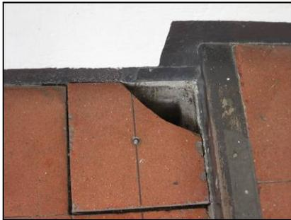
**Figura 47.** El piso de terrazo en ciertas partes tiene piezas reventadas o piezas quebradas. Pero en general puede ocupar un pulido general.
