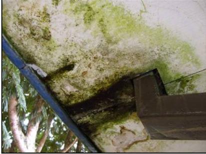
**Figura 85.** Láminas del cielo de los aleros con daños debido a la humedad. Puede haber desperfectos con las canoas o bajantes en esos puntos específicos.
