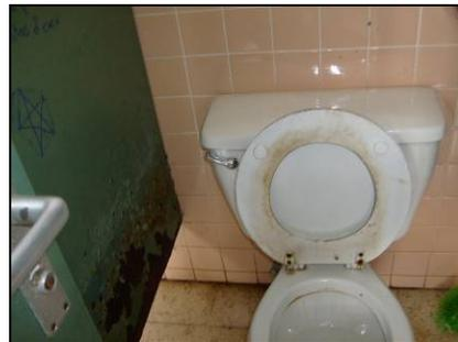
**Figura 97.** Los aros de los inodoros se muestran con deterioro por lo que deberían sustituirse.
