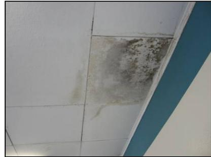
**Figura 61.** Presencia de goteras en ciertas partes, por lo que las láminas de cielo raso presentan deterioro y hasta se han desprendido debido a la humedad.
