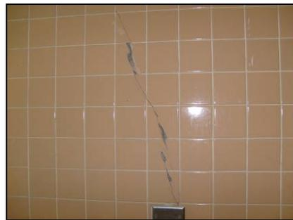
**Figura 107.** Se notan grietas muy notables en el sanitario de varones, los enchapes se encuentran reventados en ciertas partes de la pared.
