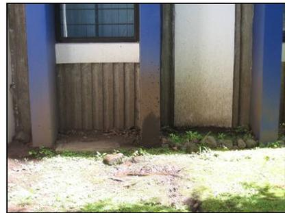
**Figura 39.** Las paredes externas se encuentran sucias debido a tierra que salpica con las lluvias.
