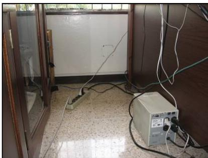
**Figura 12.** La falta de mayor cantidad de tomacorrientes ocasiona la utilización de regletas. Lo que genera desorden de cables y mayor demanda del sistema eléctrico. El piso se muestra muy bien.
