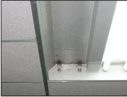
**Figura 10.** Las luminarias son principalmente fluorescentes y funcionan bien, hay faltantes de varios tubos fluorescentes y de rejillas difusoras.
