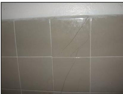
**Figura 17.** Los enchapes del baño del primer nivel presentan reventaduras en ciertas piezas. Aunque en general su estado se observa en buenas condiciones.
