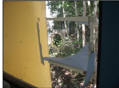
**Figura 18.** Ventanal quebrado en el tercer nivel, el cual tiene varios meses sin que se sustituya. La falta de celosías internas en este nivel también es considerable.
