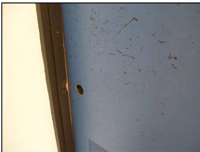
**Figura 96.** En general las puertas se encuentran muy bien a excepción de las del área de los baños del segundo nivel. Como esta que no tiene cerradura y esta deteriorada.
