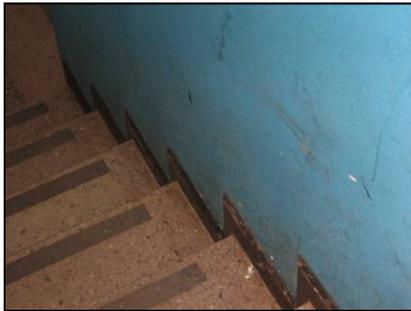
**Figura 35.** Las paredes internas del área de las escaleras están deterioradas debido al alto tránsito, además los rodapiés se muestran golpeados.
