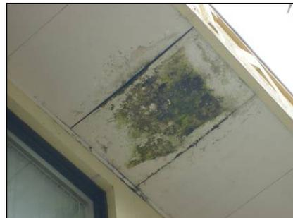
**Figura 129.** Los cielos de todo el edificio se encuentran muy bien solo en este caso en la parte trasera del edificio. La humedad indica un problema de goteras o con la canoa.
