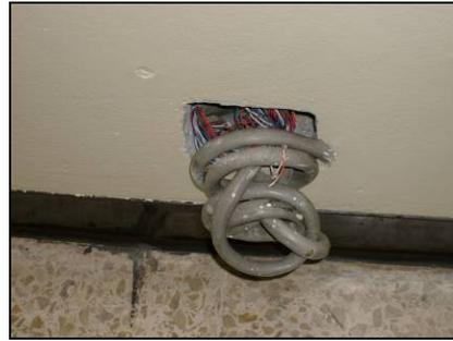
**Figura 106.** La falta de una tapa para que el cableado de la red telefónica no quede expuesto.
