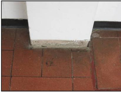
**Figura 48.** Los rodapiés de vinilo en ciertos tramos se han desprendido o están parcialmente desprendidos. Especialmente en el área de los pasillos de las aulas debido al alto tránsito.
