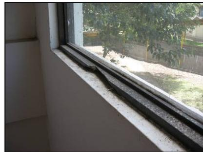
**Figura 52.** Los marcos de madera de las ventanas se notan algo deteriorados y sucios. Los faltantes de celosías también se notan.
