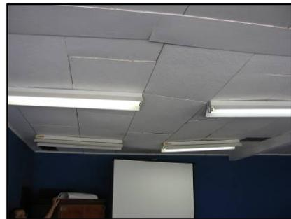
**Figura 74.** En la sala de cultura las láminas del cielo se encuentran bien, pero el problema reside en que el techo se está bajando. Además hay excesiva cantidad de luminarias fluorescentes en esa sala.
