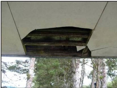
**Figura 135.** Algunas piezas de los aleros necesitan sustituirse, debido a que se encuentran quebradas.
