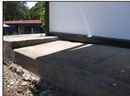
**Figura 69.** En el sector este se ha presentado un ligero asentamiento del edificio. Lo cual ha generado pisos reventados que anteriormente se arreglaron.
