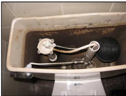
**Figura 22.** Los baños en general se encuentran bien. Solo este del tercer piso que no está en uso debido a una fuga de agua que no se ha corregido.
