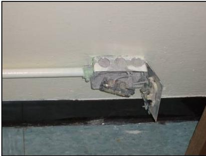
**Figura 104.** Presencia de varios tomacorrientes flojos o con la tapa desprendida.
