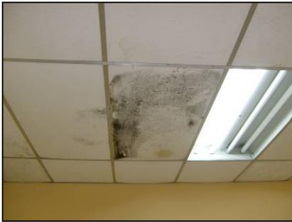
**Figura 103.** Presencia de goteras en el primer y segundo nivel. Esto genera daños en las láminas del cielo. Las luminarias funcionan bien salvo algunas.
