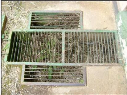
**Figura 123.** Se debe de realizar una limpieza de los colectores de agua pluvial exteriores, debido a que se llenan de maleza.
