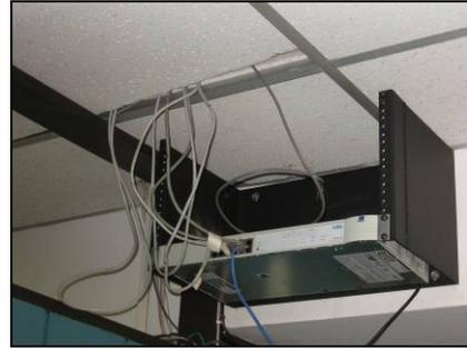
**Figura 13.** El sistema de red no está debidamente canalizado, por lo que el cableado pasa por las paredes o el piso.
