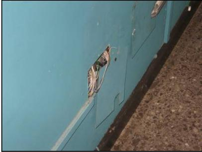
**Figura 26.** Las paredes internas necesitan pintarse como esta de admisión y registro. Los rodapiés y el piso de terrazo se encuentran bien. El rodapié está algo golpeado pero no desprendido.
