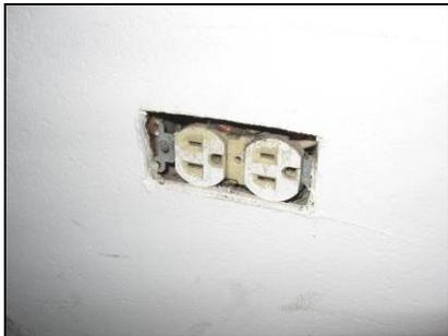
**Figura 37.** La falta de tapas para los tomacorrientes y otros elementos.
