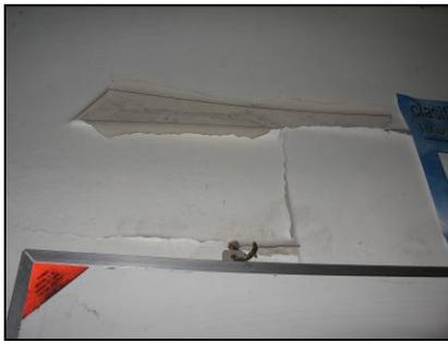
**Figura 65.** La pared interna del sector este presenta deterioro en pintura, la cual se está cayendo a pedazos. Esto es en la zona de la cocina. El resto se muestra en buenas condiciones.
