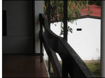
**Figura 56.** Una baranda del segundo piso del B1 se encuentra totalmente pandeada y se debe revisar si esto afecta su funcionalidad.
