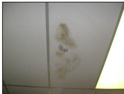
**Figura 117.** El agua se introduce por el techo y cae en los cielos del tercer nivel.
