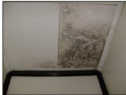
**Figura 83.** Las goteras son constantes en la escuela de diseño, se notan láminas de cielo manchadas o con hongos.
