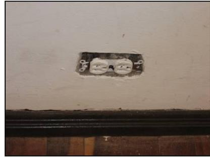
**Figura 73.** La ausencia de tapas en varios tomacorrientes se nota en la sala de danza.
