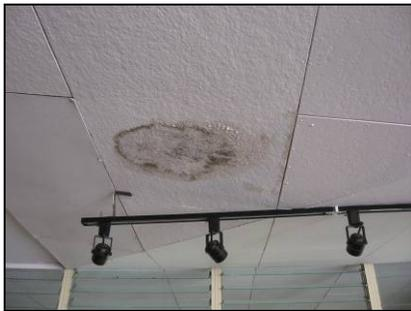
**Figura 71.** En el departamento de cultura hay un problema de una gotera lo cual daña las láminas de fibrolit del cielo.
