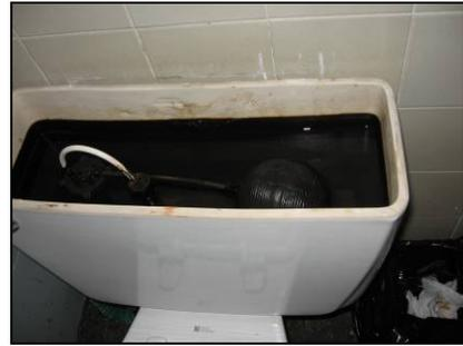
**Figura 38.** Los sanitarios del segundo nivel se muestran deteriorados en los tanques, lo cual los hace propensos a reventarse.
