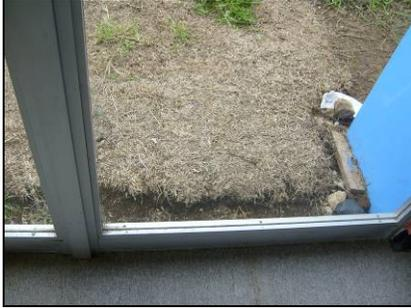
**Figura 109.** El agua de lluvia se introduce por los ventanales debido a que no se canaliza por completo por el desagüe pluvial. Se realizó una pequeña zanja alrededor pero el problema persiste.
