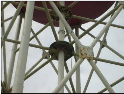
**Figura 99.** Partes de la estructura que soporta el tanque se encuentran herrumbradas o la pintura se ha desprendido por lo que la estructura se deteriora rápidamente.
