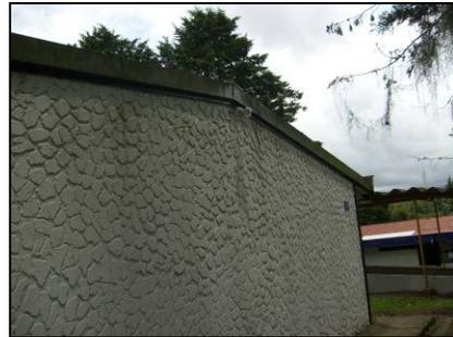
**Figura 137.** Las paredes exteriores están bien, la presencia de suciedad puede lavarse.
