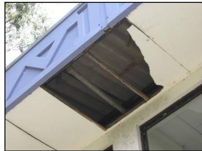
**Figura 62.** Lámina de cielo raso desprendida debido a problemas de humedad.
