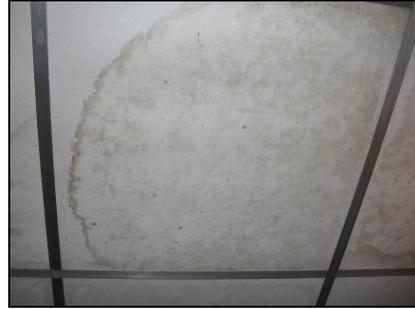
**Figura 29.** La presencia de este tipo de manchas indica que una gotera estuvo cayendo, si el problema se solucionó se debe pintar o sustituir la lámina dependiendo de su estado.
