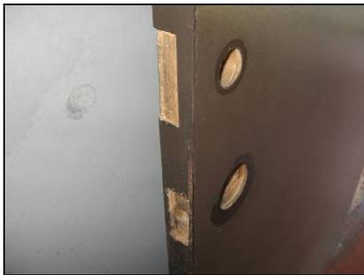
**Figura 59.** Algunas puertas de madera no tienen ningún tipo de cerrajería por lo que el aula siempre se mantiene abierta. La condición de las mismas es regular.
