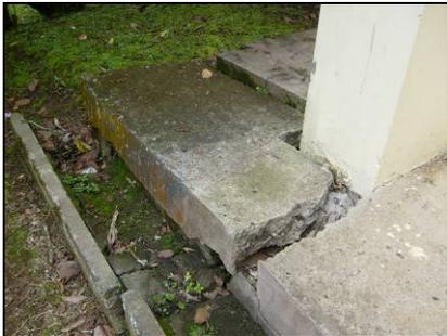
**Figura 132.** Ligeros asentamientos en la parte este del edificio ocasiona el agrietamiento de las aceras perimetrales.
