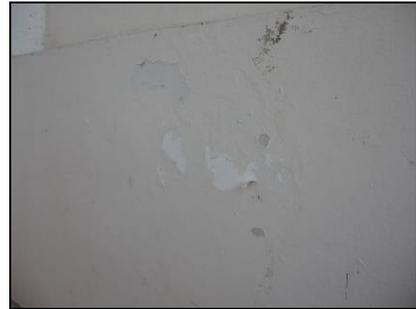
**Figura 50.** La pintura interna en general se encuentra bien salvo en ciertos sectores de pasillos o aulas en donde se nota el desprendimiento de la pintura.
