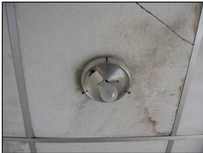
**Figura 23.** Las luminarias exteriores de bombillo funcionan adecuadamente, les falta los protectores correspondientes. El cielo se muestra manchado y quebrado en una esquina.
