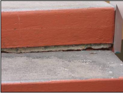
**Figura 5.** La última grada de abajo hacia arriba presenta un desprendimiento parcial y debido al ser la grada con la posición más alta es muy peligroso.
