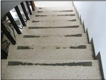
**Figura 95.** Los antideslizantes de las gradas se muestran muy deteriorados y desprendidos. Esto debido al intenso uso ya que en la parte superior se encuentran aulas.
