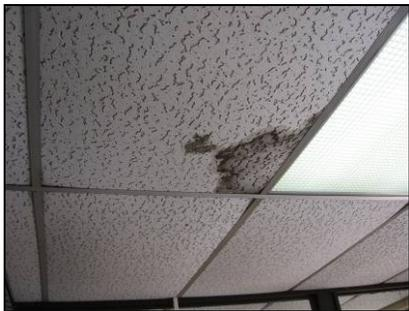
**Figura 7.** Los cielos son de fibra de 1.22m x 0.61m, con suspensión de aluminio. Se observa la presencia de goteras en varios sectores de todo el edificio.
