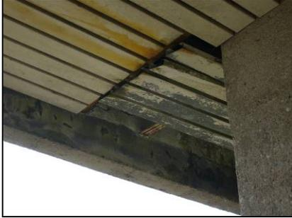
**Figura 118.** Los cielos de los aleros son metálicos y presentan gran deterioro debido al agua de lluvia.
