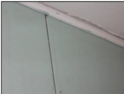
**Figura 66.** En las oficinas del sector este se introduce el agua a través de las paredes generando deterioro de las mismas.
