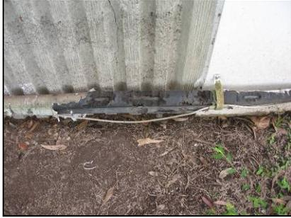
**Figura 41.** Las tuberías de los aires acondicionados se encuentran con el recubrimiento caído a lo largo de su recorrido.
