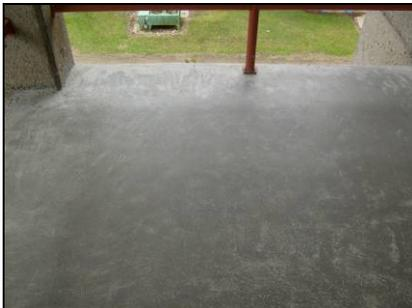
**Figura 120.** Acabado de cemento lujado en los niveles superiores debido al problema presentado en la figura 112, en donde se desprendieron varias piezas.
