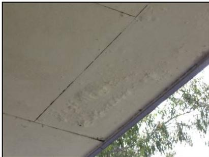
**Figura 54.** Los cielos cercanos al perímetro presentan abombamientos. Indicando su estado.
