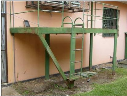
**Figura 122.** Las estructuras metálicas exteriores presentan deterioro.
