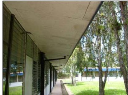
**Figura 93.** Los aleros exteriores se notan deteriorados y con manchas de humedad debido a la acción del clima.
