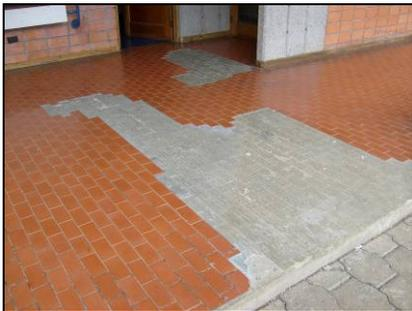
**Figura 112.** Al piso del primer nivel se le han desprendido piezas, en los niveles dos y tres ya fue completamente removido.
