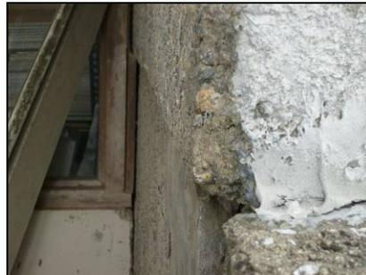
**Figura 115.** Desplazamiento transversal de las paredes del último nivel, por donde se introduce el agua y ocasiona que las paredes livianas internas se aflojen.
