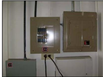
**Figura 92.** El centro de carga se encuentra en excelentes condiciones, con sus respectivas tapas y los disyuntores ajustados.
