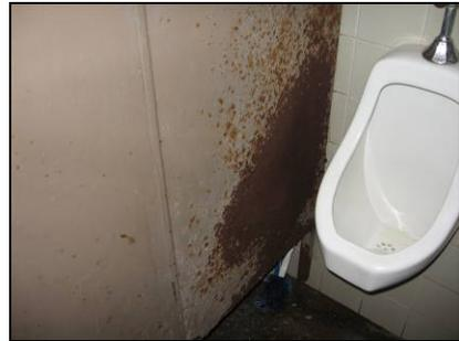
**Figura 30.** Las divisiones metálicas de los baños del primer nivel se encuentran herrumbadas, lo cual le ha ocasionado daños severos.
