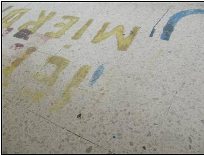
**Figura 94.** El piso de terrazo se encuentra en buenas condiciones. Presenta manchas de pintura solo en la sección del corredor frente a la FEITEC.
