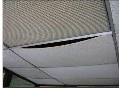
**Figura 8.** Hay cielos cóncavos y torcidos en la vicerrectoría de investigación y extensión. Cabe destacar que las láminas fueron recientemente instaladas debido a su deterioro.
