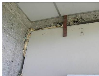
**Figura 116.** Paredes internas livianas del tercer nivel, las cuales se han aflojado y se pueden caer. Se han tenido que calzar con papeles para evitar su desprendimiento.
