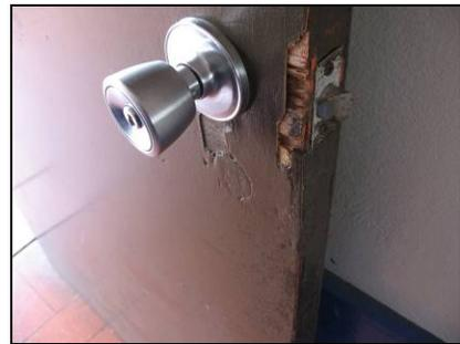
**Figura 51.** Las puertas de madera de las aulas no especializadas presentan problemas con sus cerraduras y su deterioro es muy notable.
