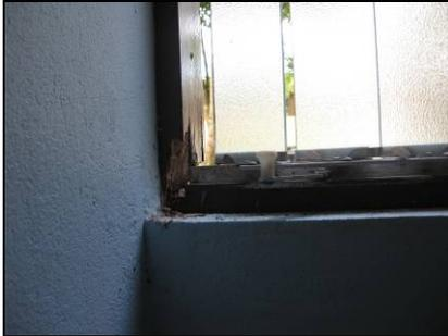
**Figura 15.** Los marcos de madera se encuentran bien salvo en el primer nivel. Se nota que la humedad está causando que la madera se deteriore.
