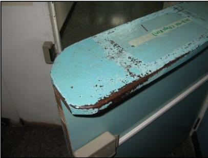
**Figura 27.** Algunas puertas de madera de admisión y registro están deterioradas y necesitan mantenimiento.
