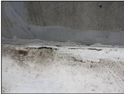
**Figura 42.** Se muestra el sello colocado en la junta para controlar la infiltración de agua al laboratorio del CIC.
