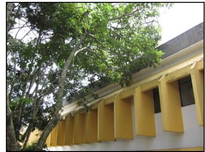
**Figura 25.** La inundación ocurrida se debió a la acumulación de hojas de árboles cercanos al edificio, generando la obstrucción del sistema pluvial.
