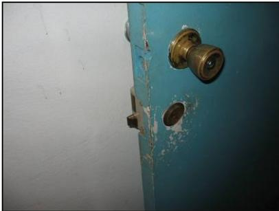
**Figura 16.** Algunas puertas de madera del segundo nivel se notan deterioradas debido a su uso. Tienen bastante tiempo sin pintar.
