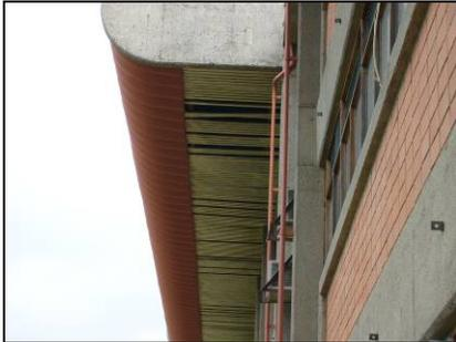
**Figura 119.** Varias piezas metálicas de estos aleros se han desprendido alrededor de todo el edificio.
