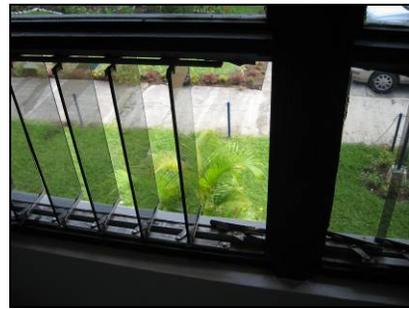
**Figura 9.** Los faltantes de varias celosías se aprecia a lo largo del edificio. Además muchas se encuentran trabadas y no se pueden abrir, puede ser debido a la suciedad.
