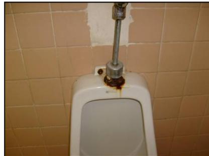
**Figura 108.** Ciertas piezas de los orinales y sanitarios se encuentran deterioradas o herrumbradas por lo que deben sustituirse.
