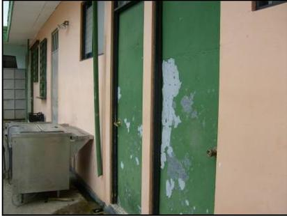
**Figura 121.** Las paredes exteriores y puertas muestran la necesidad de realizar una pintura general exterior.
