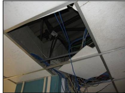
**Figura 19.** Los cielos son de fibrolit con suspensión de aluminio, en el tercer nivel están muy deteriorados debido a una inundación. Se notan manchados, quebrados y faltantes.
