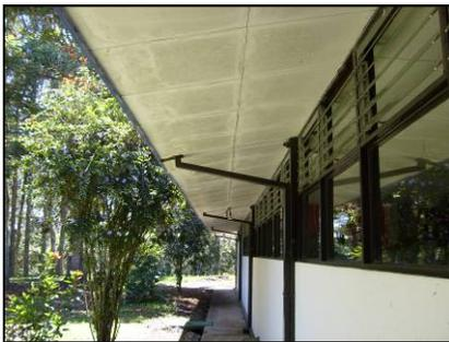
**Figura 72.** Los cielos de los aleros exteriores se muestran desgastados y en ciertas partes cercanas a los bajantes hay muestras de hongos y humedad.
