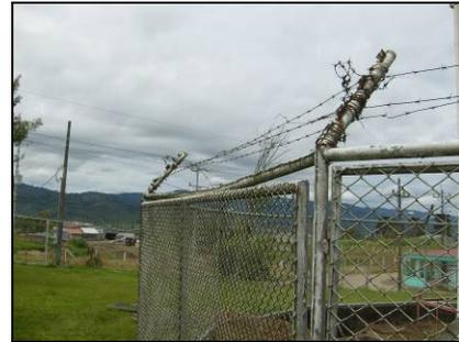
**Figura 102.** La malla ciclón que rodea al tanque se encuentra deteriorada, además el alambre de púa en ciertos tramos se ha desprendido o caído.
