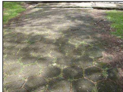
**Figura 138.** Las aceras externas de adoquienes tienen maleza en sus juntas.
