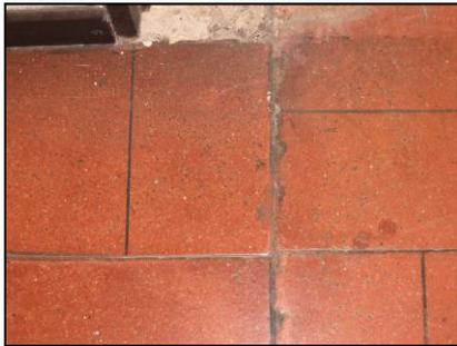
**Figura 64.** El piso está deteriorado debido a los diversos usos que ha tenido el edificio a lo largo de su vida. Presenta ciertos huecos y golpes.
