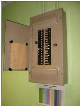
**Figura 11.** Los centros de carga se encuentran en buen estado, tanto la caja como los disyuntores están socados.
