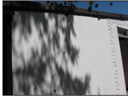
**Figura 67.** Pared exterior del sector este, se encuentran en buen estado se ha repellado pero aún así el agua se introduce dentro de las oficinas.
