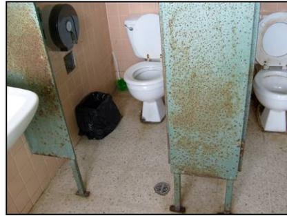
**Figura 96.** Las divisiones metálicas de los sanitarios del segundo nivel se encuentran muy herrumbradas mostrando un aspecto poco agradable.
