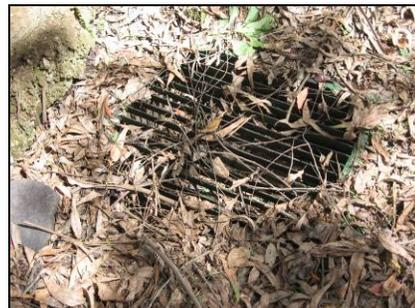
**Figura 57.** Algunas rejillas colectoras de agua pluvial cercanas a los edificios se encuentran obstruidas por hojas y sedimentos que llegan a ellas.
