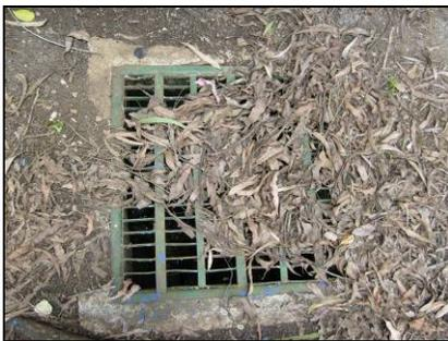
**Figura 110.** Algunas rejillas de recolección de agua pluvial en la parte trasera se encuentran con hojas o sedimentos. Además el estado de algunas no es muy bueno.
