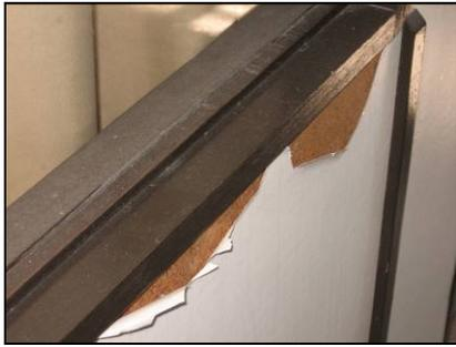
**Figura 36.** Las divisiones internas presentan deterioro. En la escuela de física se le ha desprendido el recubrimiento y se encuentra abombado. Algo similar en la escuela de matemática.
