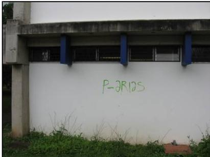
**Figura 33.** Las paredes externas necesitan una limpieza debido a la suciedad, además en un sector se encuentra rayada. Las partes de concreto expuesto están con hongos por lo que deben limpiarse también.
