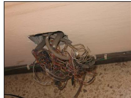
**Figura 14.** En ciertos lugares el cableado telefónico no está debidamente colocado, falta de tapas.
