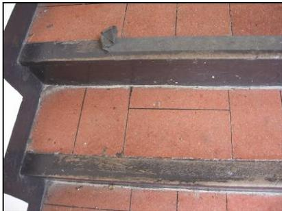
**Figura 49.** Los antideslizantes colocados en las gradas se han desprendido o están a punto de hacerlo. La mayoría de escalones no tienen el antideslizante.
