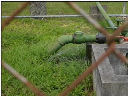
**Figura 101.** El día de la visita se encontró una fuga de agua en la válvula adyacente al tanque. Se nota que esta tubería expuesta necesita un poco de limpieza.
