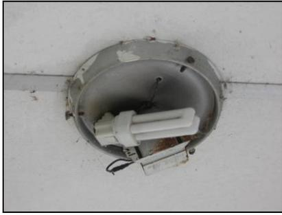
**Figura 32.** Las luminarias externas funcionan bien, solo les falta los protectores correspondientes.
