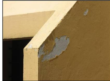
**Figura 24.** Las paredes exteriores necesitan pintarse. Como se muestra, hay un desprendimiento de la pintura. Además hay suciedad de polvo y hongos en la primera y segunda planta.
