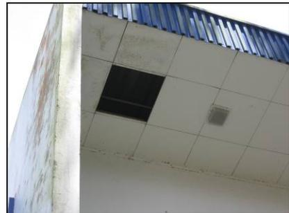
**Figura 40.** Las paredes exteriores necesitan pintura ya que se nota su deterioro. Además los cielos de los aleros se notan algo manchados debido a agua.
