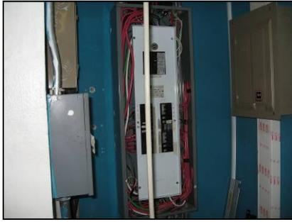
**Figura 21.** El centro de carga del segundo nivel se encuentra en buen estado. Le falta colocar la tapa respectiva y la señalización adecuada.
