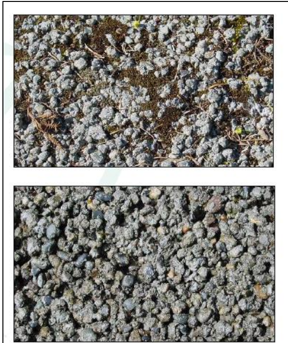
Fig.9. Aspecto del concreto permeable antes y después de darle mantenimiento Fuente: Concreto Permeable, NRMCA, ASTM
