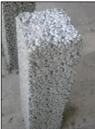
Fig 39. Acabado de vigas mezcla 2 (M2)
