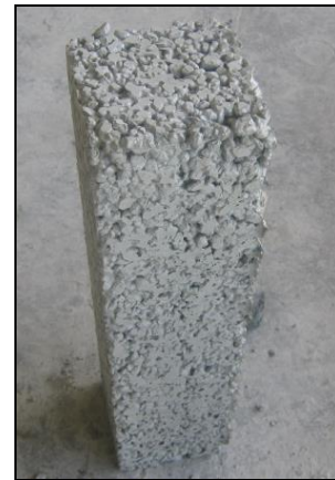
Fig 49. Acabado de vigas mezcla óptima
