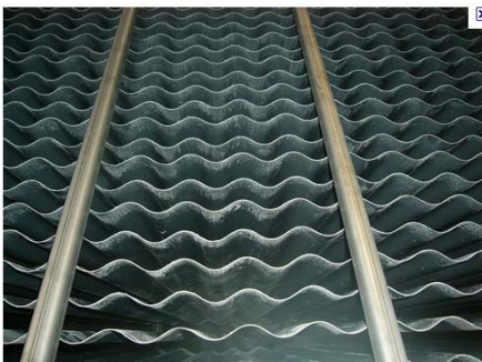
Figura 44. Pantallas lamelares
