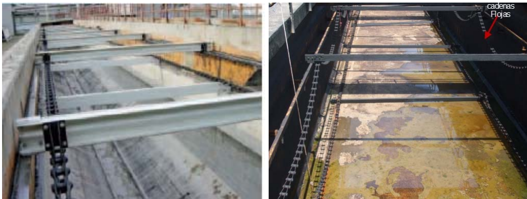
Figura 57. Cadenas del Separador API de RECOPE vrs Cadenas bien ajustadas
