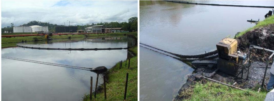
Figura 12. Laguna de oxidación
