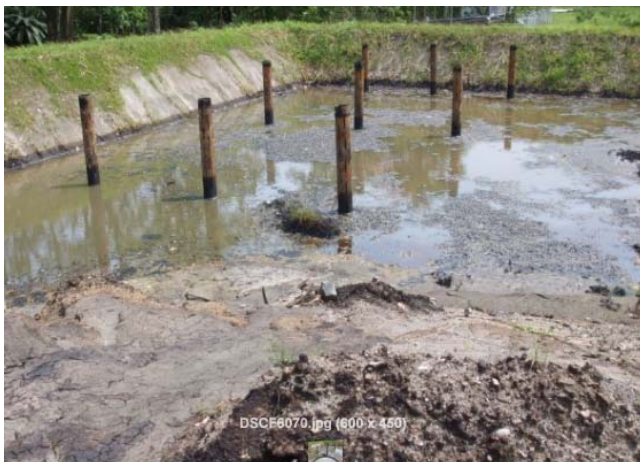
Figura 63. Lechos de Secado de la empresa
