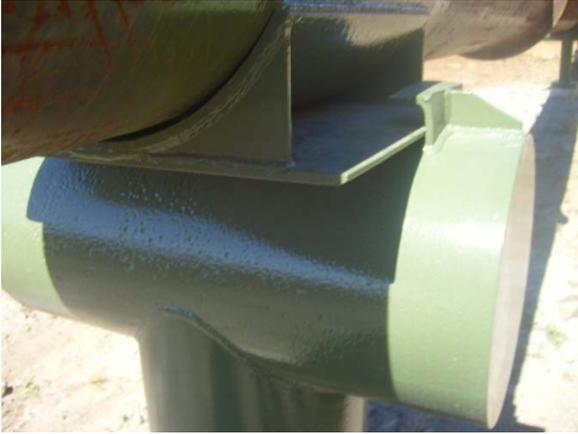
Figura 4. Estructura de apoyo tipo guía.
