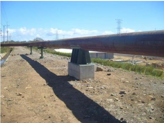
Figura 5. Estructura de apoyo tipo anclaje.
