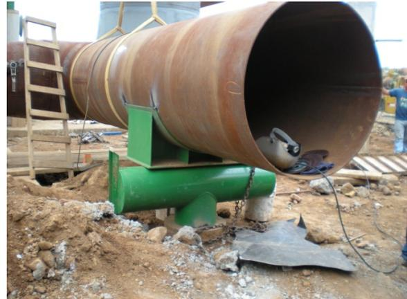
Figura 3. Estructura de apoyo tipo soporte.
