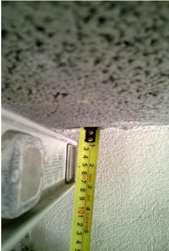
**Figura N°38. Medida de la deformación del cielo en la casa 8-H.**
