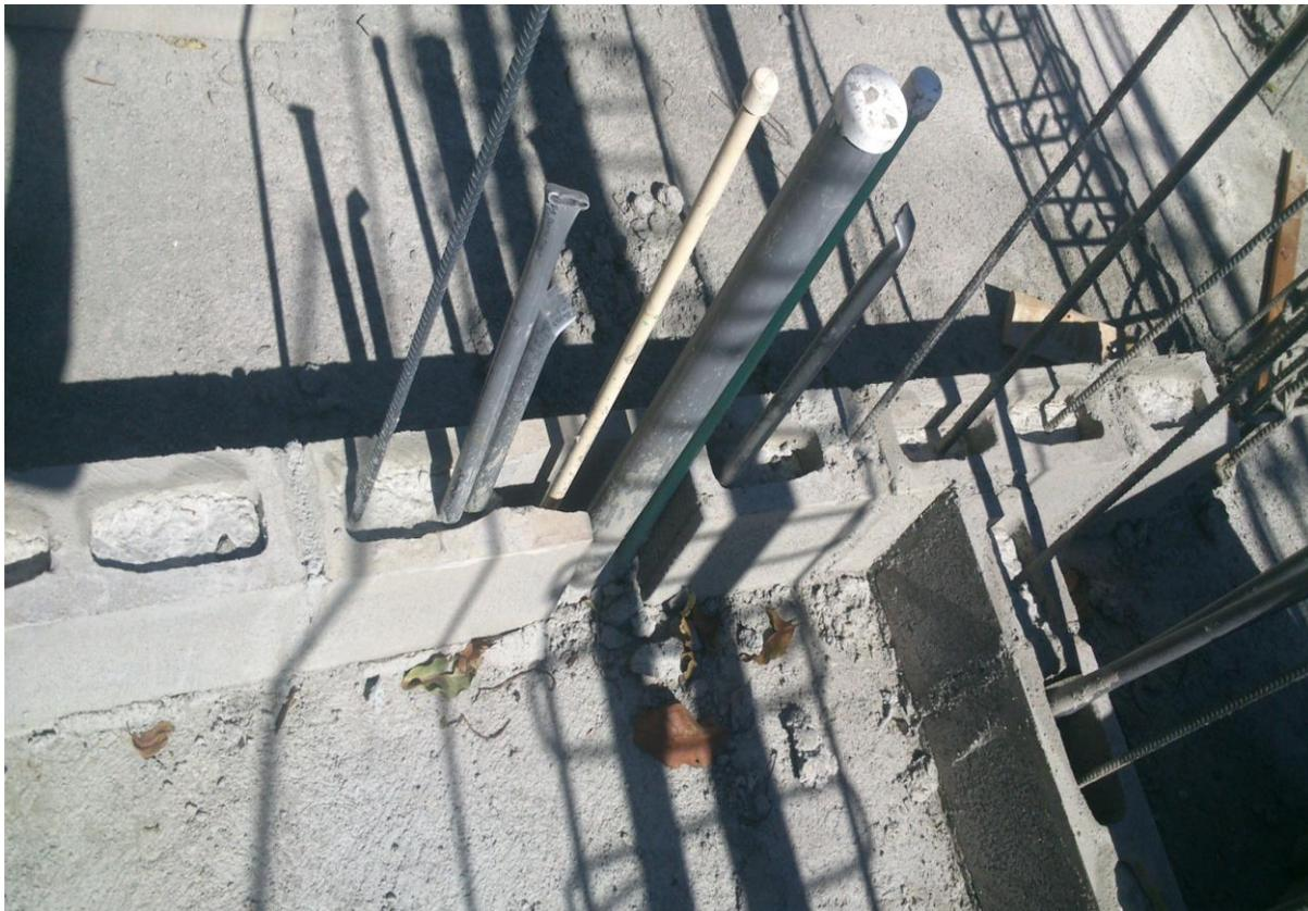
Figura N°35. Block cortado en la primera hilada.
