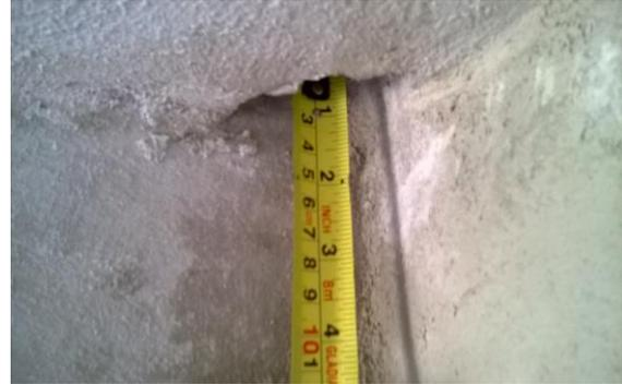
**Figura N°39. Relleno del cielo en la Casa 17-A**
