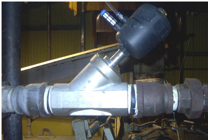
Figura # 3.14. Válvula Automática Burkert
