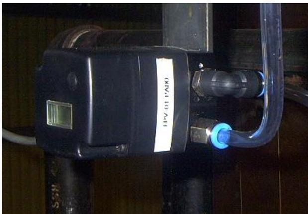
Figura # 3.15. Válvula Piloto de Presión
