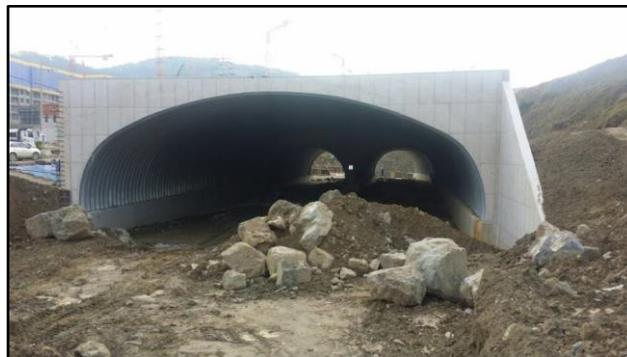
**Ilustración 3:** Alcantarilla Circular de Arco.
