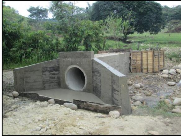
**Ilustración 2:** Alcantarilla Circular con Cabezales y Aletones.
