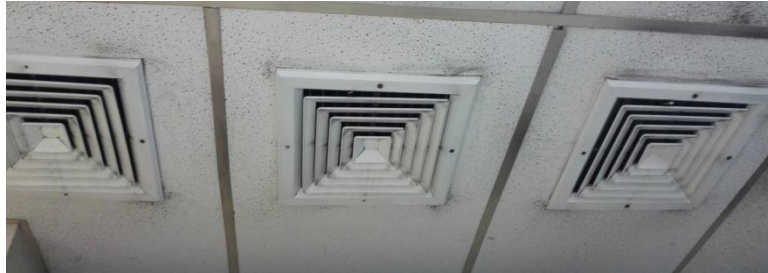
Figura 4. 12. Distribución actual de las rejillas de inyección en la morgue.
