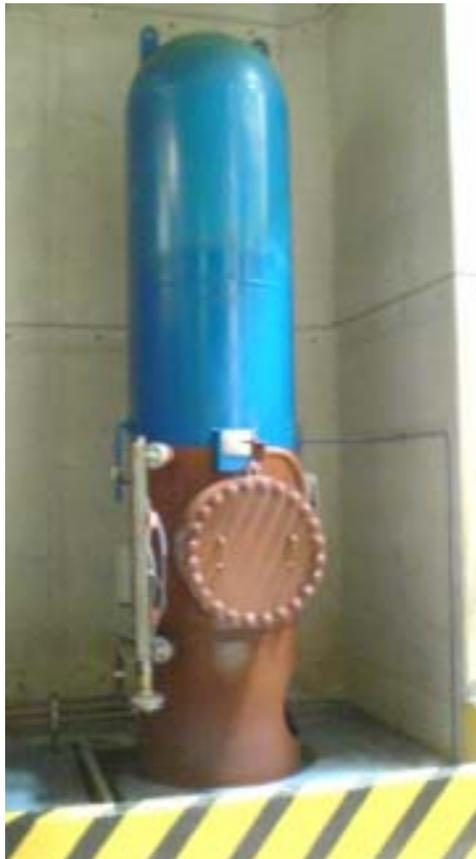
**Figura 4.** Tanque hidroneumático.
