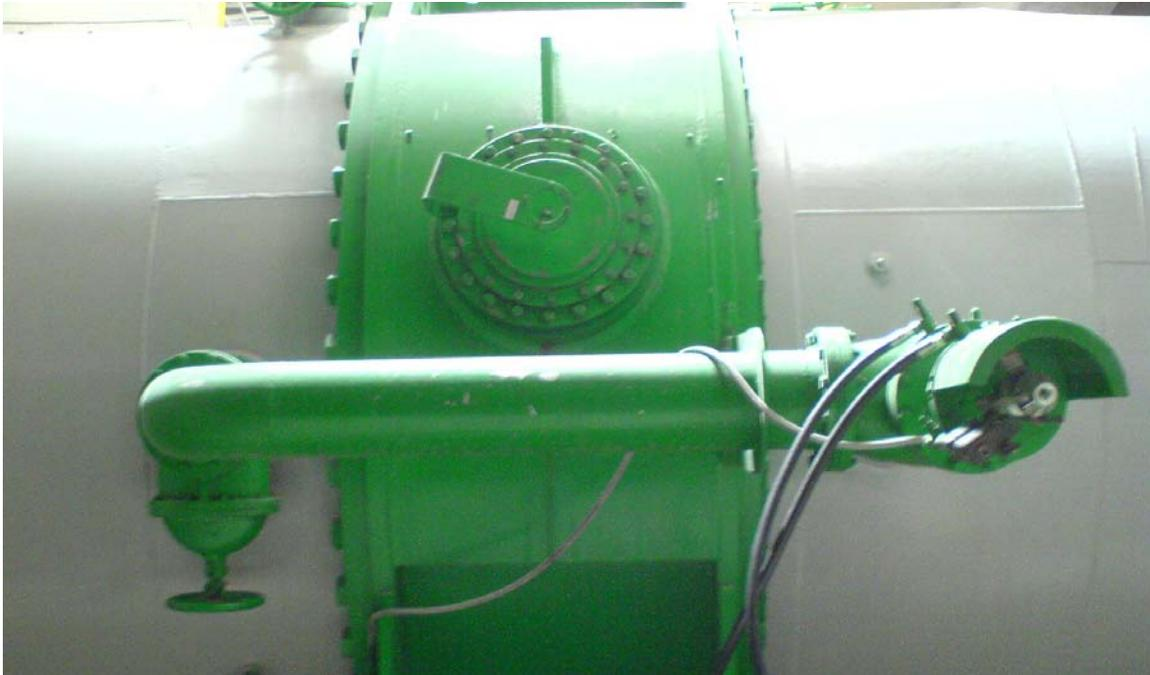
**Figura 3.** Válvula de bypass.
