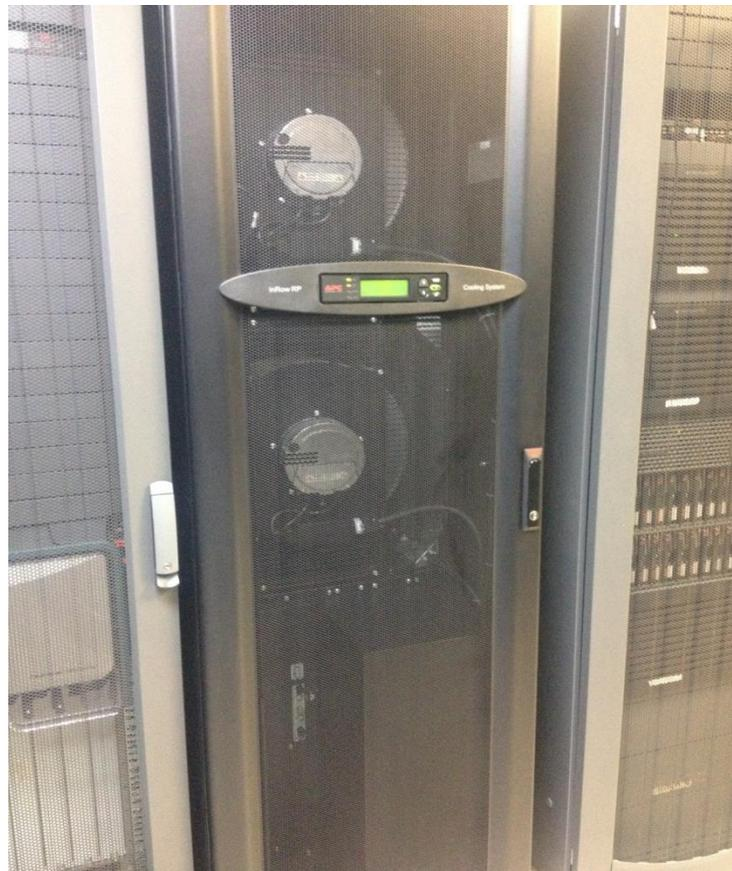
**Figura 13. Unidad de aire acondicionado de precisión del centro de datos del INA.**
