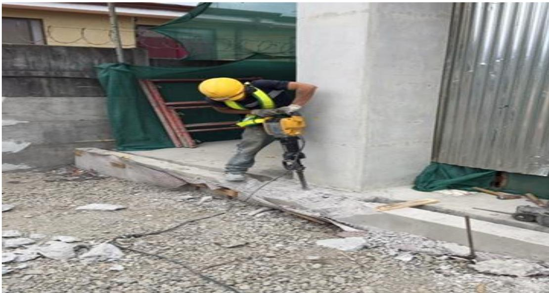
**Fotografía 4.** Trabajador realizando en la demolición de un muro de retención por un error estructural en su construcción.
