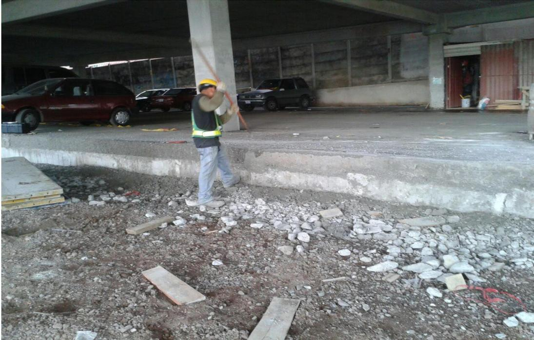
**Fotografía 7.** Retrabajo realizado en muro del nivel 0+00 de Plataforma de Parqueos.
