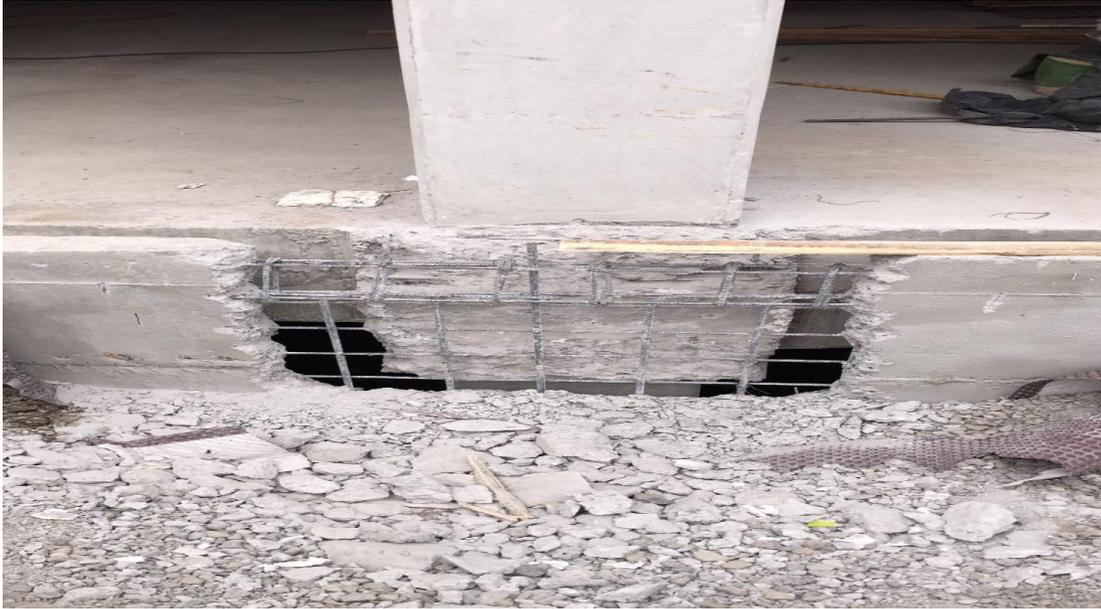
**Fotografía 5.** Sección del muro que se picó, ya que debe tener una junta de construcción entre el muro de retención y el nudo de la columna cercana a este, para que tengan un comportamiento estructural por separado.
