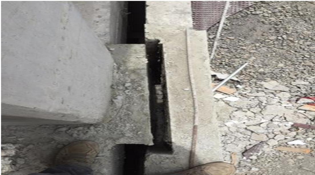
**Fotografía 6.** Resultado final del retrabajo realizado en el muro de retención
