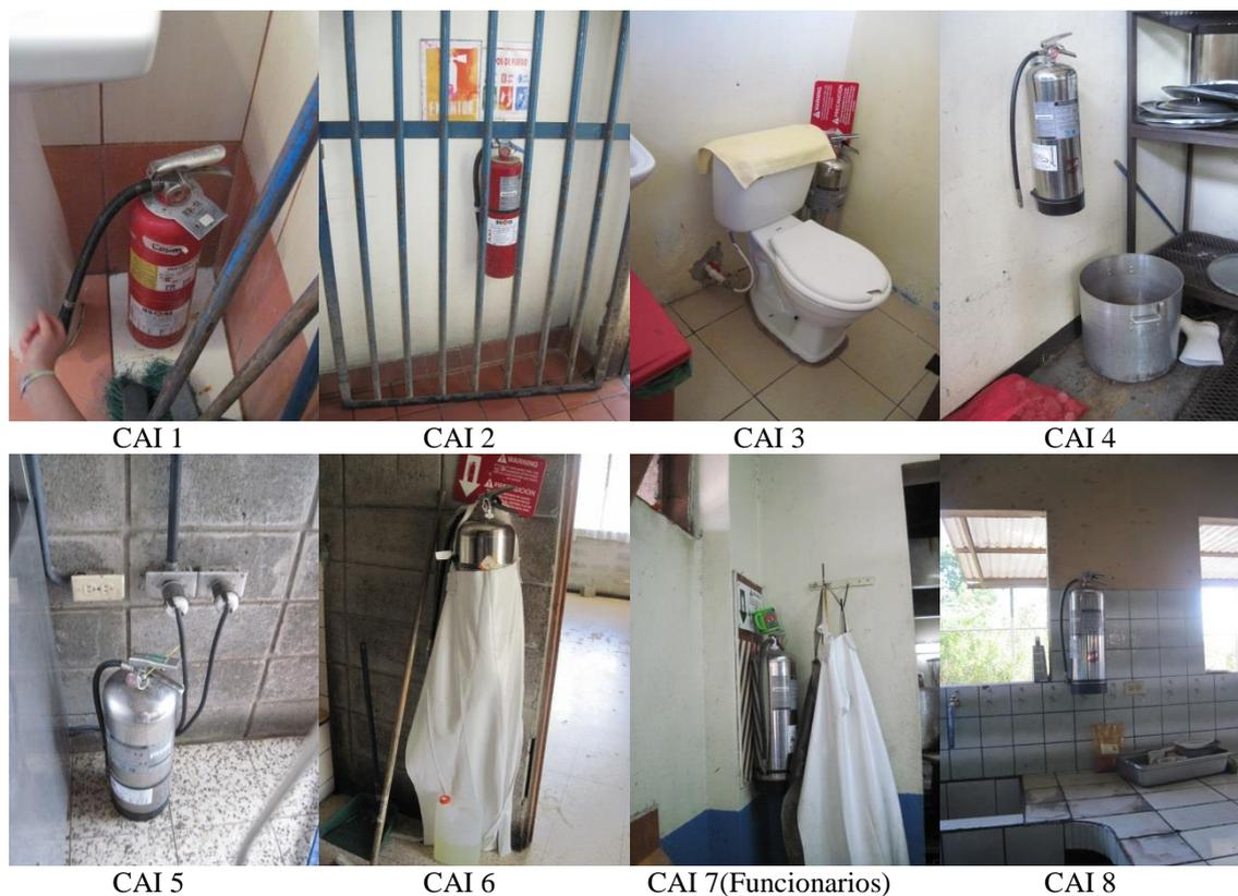
**Figura 36. Condiciones de los extintores portátiles en cocinas**
